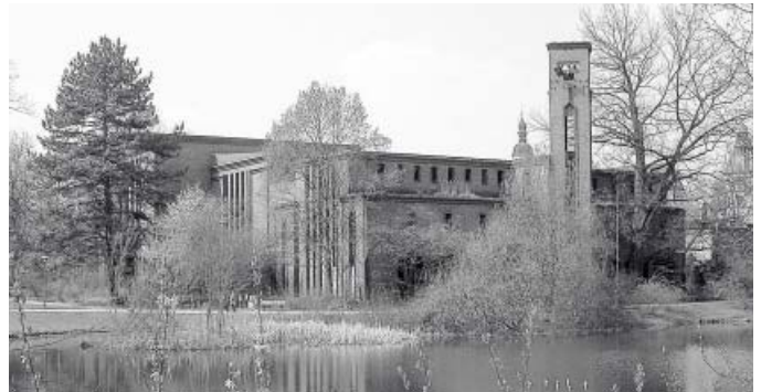
Das Dieselkraftwerk am Amtsteich.
