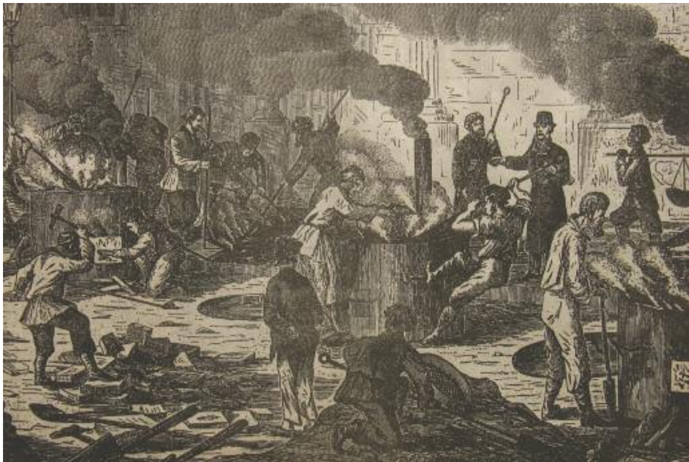
На укладке асфальтовой мостовой в Санкт-Петербурге (первая половина XIX в.)
