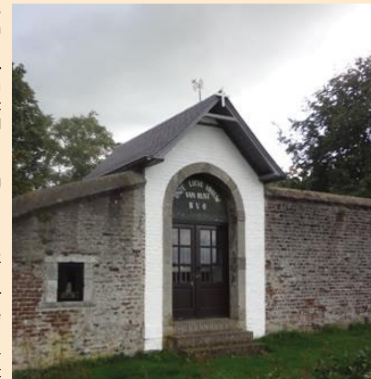
De Kapel van OL Vrouw van Rust, voorzien van een nieuw leien dak
