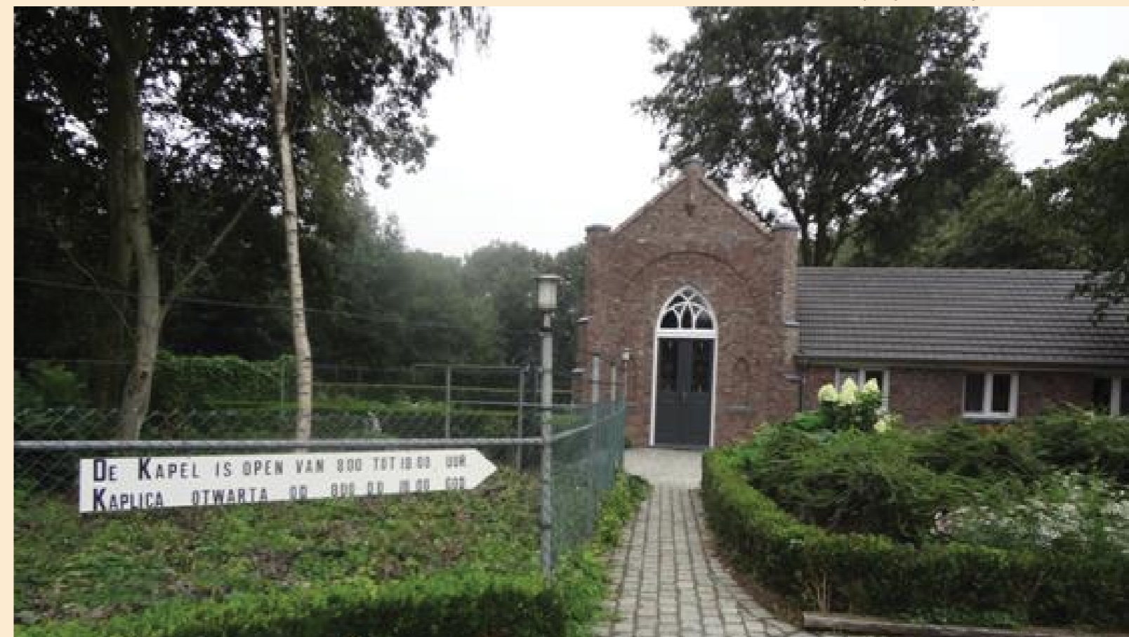
De Bulthoeve-kapel, gebouwd tegen het bakhuis
