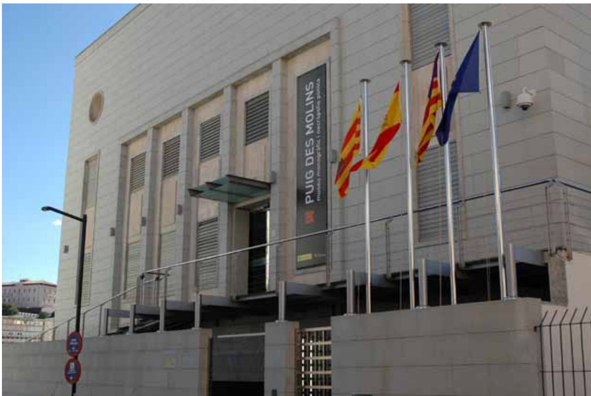
Fig. 2. Fachada del estado actual del Museo Monográfico del Puig des Molins.
