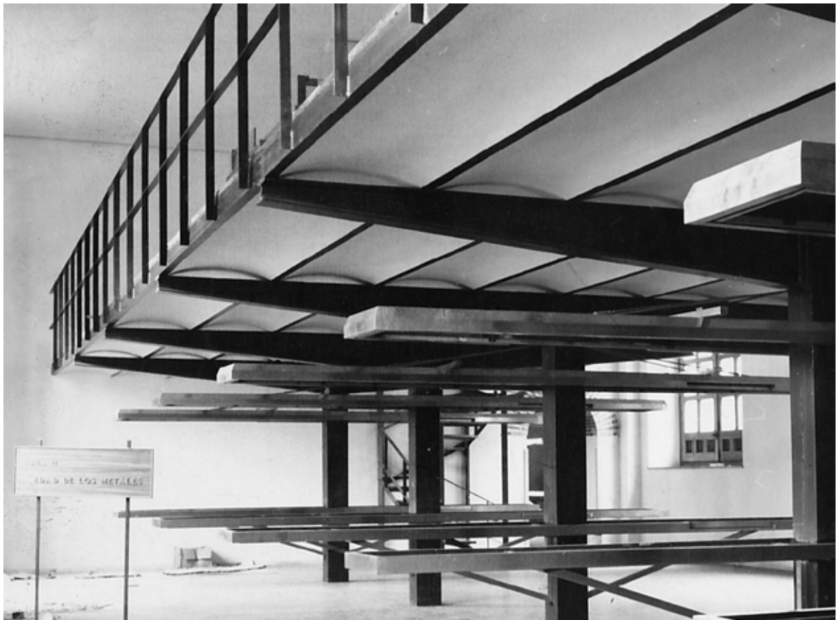
Fig. 3. Ejecución de entreplantas e instalación de vitrinas en la Sección de Arqueología, año 1969. Foto: Archivo del Museo de Jaén.
