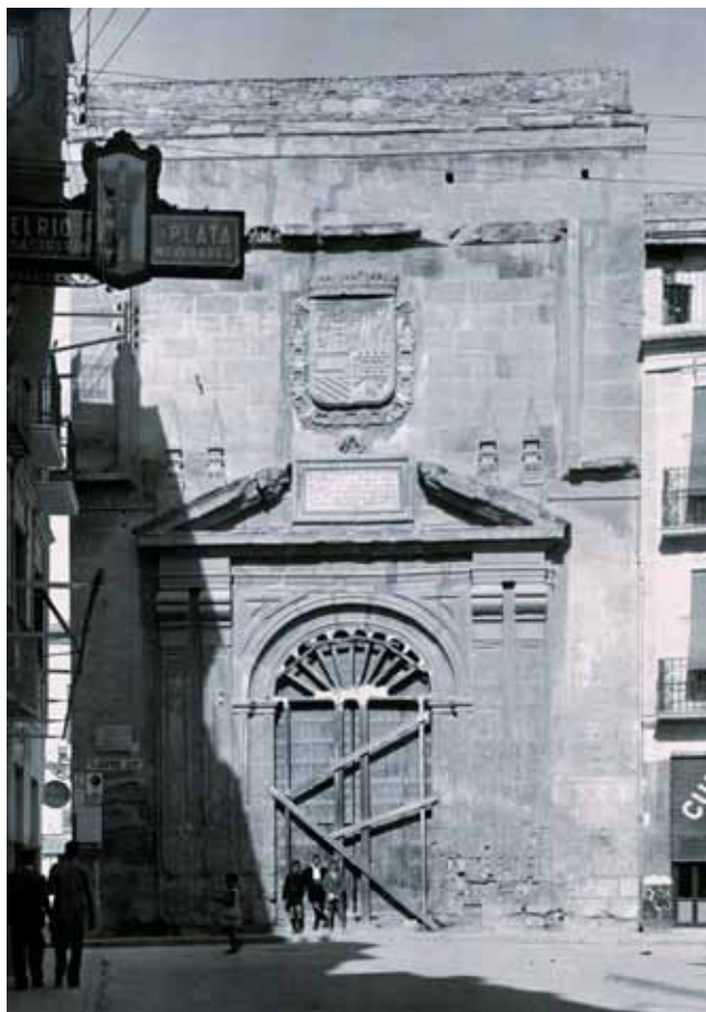
Fig. 1. El edificio del Contraste antes de su demolición en la década de los 30 del siglo XX. Archivo fotográfico del Museo de Bellas Artes de Murcia.
