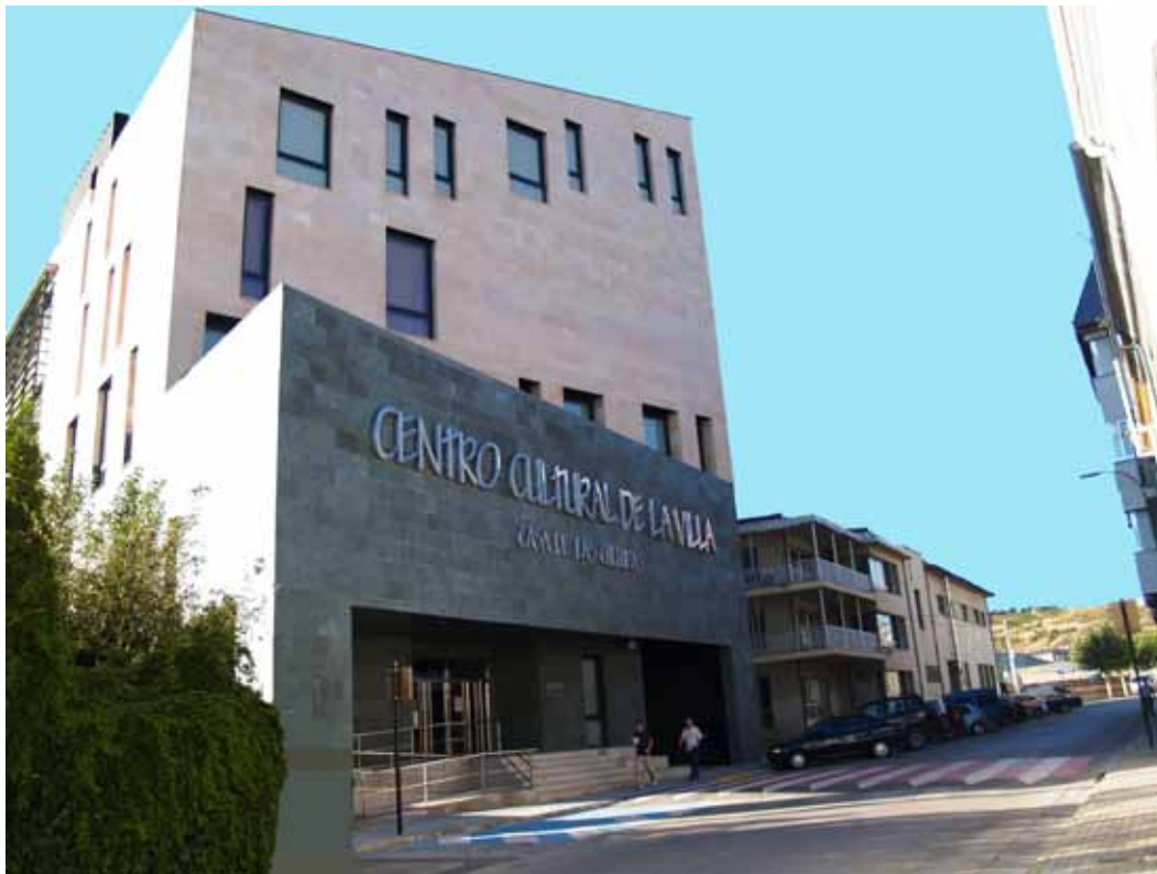
Fig. 4. Centro Cultural de la Villa Casa de las Culturas.
