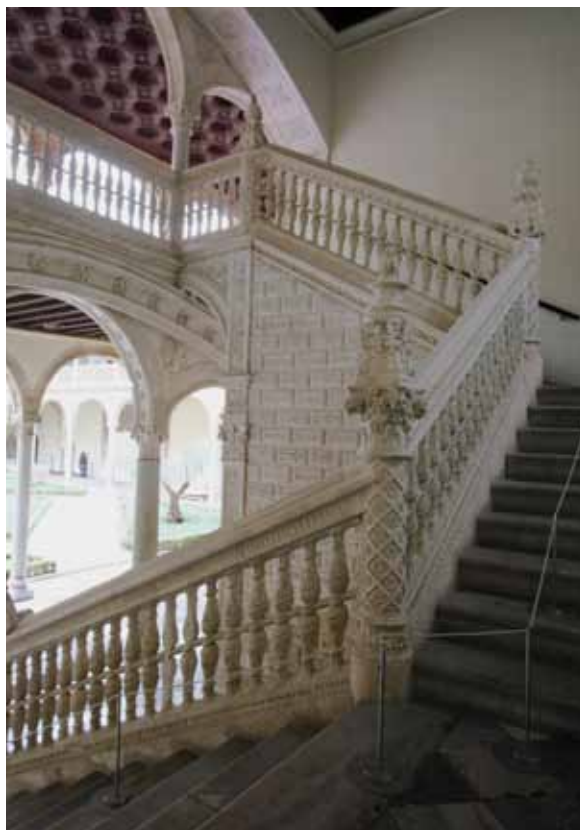
Fig. 3. Escalera monumental construida por Alonso de Covarrubias.
