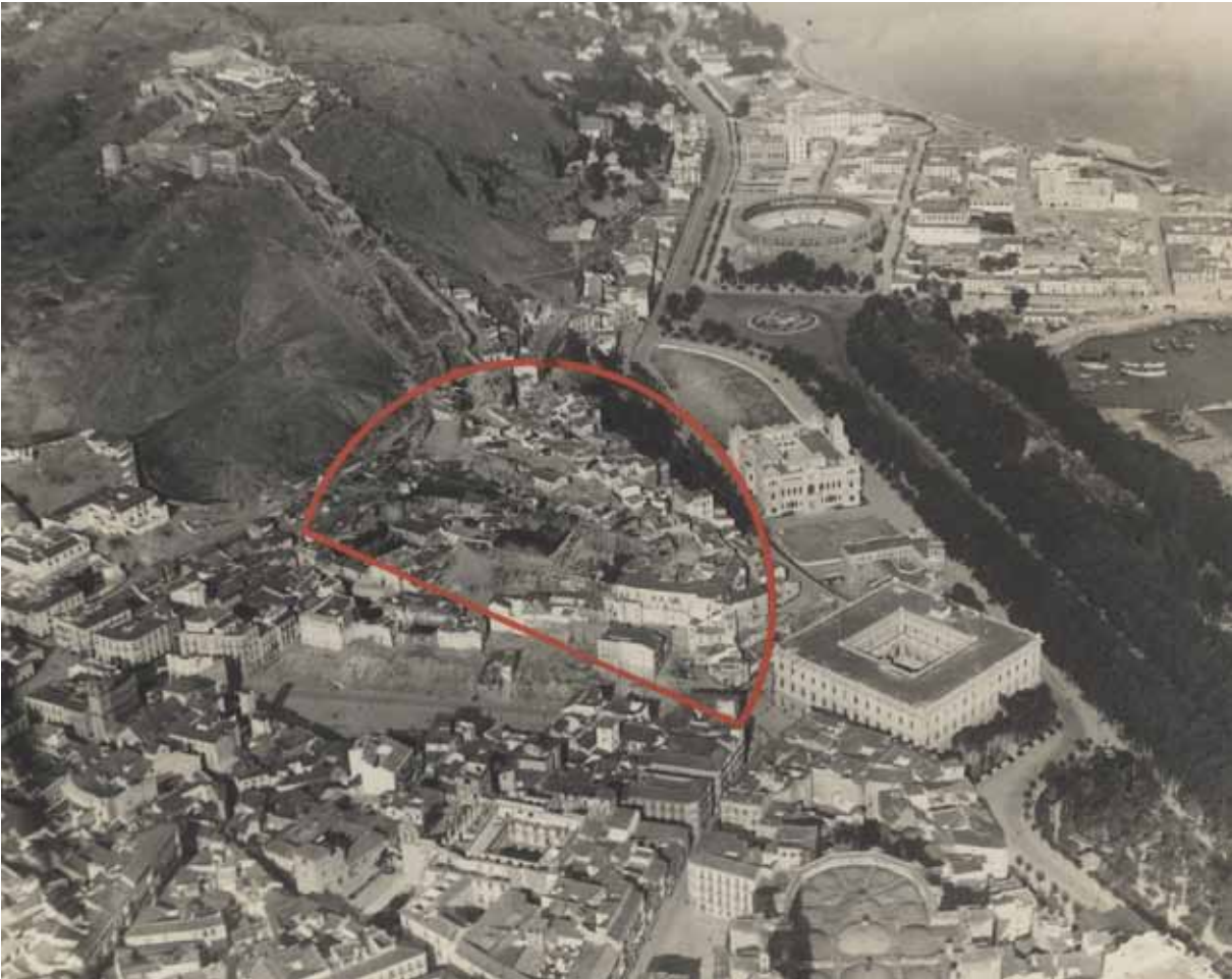
Fig. 1. 1937. Ámbito de la actuación del proyecto de reconstrucción de la Alcazaba. Málaga. Álbum fotográfico del arquitecto Fernando Guerrero Strachan. Museo de Málaga.
