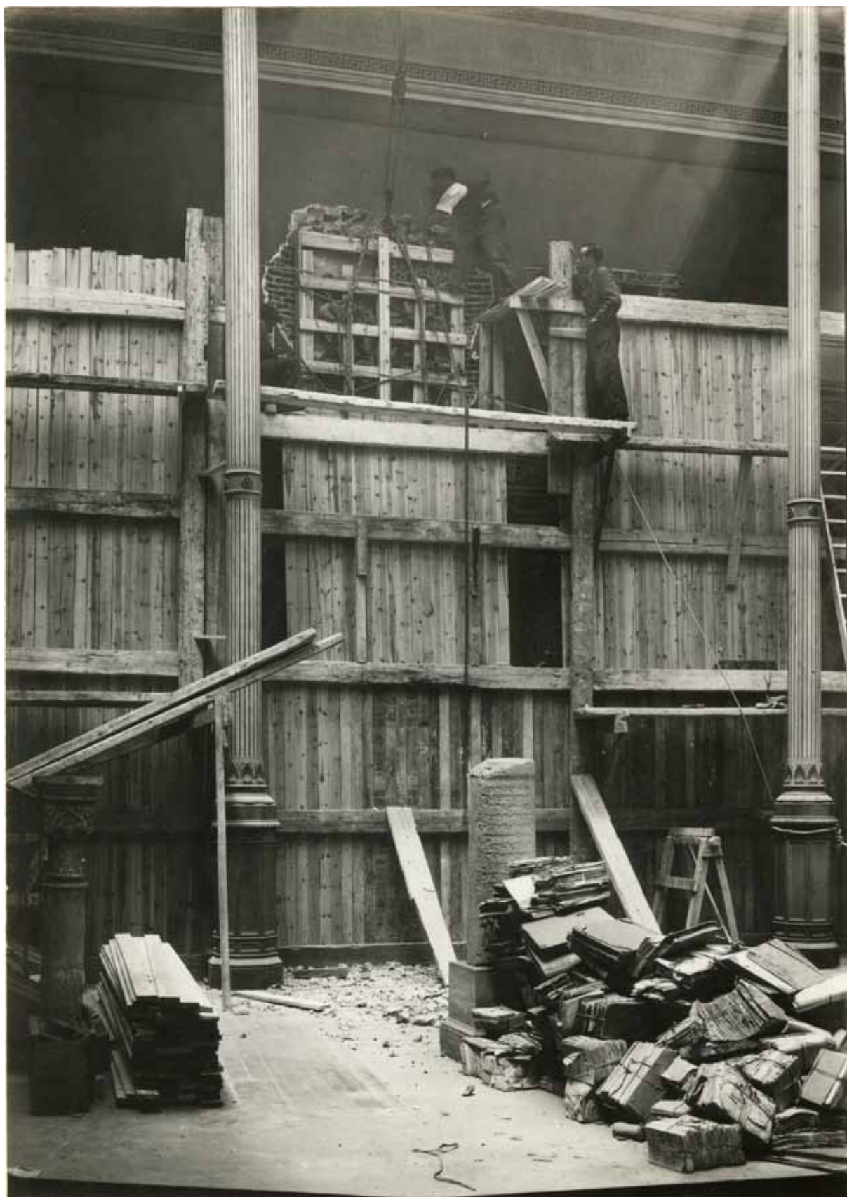
Fig. 8. Protección de los arcos del Patio Árabe durante la Guerra Civil. Foto: Archivo MAN.
