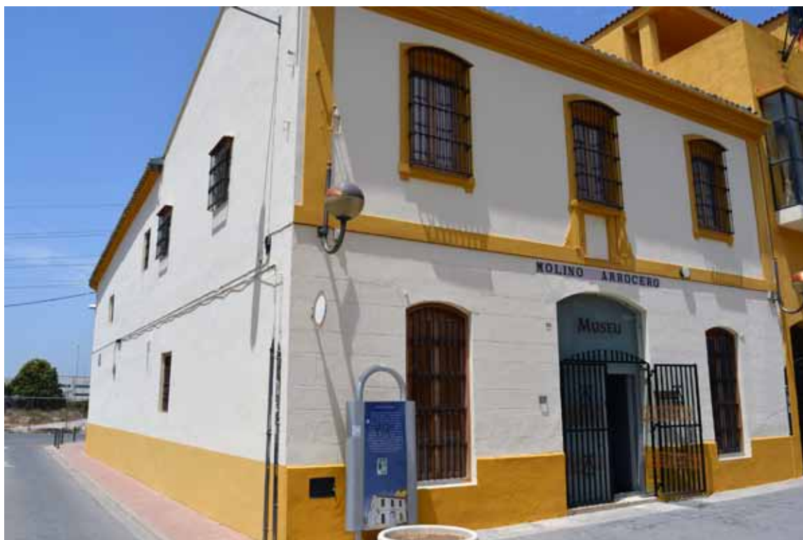
Fig. 1. Fachada principal del edificio del Museo.
