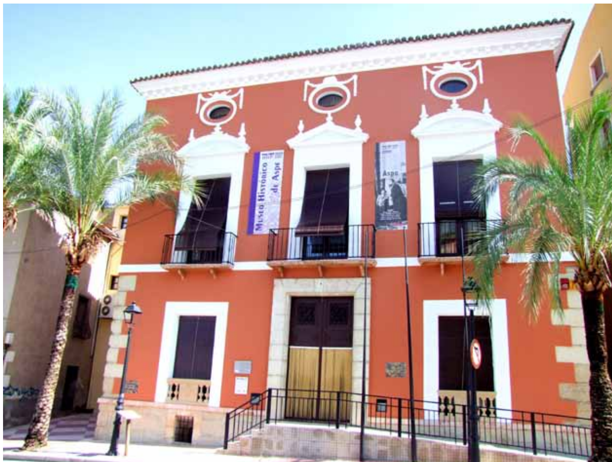
Fig. 1. Fachada principal del MHA.
