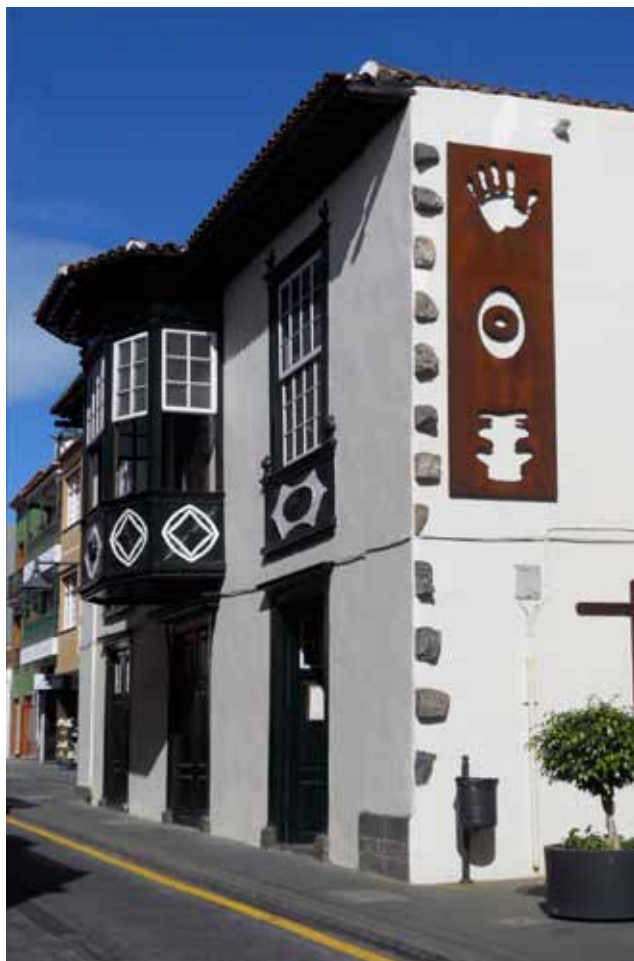
Fig. 3. Edificio sede del Museo.
