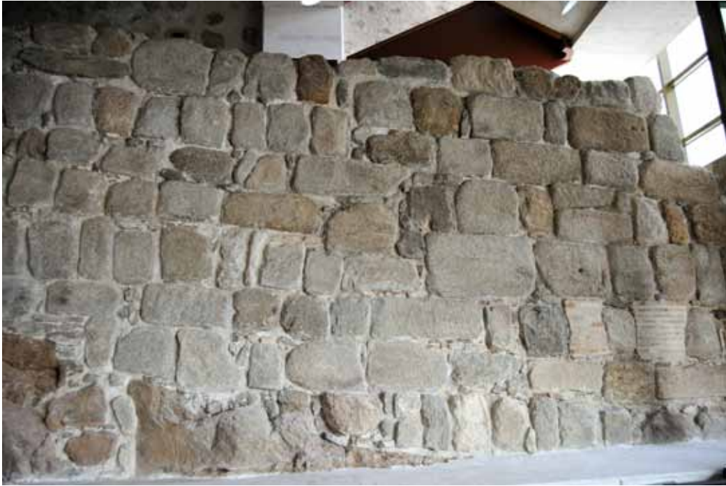
Fig. 3. Muro islámico exterior.
