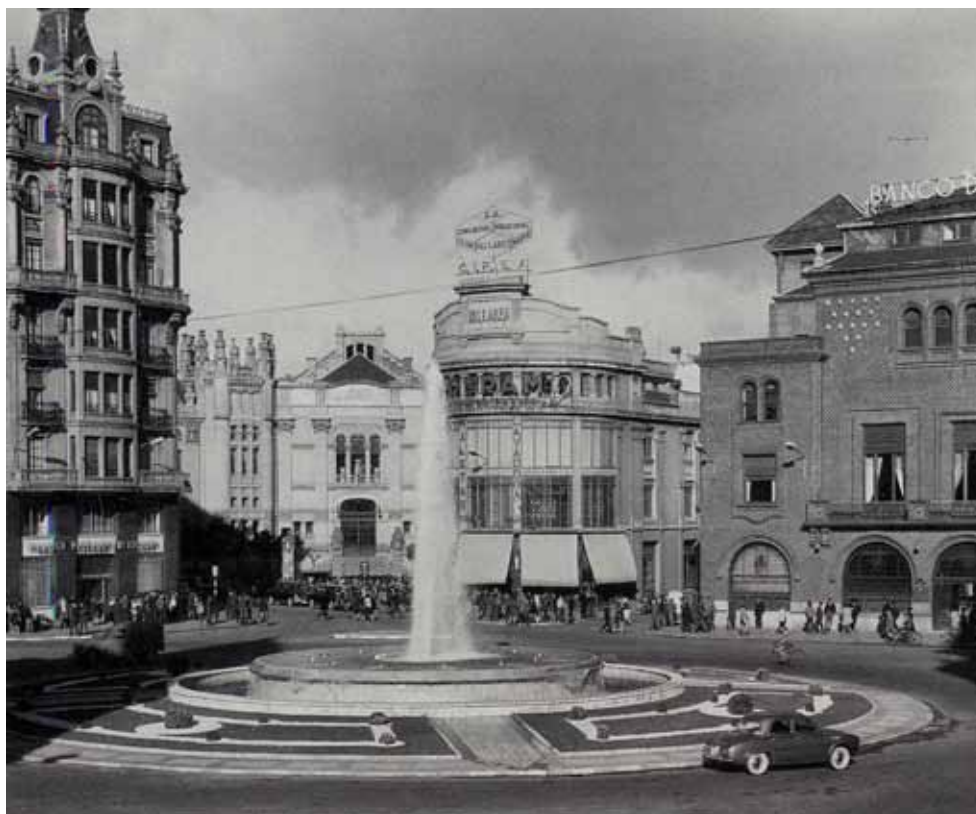
Fig. 6. El edificio «Pallarés», antiguos almacenes comerciales en el centro de la ciudad.
