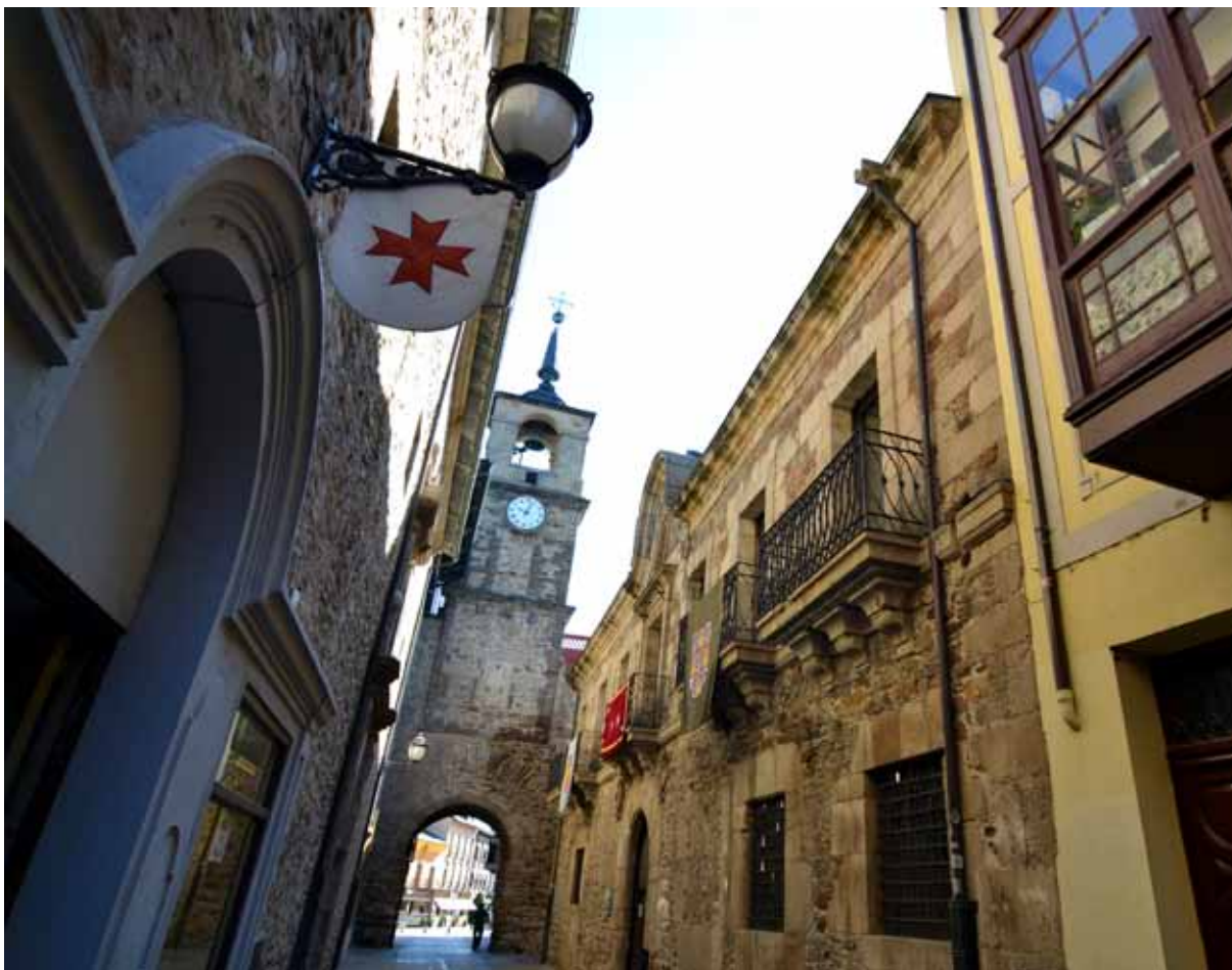
Fig. 1. Fachada principal del Museo del Bierzo a la calle del Reloj. Foto: Francisco Javier García Bueso.
