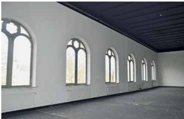
Die Galerie im Obergeschoss des Augusteums vorher und nachher.
