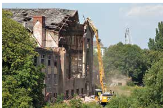
Abbruch Südzentrale. Foto: WZ-Bilddienst
