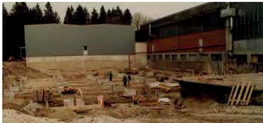
Hallenbau für Langsiebanlage 3+4
