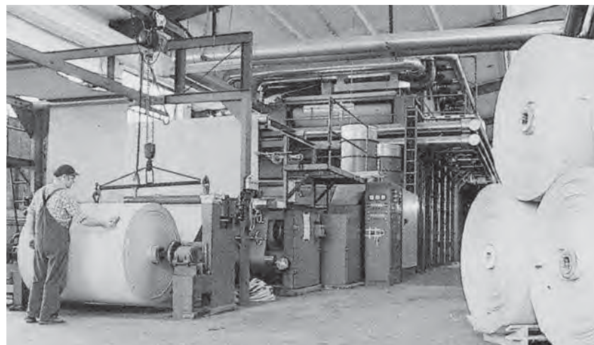
Langsiebanlage in der Lefa-Produktion
