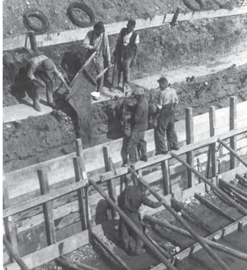
Bau von Wehranlagen bei Türkheim
