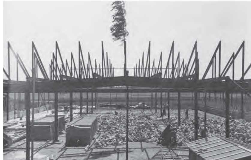
Ende 1940er Jahre: Bau von Shedbauten
