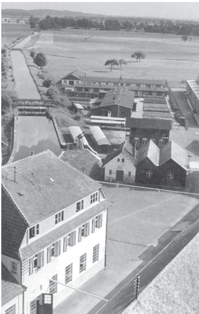
Verwaltungsgebäude SBL, Wohnheime, Schreinerei und Kanal
