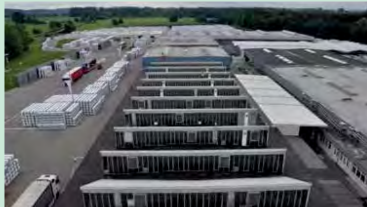
Shedbauten auf dem Salamander-Gelände in Türkheim
