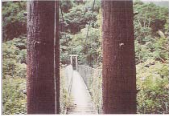
照片 31 黃麻一號吊橋(9.8K)現況
