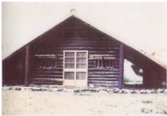
照片 33 瓦拉米(14K)新建山屋現況及腹地
