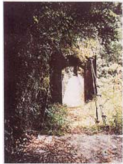
照片 28 山風一號吊橋(1.7K)現況及腹地
