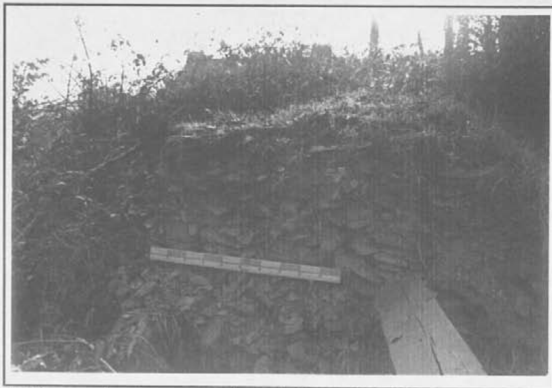
fig.24 : coupe dans le rempart en pierres (schiste) de la fortification de la Chapelle-du-Mur en Cleden-Poher
