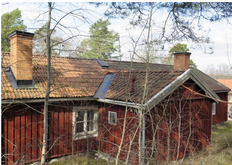
Baksidan med den utanpåliggande byggnadsvolymen innehållandes toaletter.
