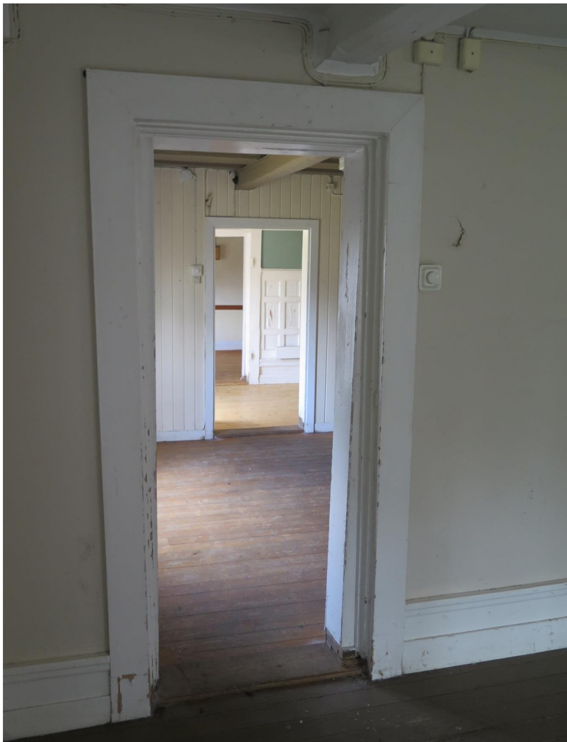
Dörrfodret runt dörren i det sydvästra rummet är troligtvis i originalutförande. På bilden ser man tvärs över de fyra parallellt placerade rummen i längan, från sydväst till nordöst.
