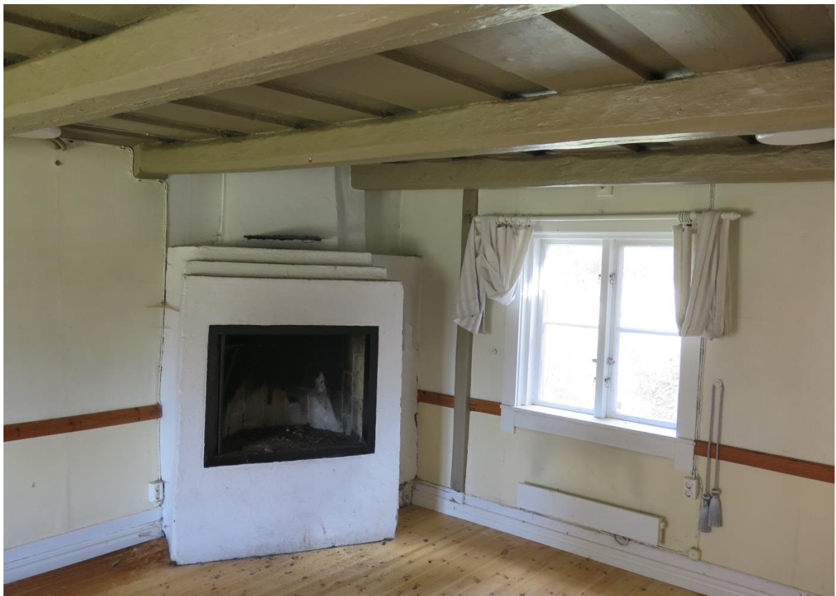
Rörspis och takbjälkar är original i längans nordöstra rum.
