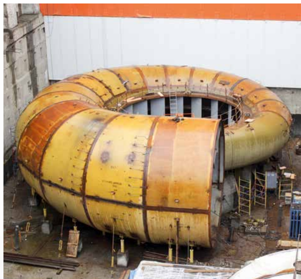
Спиральная камера третьего гидроагрегата
