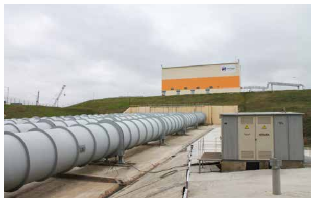
Водоприемник и водоводы
