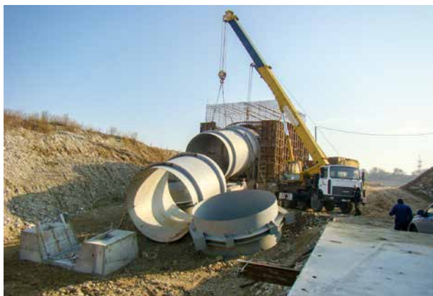
Строительство напорного трубопровода
