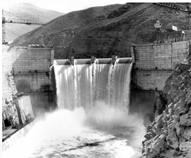
Пропуск воды через недостроенную плотину
