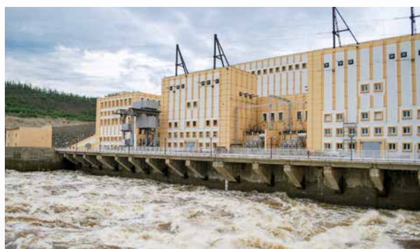
Здание ГЭС с работающим донным водосбросом
