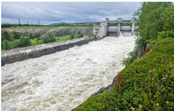
Грунтовая плотина и водосброс
