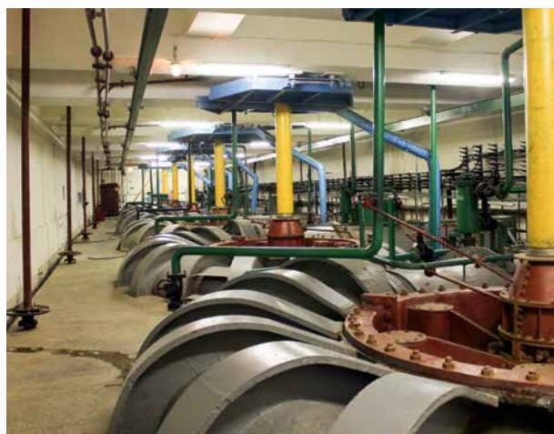
Насос-турбины
