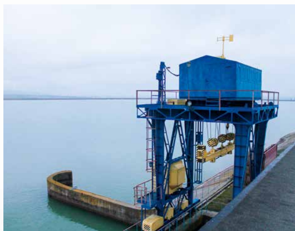
Бассейн суточного регулирования
