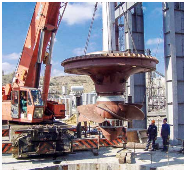
Монтаж гидротурбины
