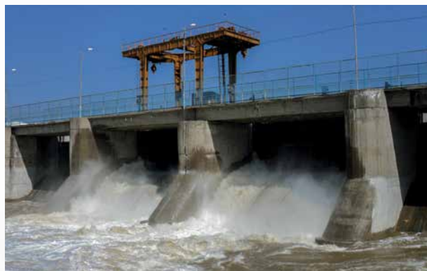
Береговой паводковый водосброс
