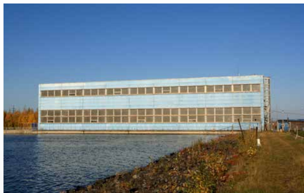
Вид с верхнего бьефа
