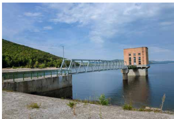
Башенный донный водоспуск
