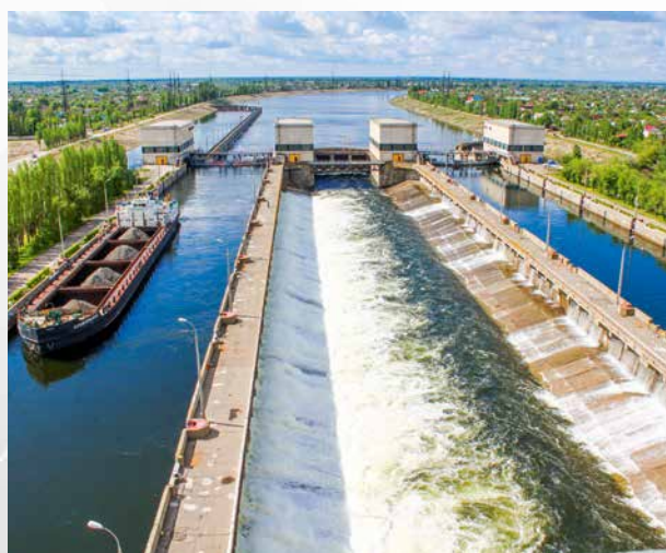
Отводящий лоток ГЭС
