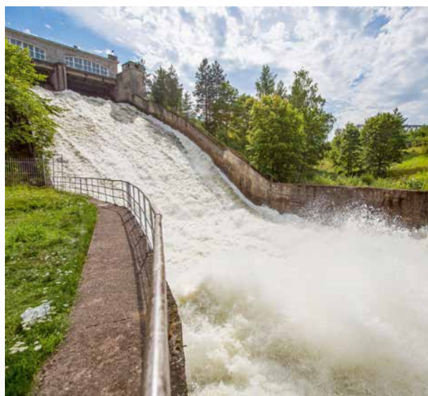
Холостой водосброс напорного бассейна
