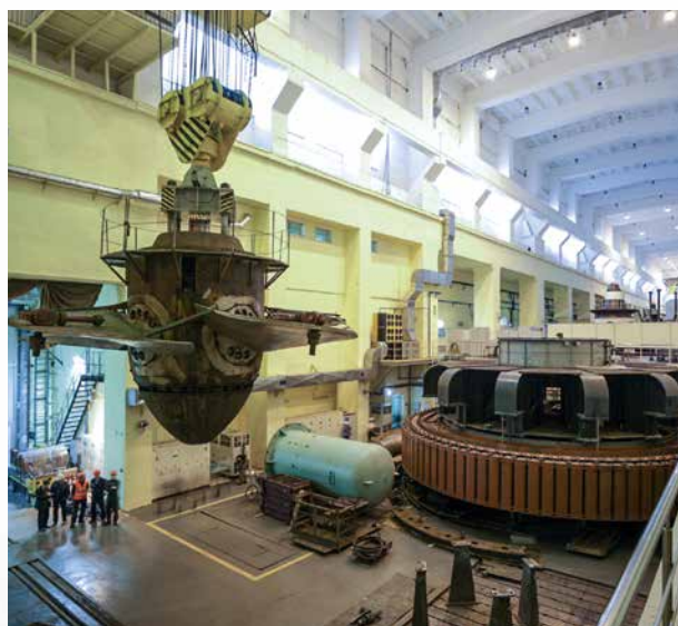
Монтаж рабочего колеса турбины
