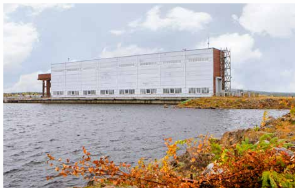
Здание ГЭС с верхнего бьефа
