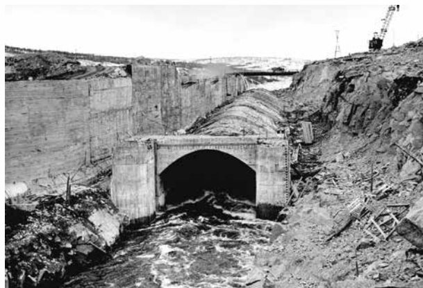
Строительство Серебрянской ГЭС-2
