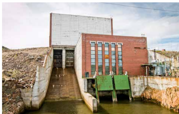
Здание ГЭС и водосброс
