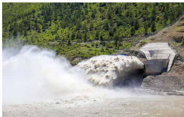
Концевое устройство водосброса
