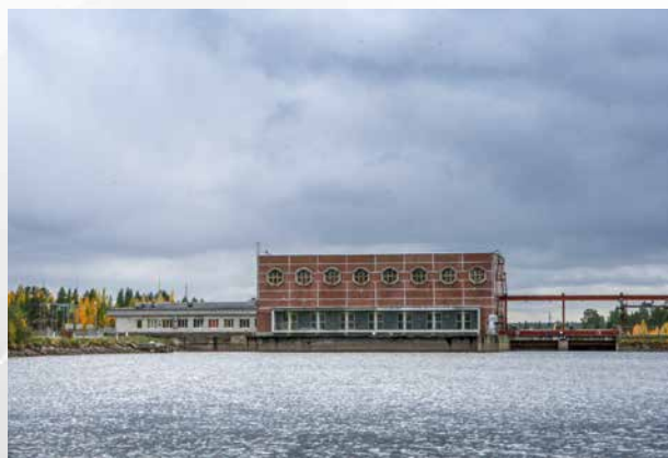
Вид с верхнего бьефа
