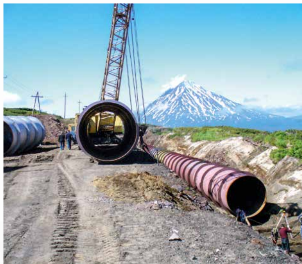
Строительство Толмачевской ГЭС-2
