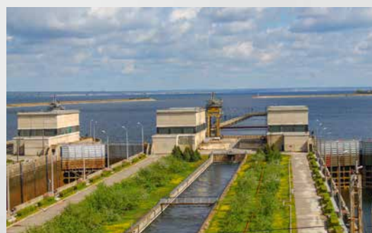
Подводящий лоток ГЭС
