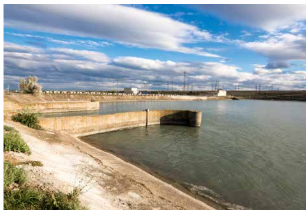
Бассейн суточного регулирования
