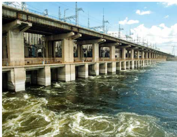
Вид на здание ГЭС с нижнего бьефа
