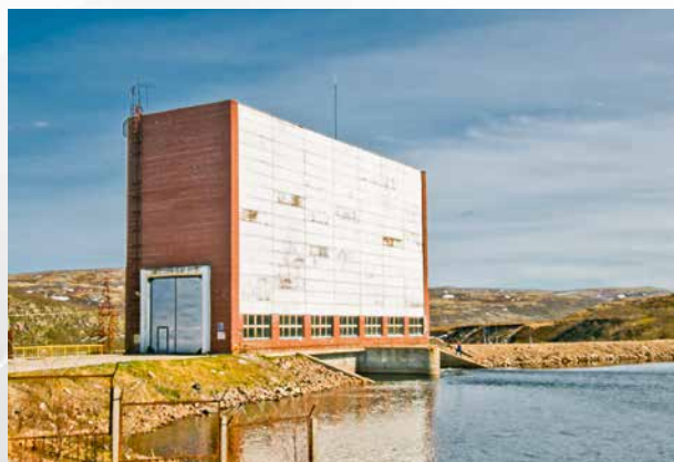
Вид с верхнего бьефа
