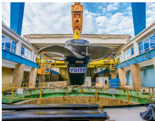
Рабочее колесо новой турбины
