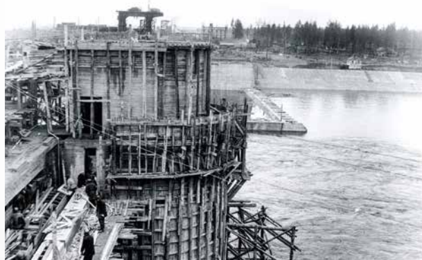
Строительство Иваньковской ГЭС (1935 г.)
