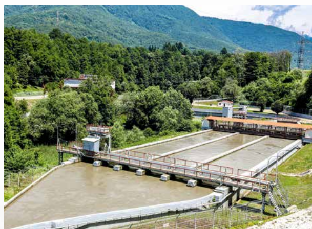
Сооружения головного узла
