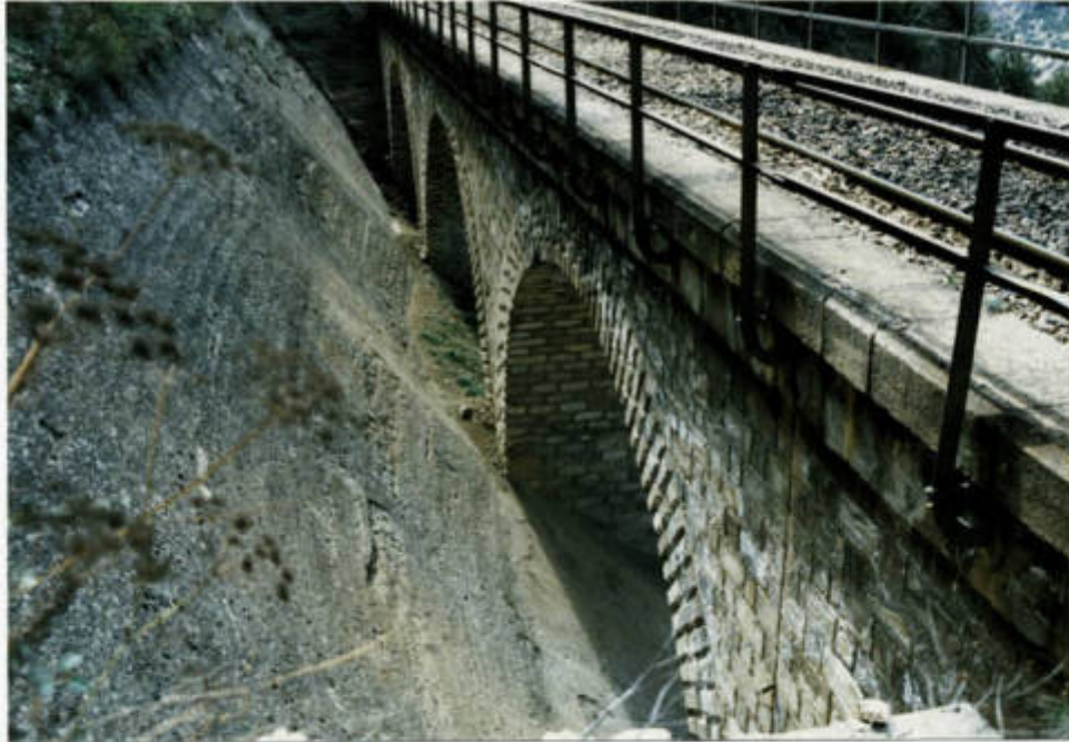
پل ۲۳۳ - تیر ۱۴ - ضلع شمال شرق
