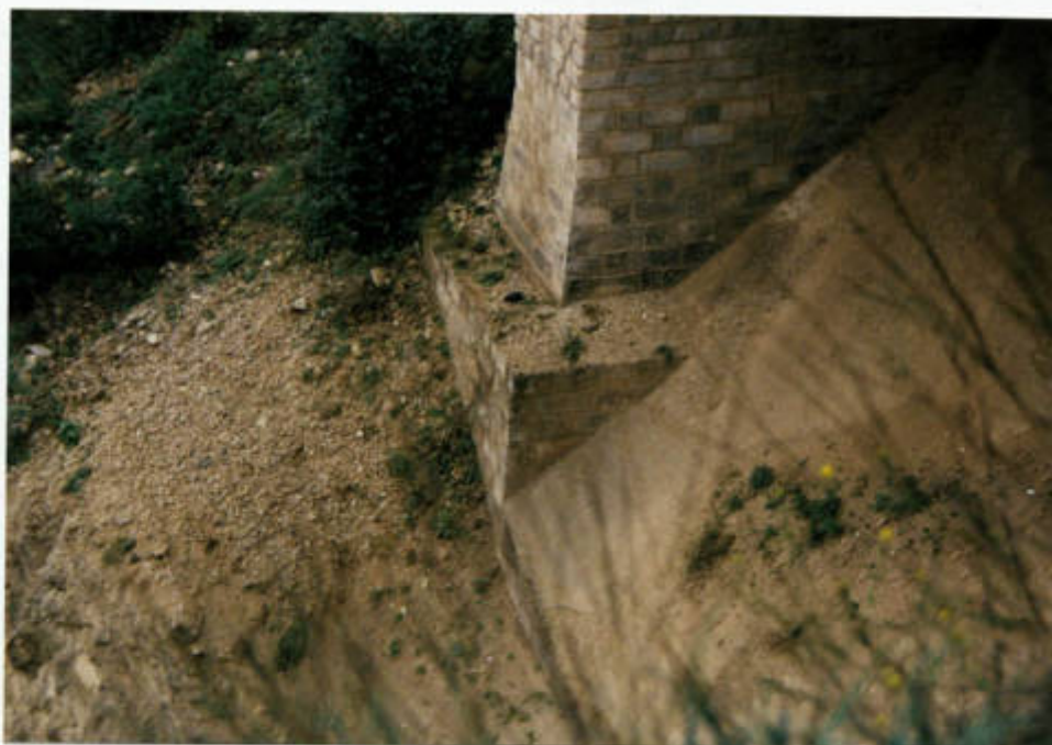
پایه پل ۲۳۳ تر ۱۴
