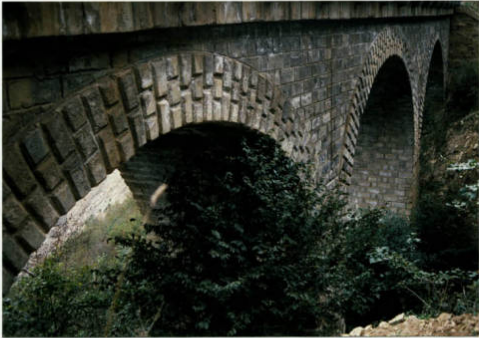
نمای جنوب شرقی پل ۲۳۳ تیر ۱۴
