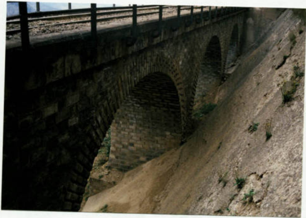
نمای شرقی پل ۲۳۳ تیر ۱۴
