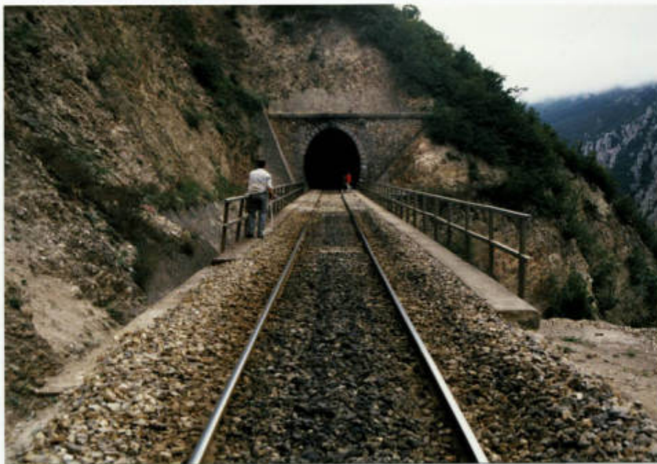
نمای جنوبی پل ۲۳۳ تر ۱۴
