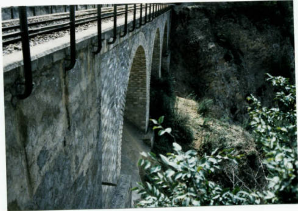
پل ۲۳۳ - تیر ۱۴ - ضلع غری پل
