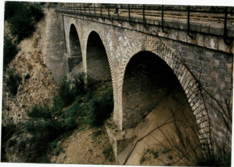
نمای غربی پل ۲۳۳ تبر ۱۴
