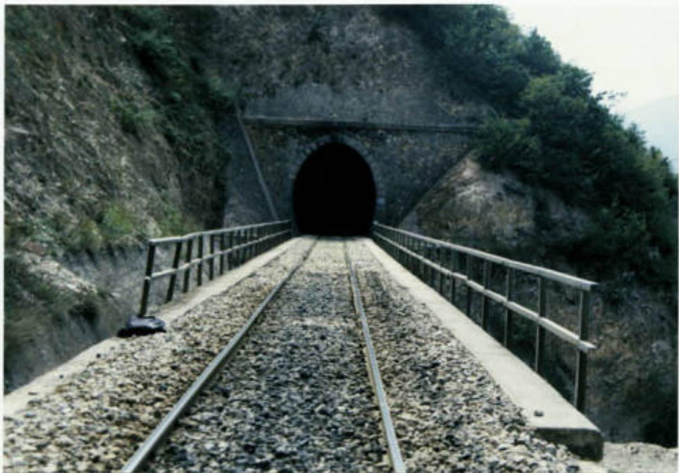
پل ۲۳۳ تیر ۱۴ - دید از شمال
