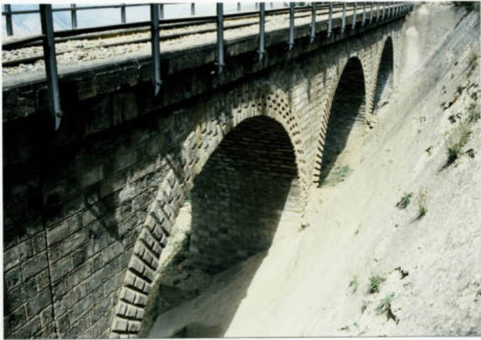
پل ۲۳۳ - تیر ۱۴ - ضلع جنوب شرق
