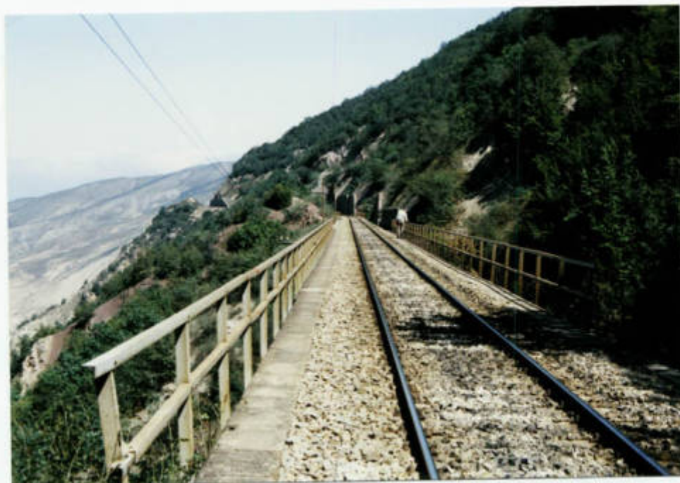
پل ۲۳۰ - تیر ۸ - دید از جنوب
