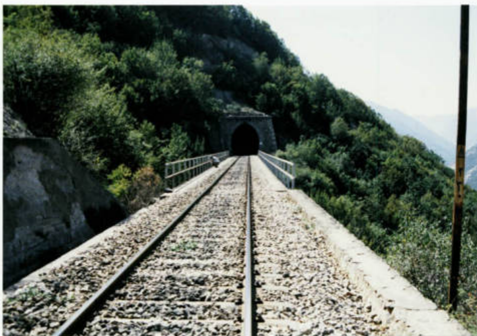
پل ۲۳۰ متر ۸ - دید از شمال
