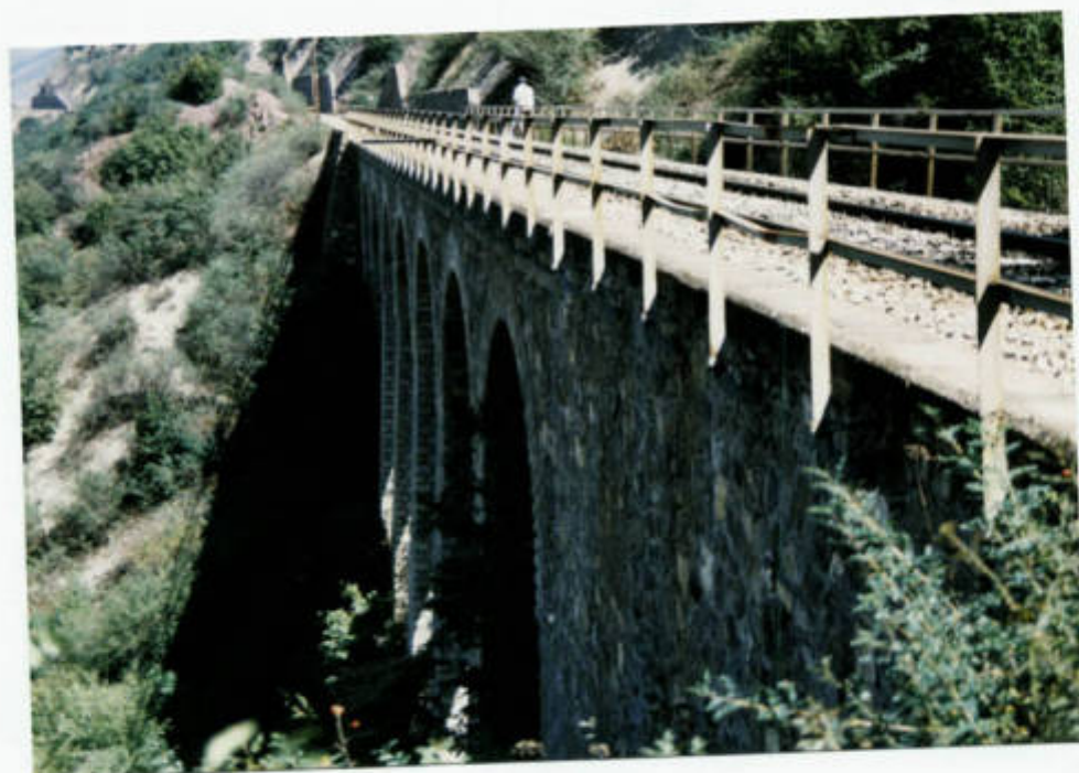
ضلع غربی پل ۲۳۰ تیر ۸
