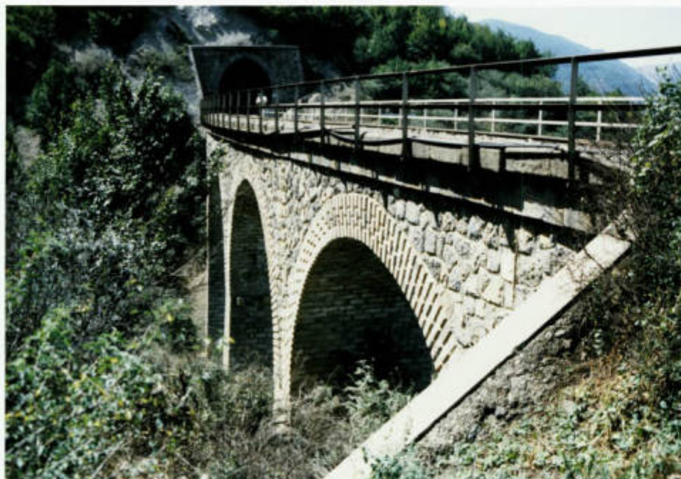
پل ۲۳۰ متر ۸ - دید از شمال شرق
