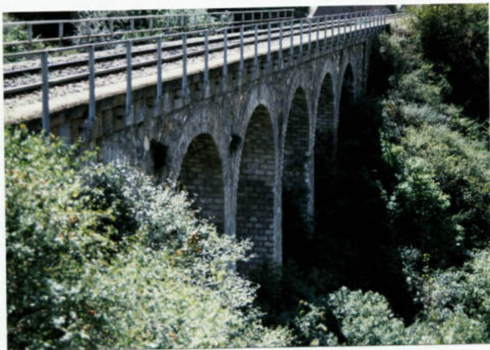
ضلع غروی پل ۲۳۱ - تمر ۱
