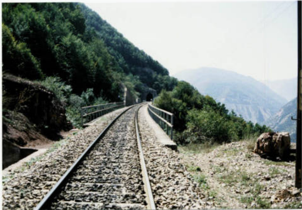
ضلع جنوبی پل ۲۳۱ تیر ۱
