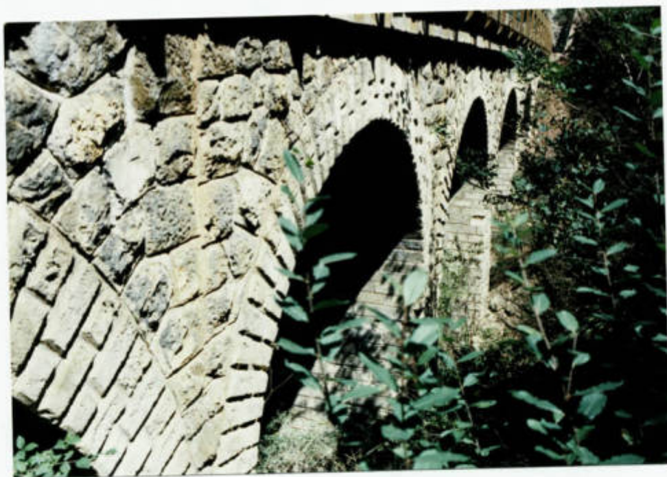
پل ۲۳۱ تمر ۱ - دید از جنوب شرق
