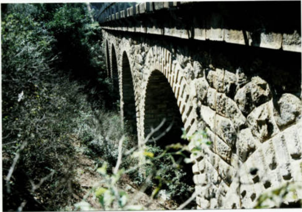
پل ۱۳۶ - تیرا - ریلوے کالونی
