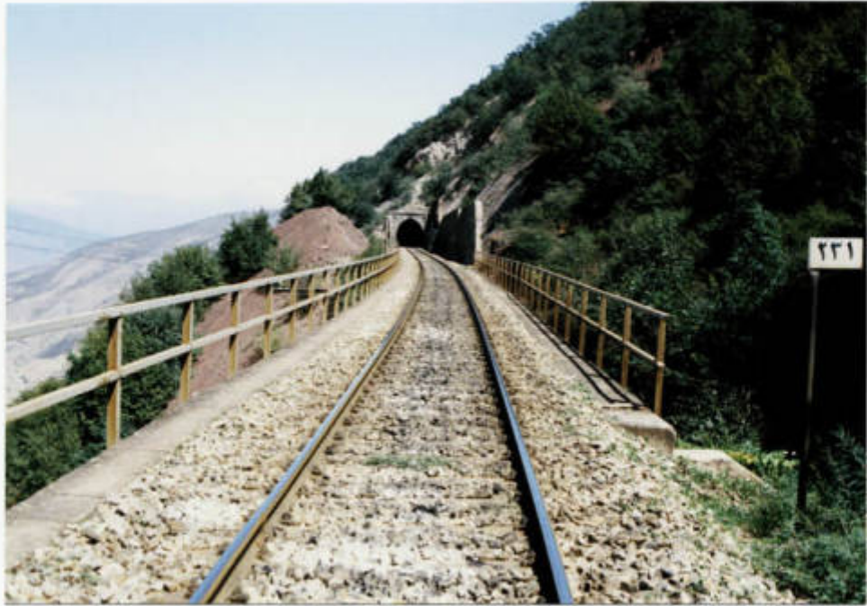
پل ۲۳۱ تیر ۱ - ضلع شمالی پل
