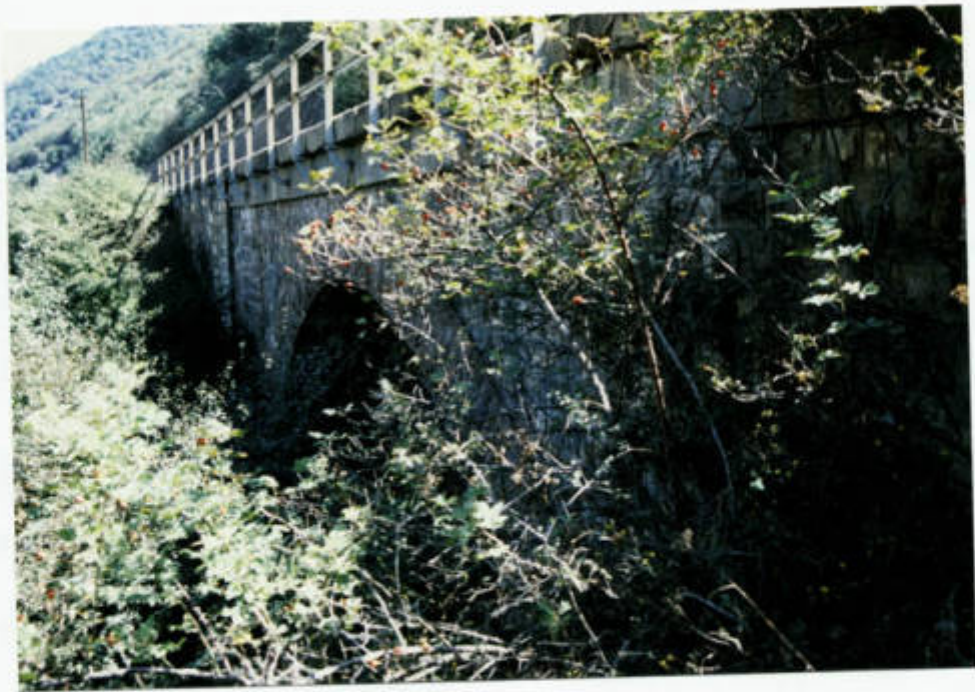
ضلع غروی پل ۲۲۹ - تیر ۱۴
