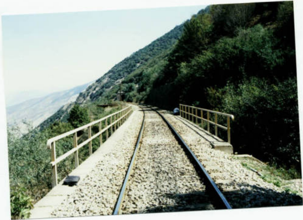
ضلع جنوب پل ۲۲۹ - تیر ۱۴
