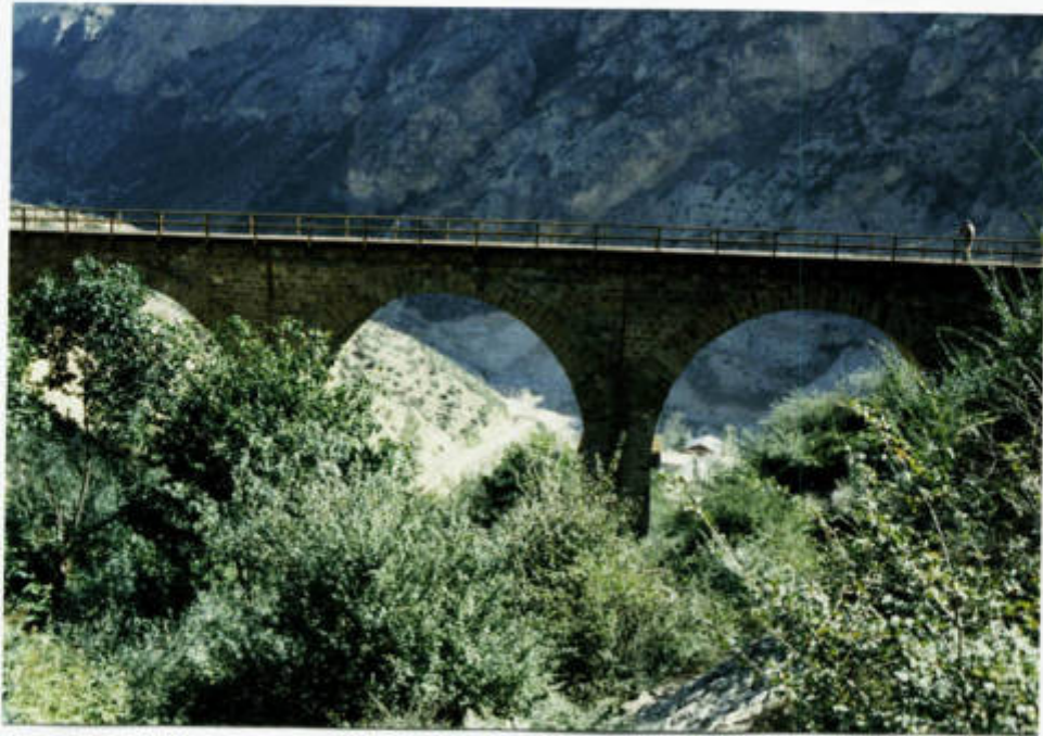
ضلع شمالی پل ۲۶۸ تیر ۱۶
