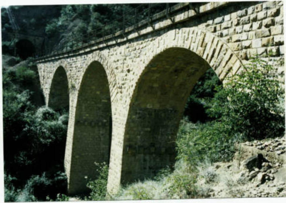
ضلع جنوب شرقی بل ۲۶۸ تیر ۱۶
