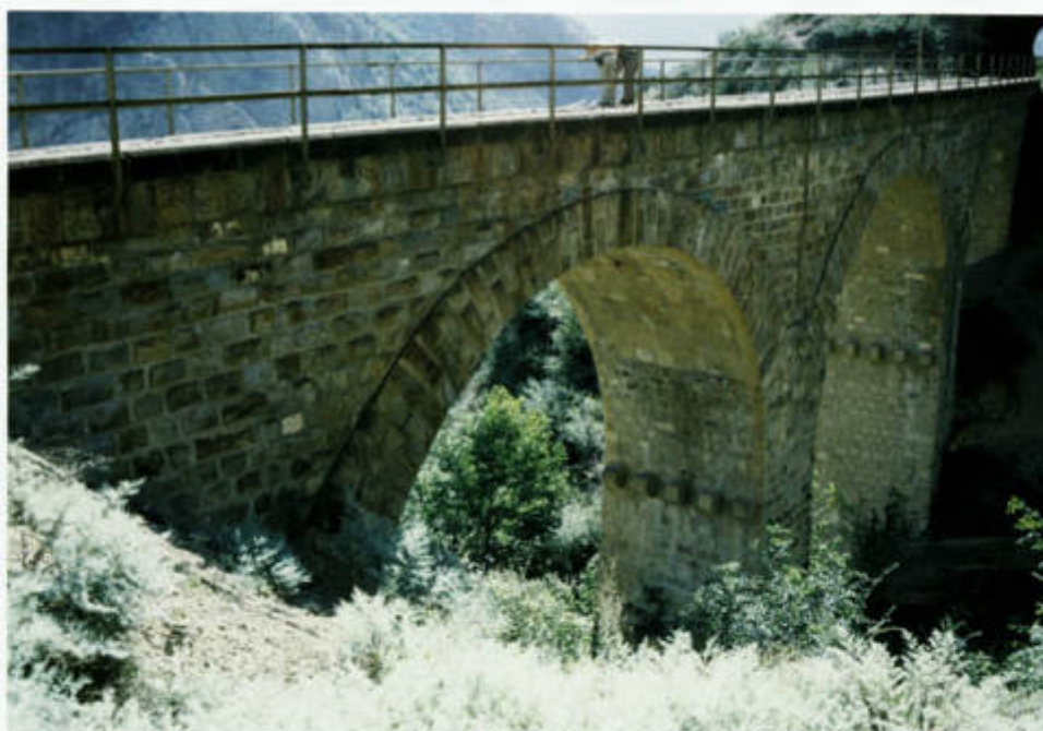
نمای از ضلع جنوب غربی پل ۲۶۸ تیر ۱۶
