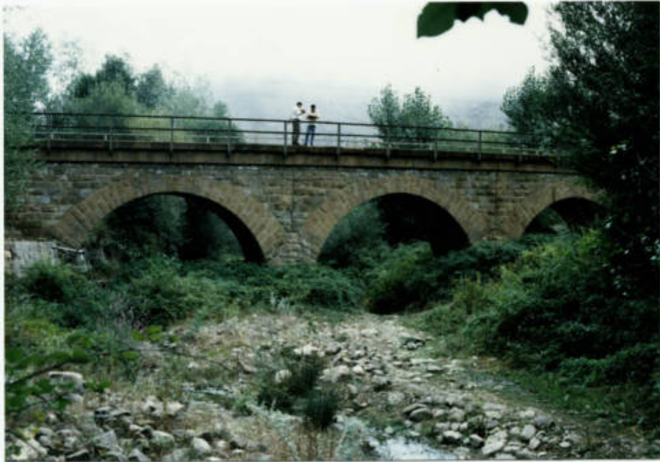
نمای غربی پل ۲۶۴ تیر ۱۲
