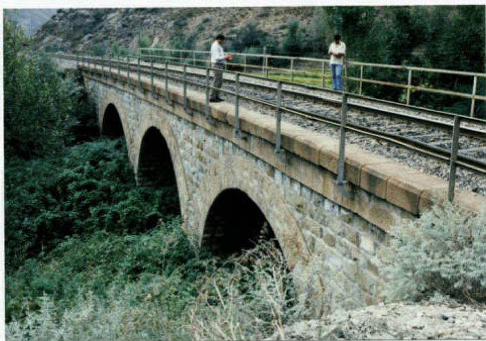
نمای ضلع شمال شرق پل ۲۶۴ تیر ۱۲
