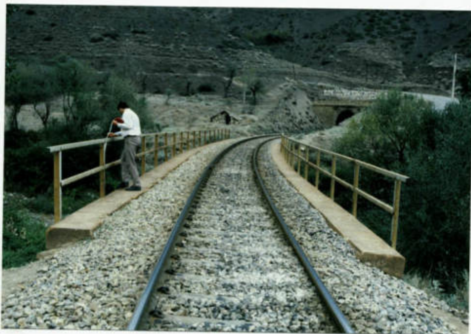
نمای جنوبی پل ۲۶۲ متر ۱۲
