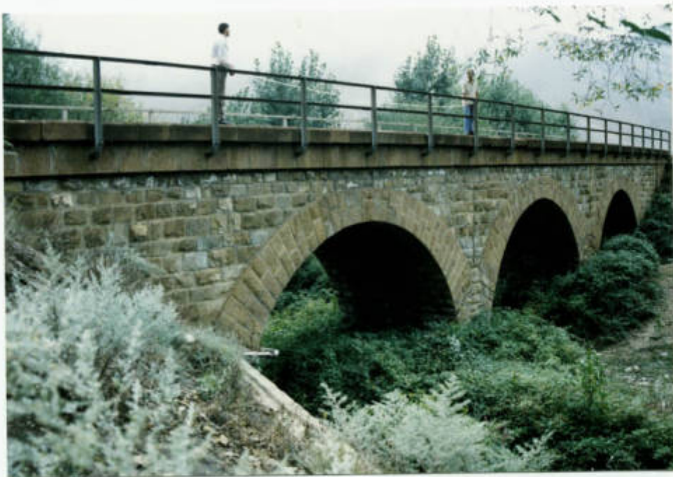
نمای شمال غرب پل ۲۶۲ تیر ۱۲
