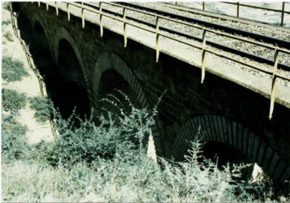
ضلع جنوب غری پل ۲۶۸ تیر ۱۰
