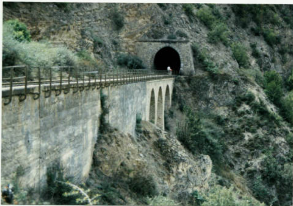
پل ۲۳۴ نمبر ۹ دید از جنوب
