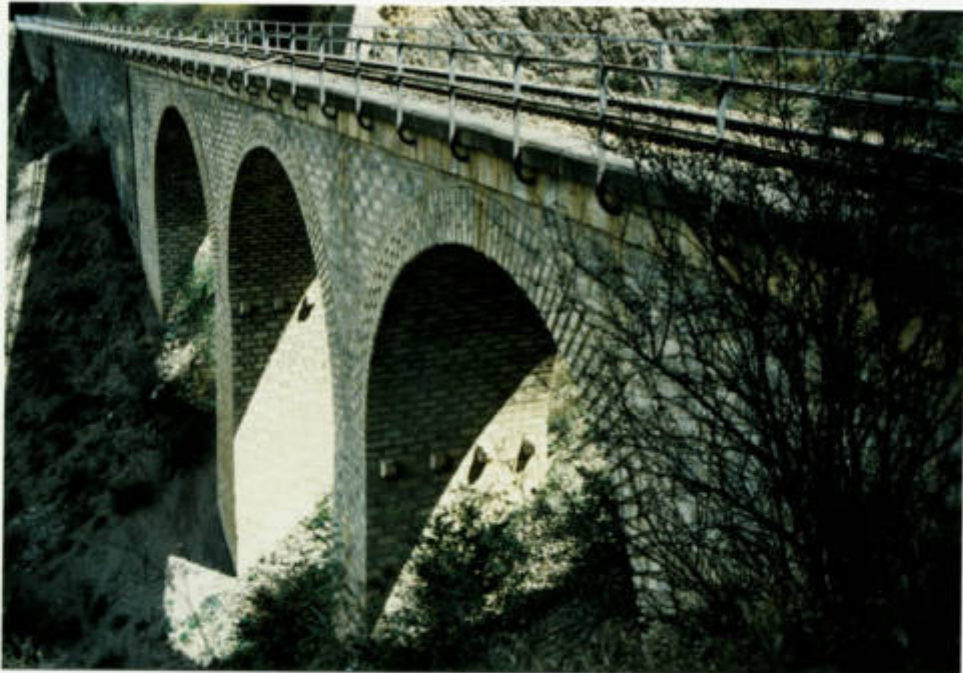
ضلع شرقی پل ۲۳۴ تیر ۹
