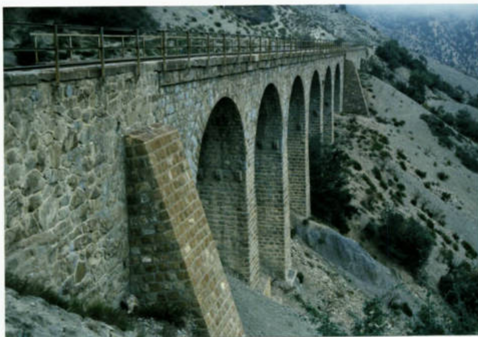
نمای جنوب شرقی پل ۲۴۷ تیر ۷
