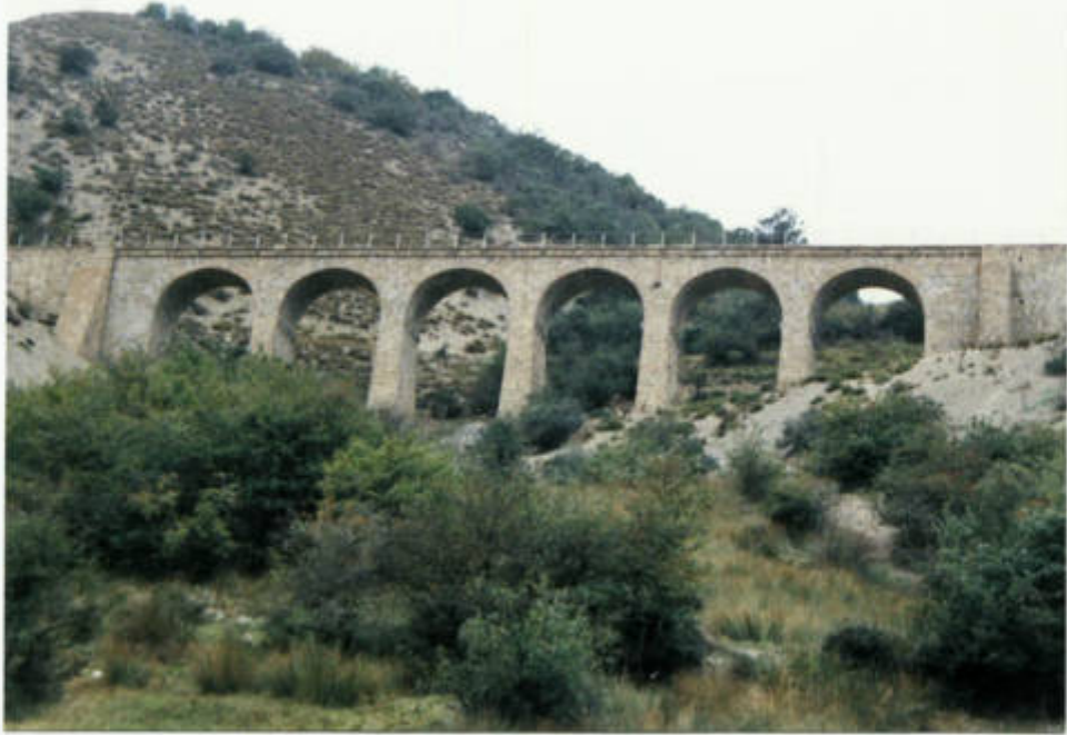
نمای شرقی پل ۲۴۷ تیر شماره ۷
