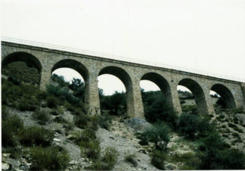
نمای شرقی پل ۲۴۷ تر ۷
