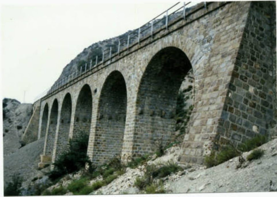
نمای شمال شرقی پل ۲۴۷ تیر ۷
