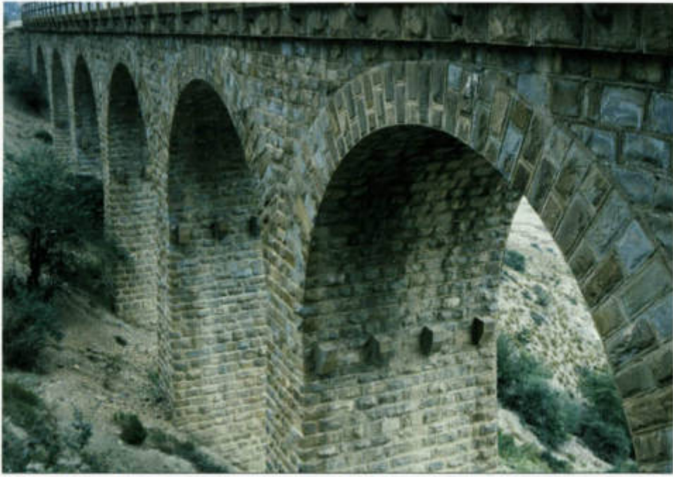
نمای جنوب غری پل ۲۴۷ تر ۷
