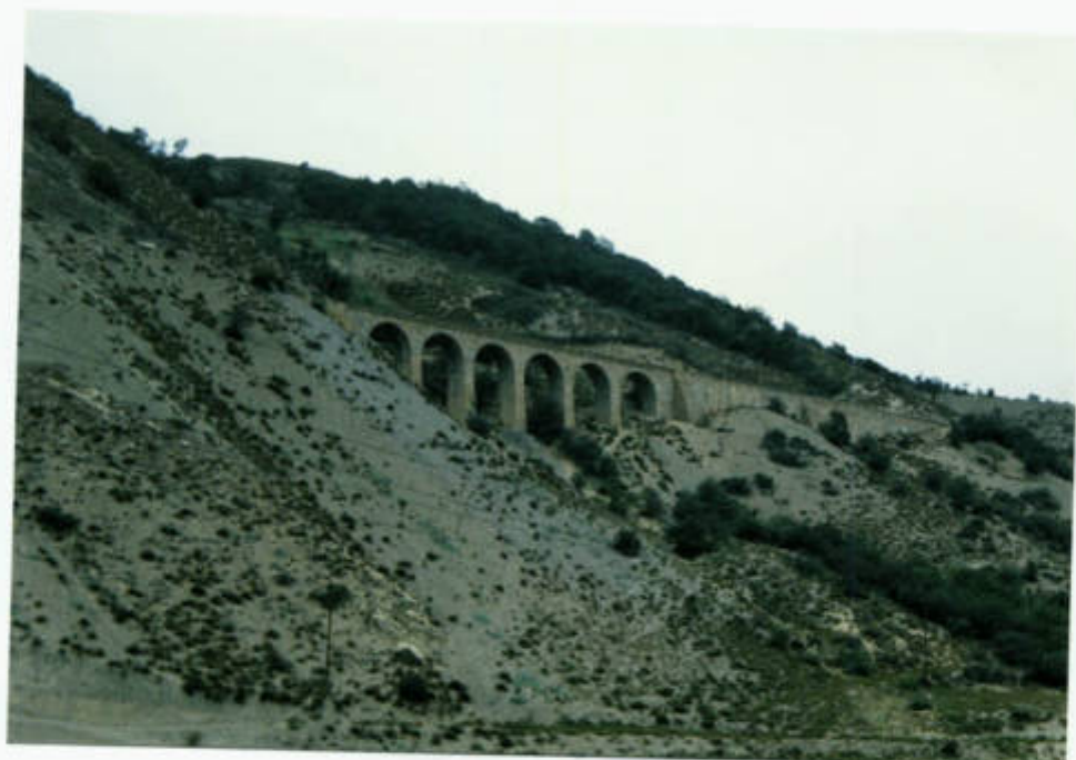
نمای جنوب شرقی پل ۲۴۷ تر ۷
