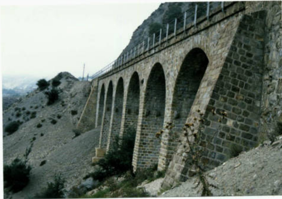
نمای شمال شرقی پل ۲۴۷ تیر ۷
