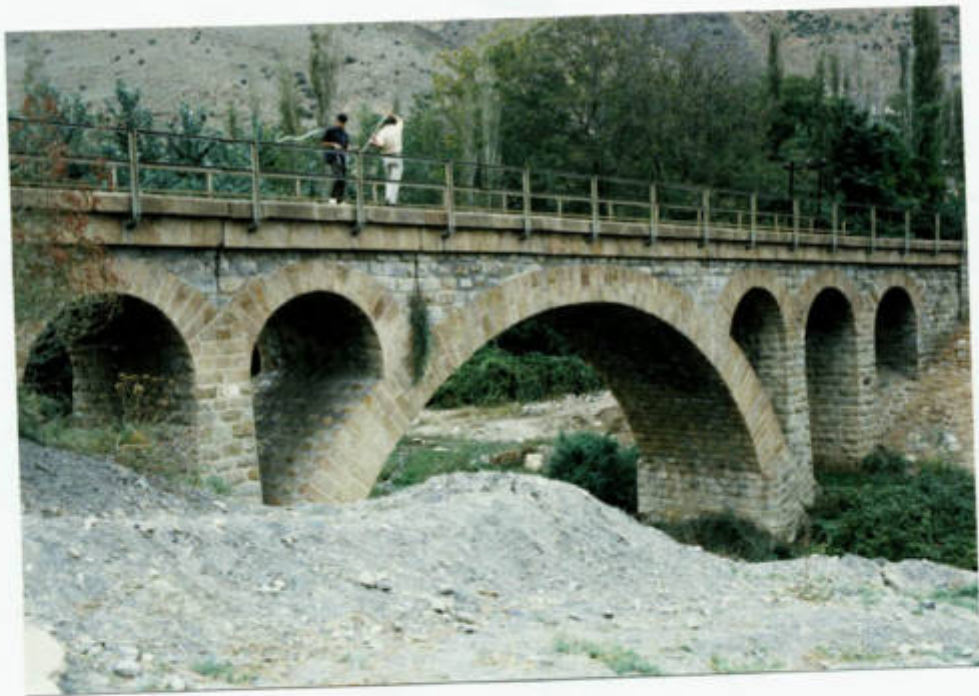
نمای غربی پل سرخ آباد
