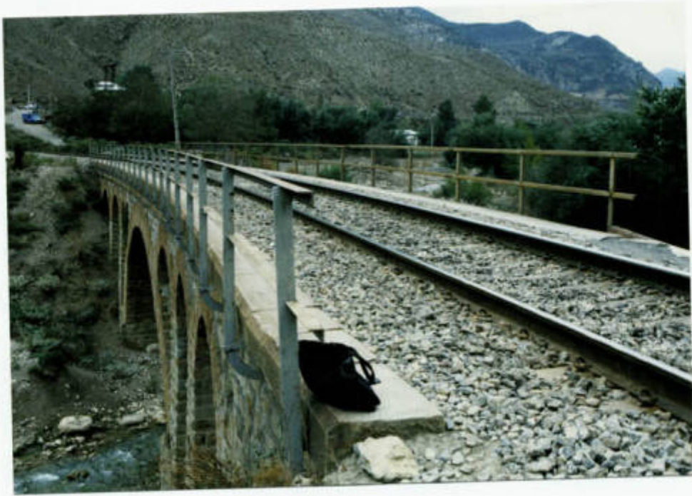
نمایی از جهت شمالی پل سرخ آباد
