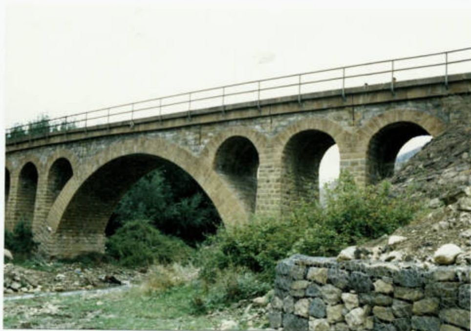
نمای جنوب شرقی پل سرخ آباد
