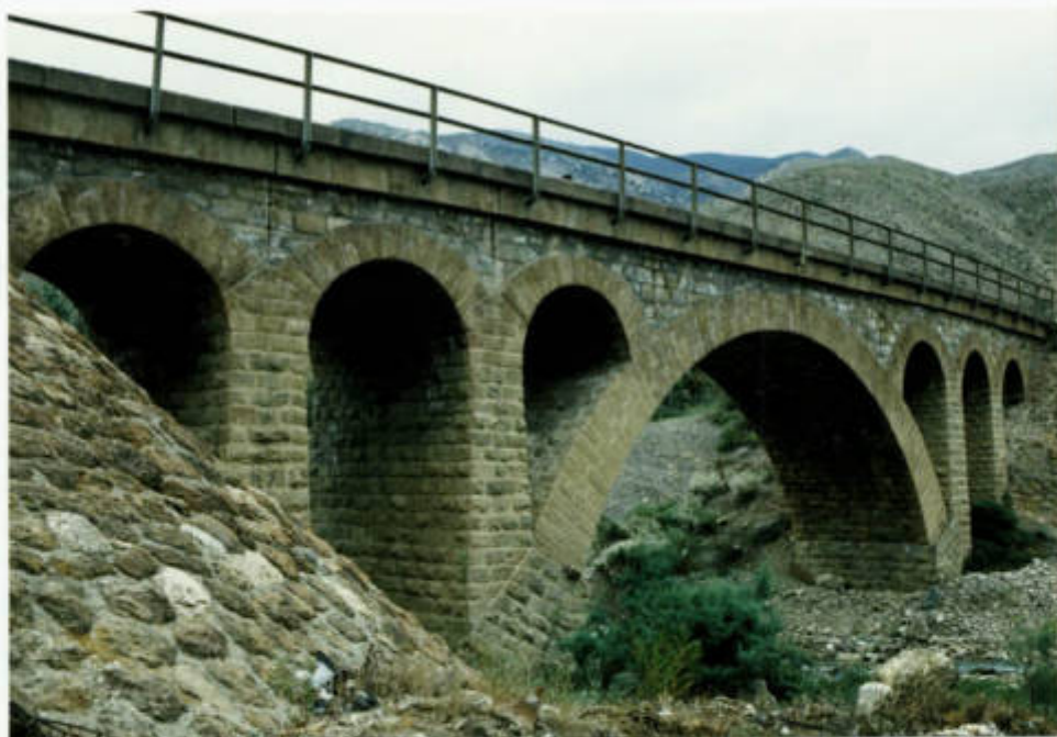
نمای شمال غربی پل سرخ آباد
