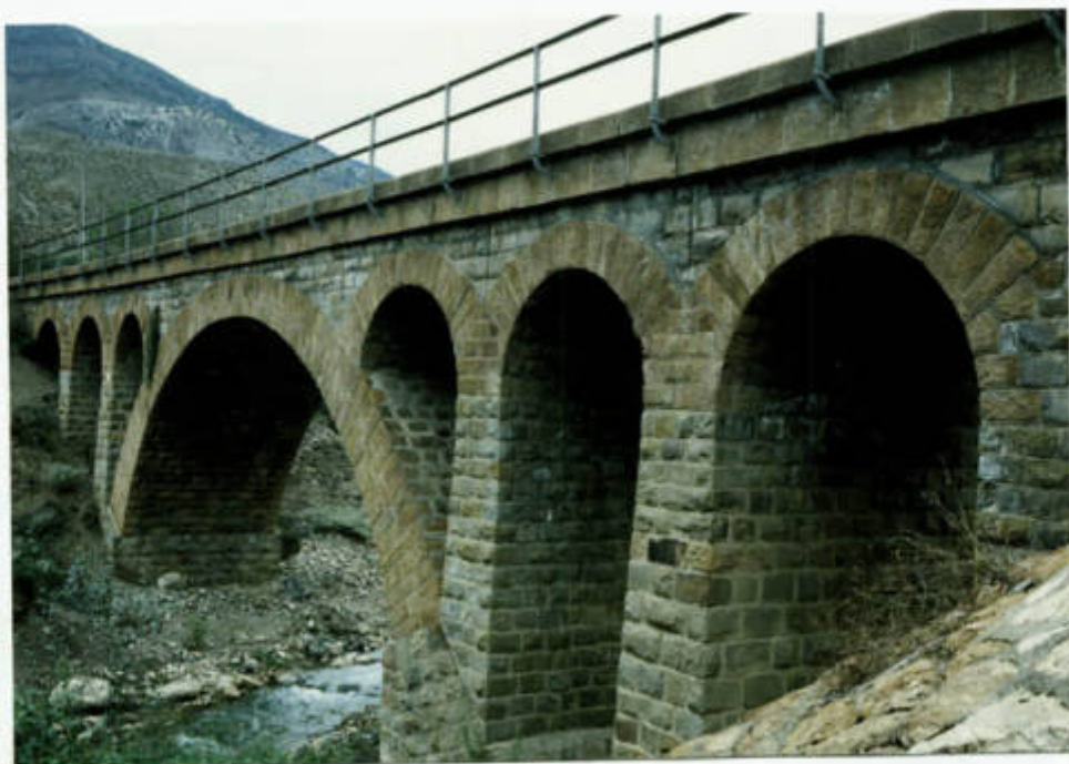
نمای شرقی پل سرخ آباد
