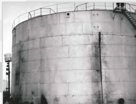
Вертикальный рез после подрыва заряда
