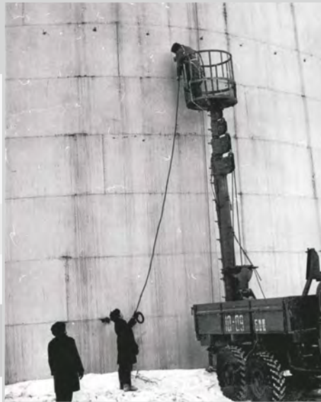
Монтаж вертикального заряда
