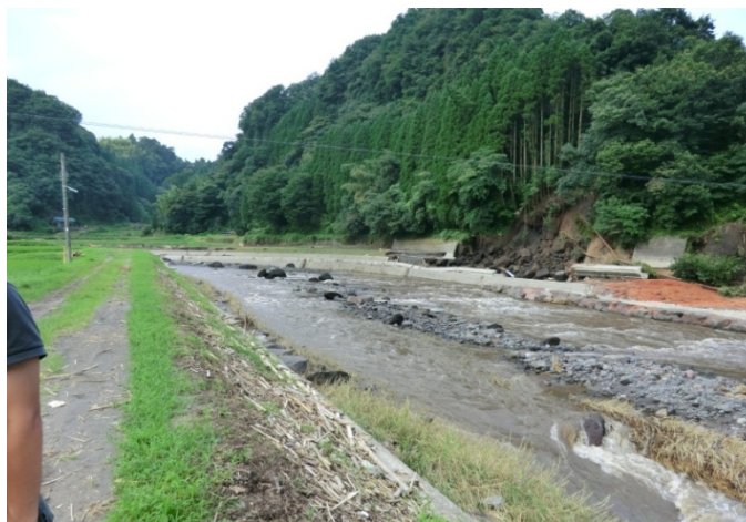
図 10.17 玉来川 湾曲部外側からの破壊が多数みられる
