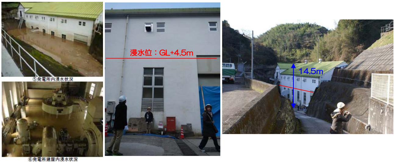
図 10.14 軸丸発電所(左：発電所浸水状況 [H24. 7. 12 九州電力撮影]，中右：発電所 [H24. 12. 7 撮影] )
