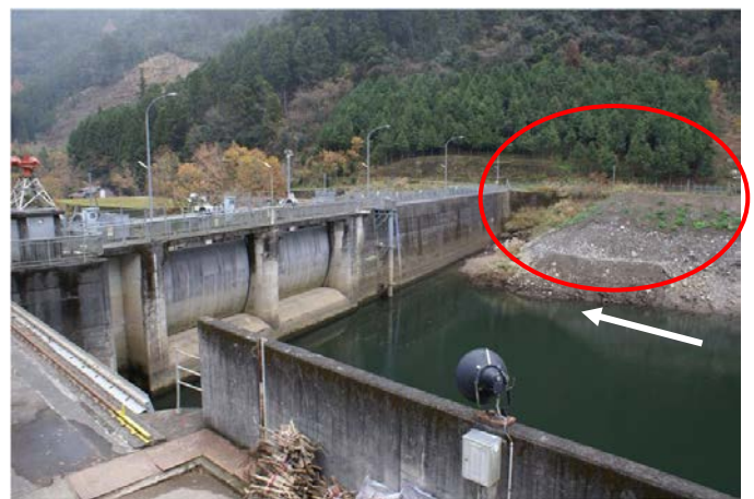
図10.10 高瀬川ダム（ダム湖内，H24.12.6撮影）
