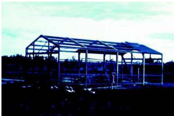
Figura 6 El galpón de aluminio en construcción.
