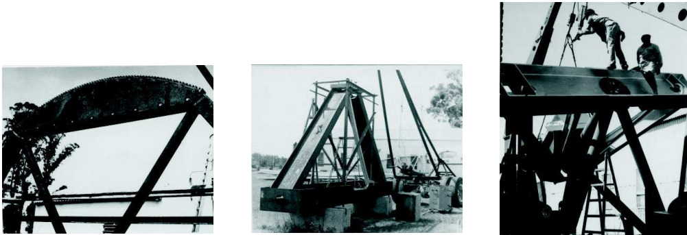
Figura 10 Izquierda: Corona para el movimiento en ascensión recta. Centro: Eje para el movimiento en declinación. Derecha: El sistema de movimientos armado.
