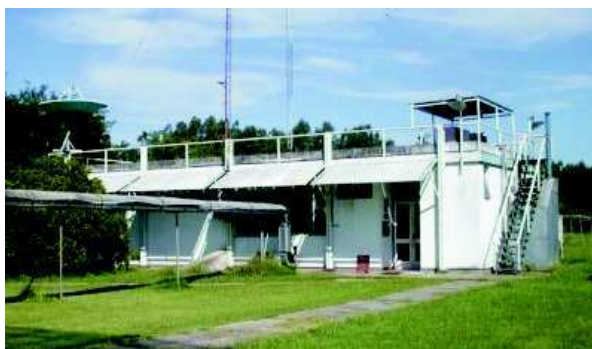
Figura 29 La nueva Sala de Control.
