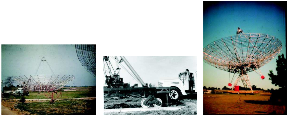
Figura 28 Izquierda: El disco de la Antena 2 terminado. Centro: La plataforma móvil para la Antena 2. Derecha: La Antena 2 montada sobre la plataforma móvil.
