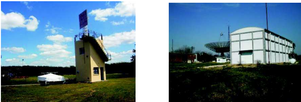
Figura 56 Izquierda: Instalación para la medición de características direccionales de antenas con campos lejanos. Derecha: Edificio para Laboratorios Electrónicos, oficinas y cámara anecoica para medición de propiedades radiativas electromagnéticas.
