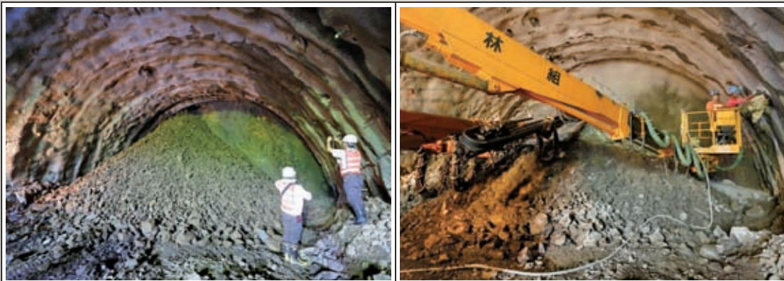
南口南下線遇破碎帶開挖面抽坍
