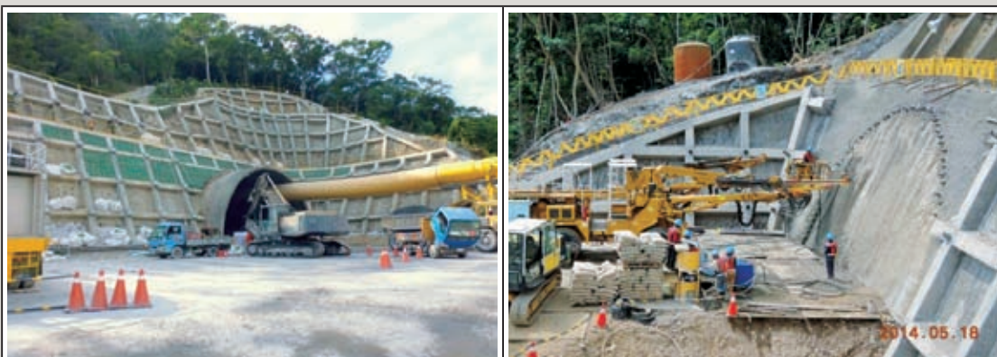
隧道北洞口邊坡格梁護坡
