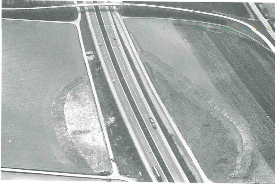
Abb. 16: Otzing – Autobahn A 3 gegenüber von Sautorn, Blickrichtung Landshut. Abgeschobene Flächen zur Anlage zweier Verdunstungsbecken (27. 4. 1994).
