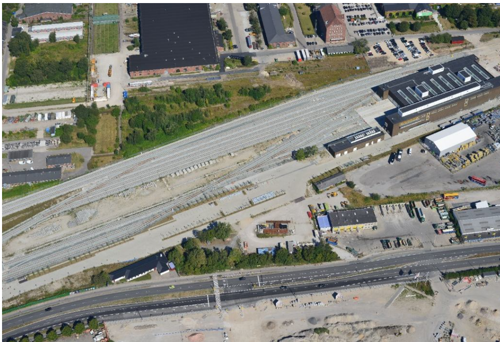
Figur 18: Kontrol- og vedligeholdelsescenter ved Vasbygade gør det svært at etablere sammenhængende by i perspektivområdet Godsbaneterrænet, der ligger mellem Vasbygade og baneterrænet ved Vesterbro.
