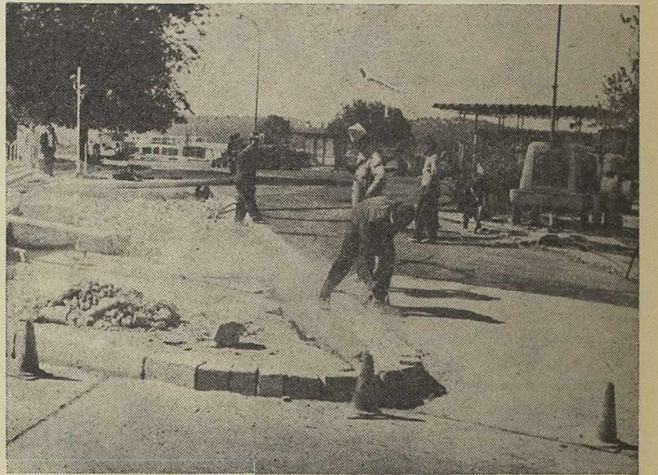
Završni radovi na Obali JRM
