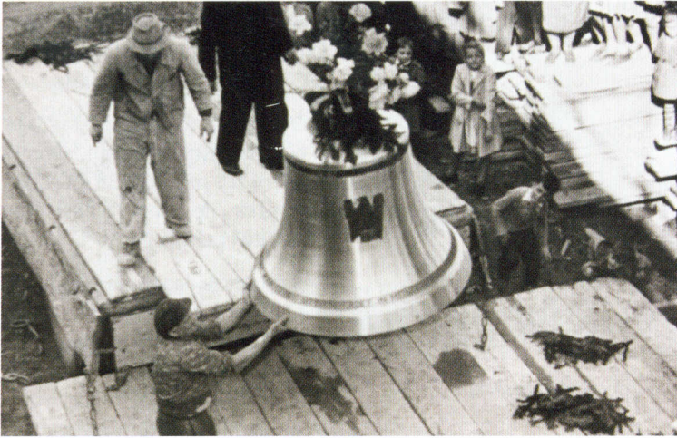
Die erste Glocke wird auf den Glockenstuhl der Rosenbergkirche gezogen
