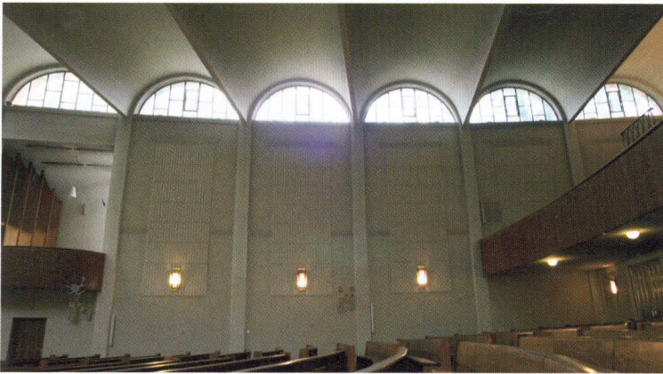
Sechs, den Raum stützenlos überspannende Gewölbeschalen aus Beton
