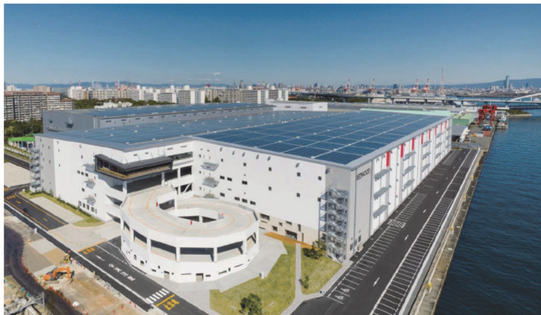
Nanko一期(日本)(由我們管理的基金持有)位於大阪港戰略位置，為雙坡道多層配送中心。 該設施於2016年竣工，樓高四層，建築面積為125,813平方米。
