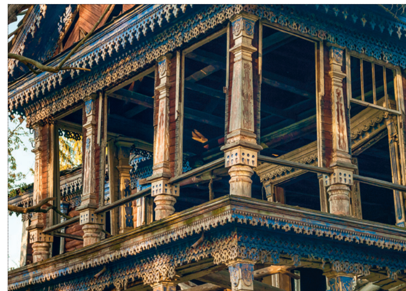
Крыша дома Берга старшего поддерживается двумя ярусами точечных деревянных колонн. Фото автора, 2015 год
