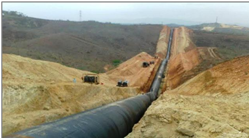
Imagen N° 8. Construcción de tubería de 100 pulgadas. Fuente: TalCual 19
