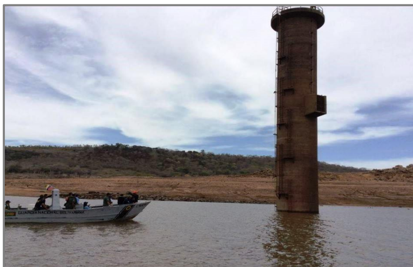
Imagen N° 25. Torre-toma de Tocomita. Fuente: Corpoelec (06 de mayo de 2016)
