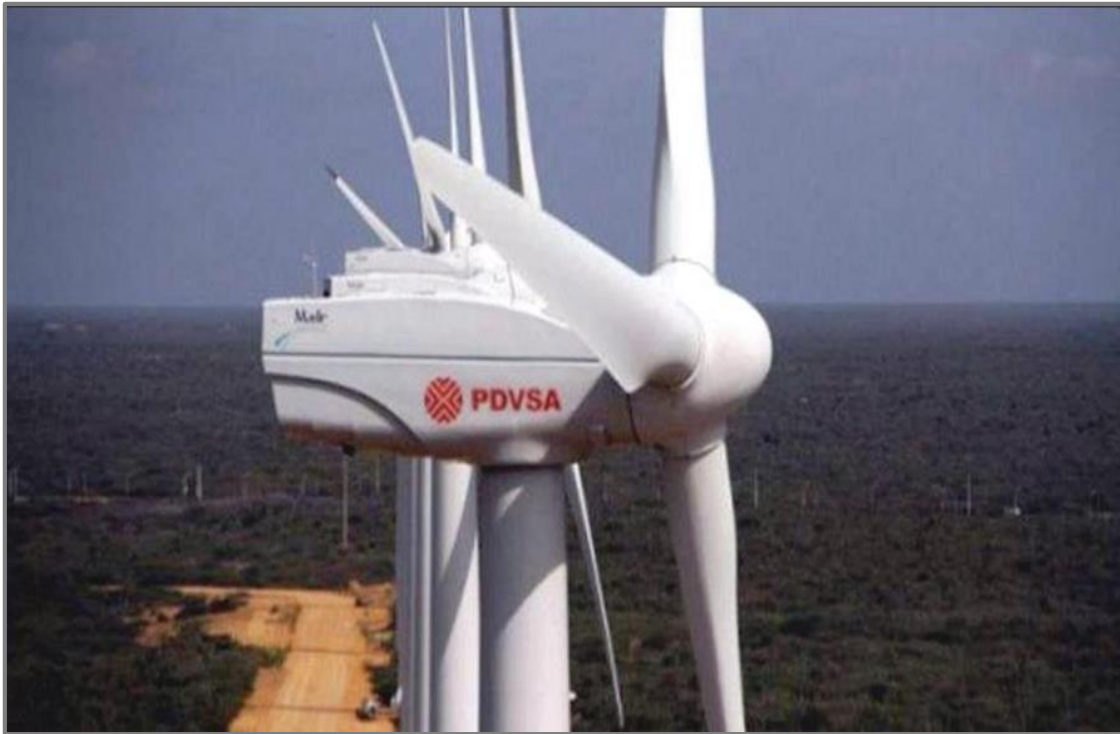
Imagen N° 70. Torres de generación eólica. Fuente PDVSA (2013)
