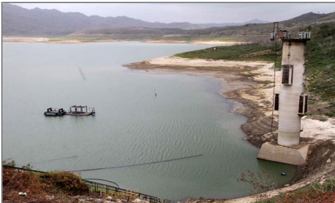
Imagen N° 15. Embalse de Barrancas. Fuente: Gobernación del estado Falcón (2015) 23
