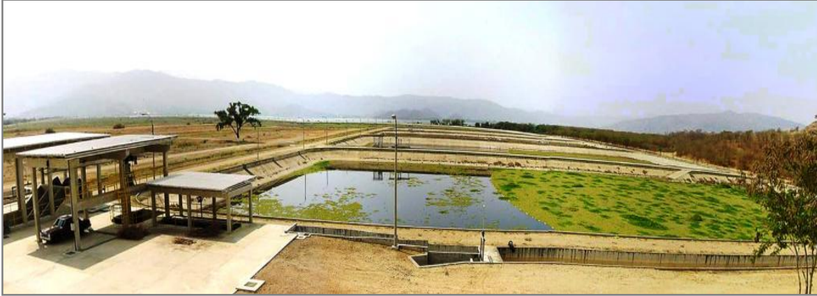
Imagen N° 31. Planta de tratamiento de aguas servidas de Taiguaiguay. Fuente Ing. Manuel Pérez Rodríguez (2012).
