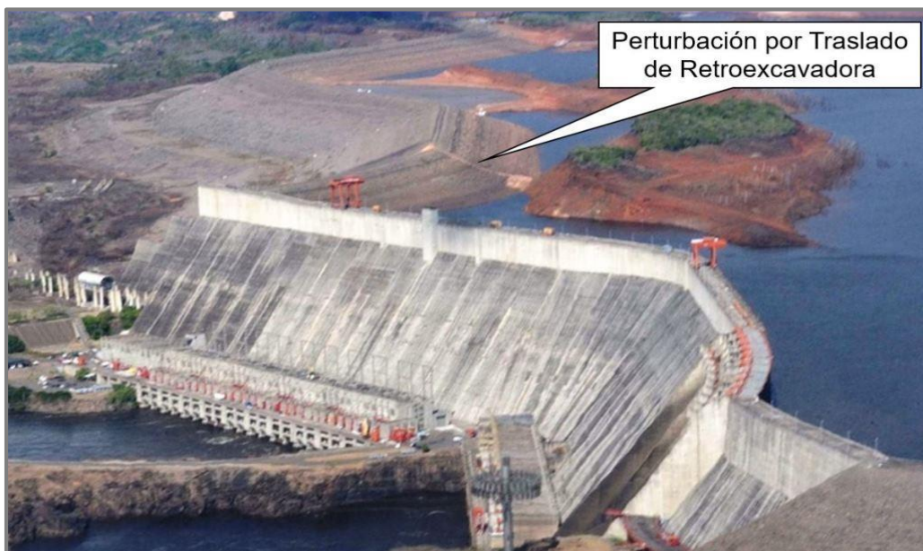
Imagen N° 89. Perturbación del talud húmedo por traslado de la retroexcavadora / Notas aclaratorias personales. Fuente: Red social twitter (@LMOTTAD) (abril 2016)
