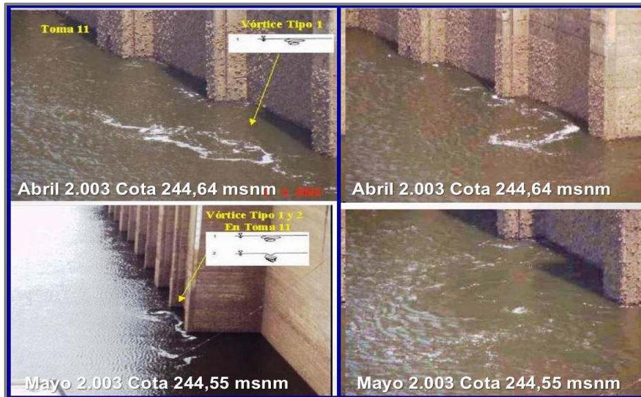
Imagen N° 73. Vórtices ocurridos en la toma de la unidad 11 entre abril y mayo 2003 Fuente: Edelca (2003) 61
