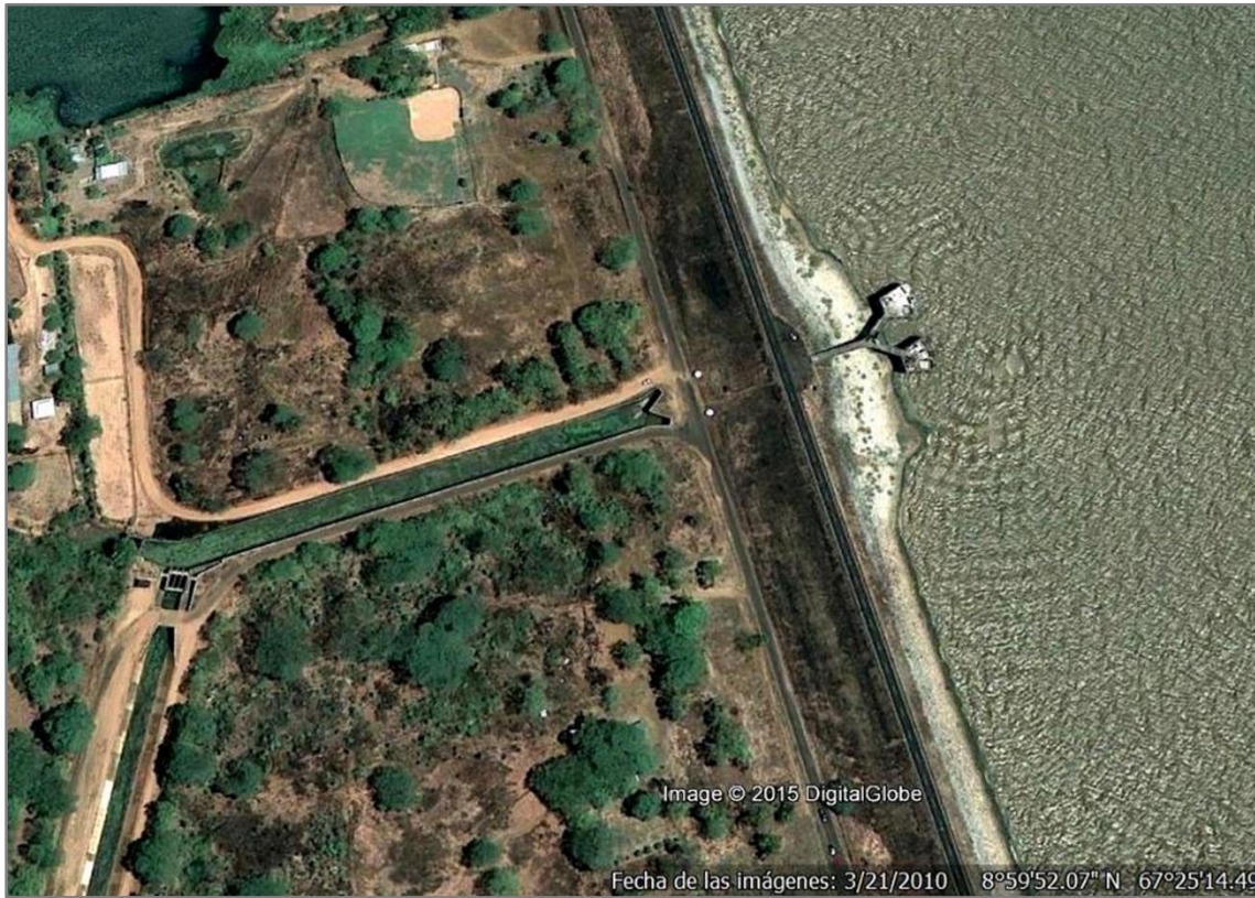
Imagen N° 34. Canales de riego totalmente secos Fuente: Google Earth (Marzo 2010).
