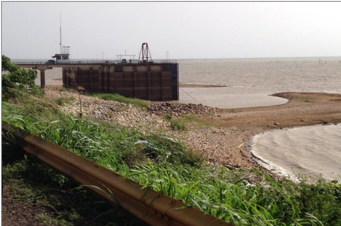
Imagen N° 35. Toma de agua de los canales de riego Fuente: Foto del autor (20 de junio del 2015).
