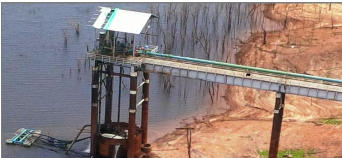
Imagen N° 24. Torre Toma del acueducto de Upata. Fuente: Hidrobolívar (abril 2016).
