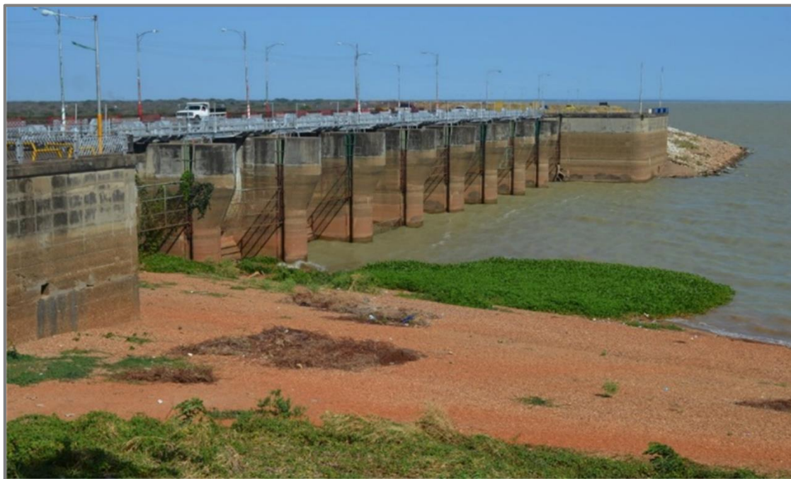
Imagen N° 36. Bajo nivel de agua aguas arriba del aliviadero Fuente: Tubazo Digital (Abril 2016)
