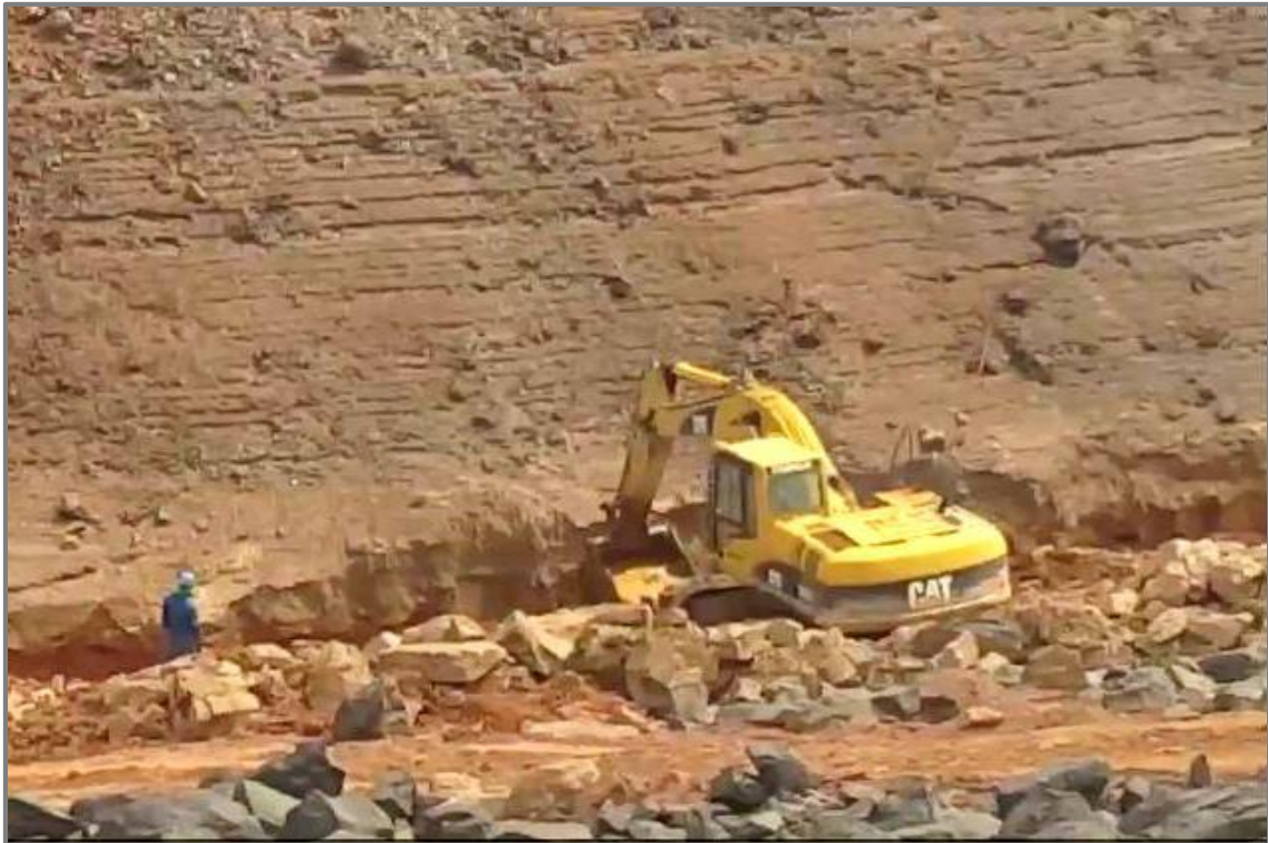
Imagen N° 88. Excavación al pie de la presa (Más de 1 m de profundidad) Fuente: Red social twitter (@LMOTTAD) (10 de abril 2016)
