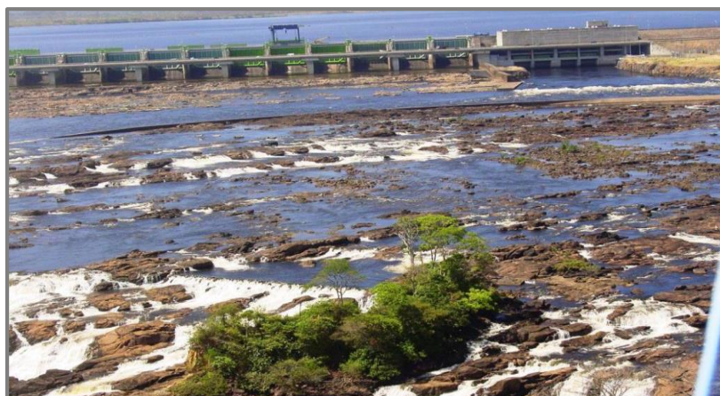
Imagen N° 76. Aliviadero de la Central Macagua III (Mayo 2016)
