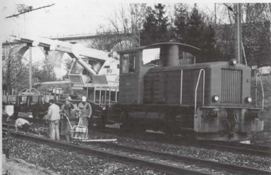
Oben: Kranwagen der neusten Bauart: XTms 85 400 zusammen mit dem Tm IV 9663 in Grenchen (Foto M. Klausner)
