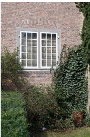
122 Bouwdeel 1. Zuidgevel met venster van de kluiskamer (bij Kamer van Charitate).
