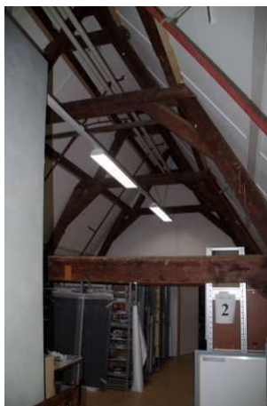
146 Zolderruimte 202 met dubbel juk en A-spant van de kap in het zicht.
