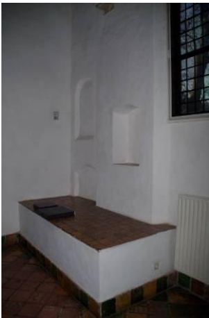
235 Bouwdeel 8, ruimte 2p, de kapittelzaal met verhoging in de zuidwesthoek ten behoeve van de keldertrappen; erboven dichtgezette vensternissen van oudere vensteropeningen.
