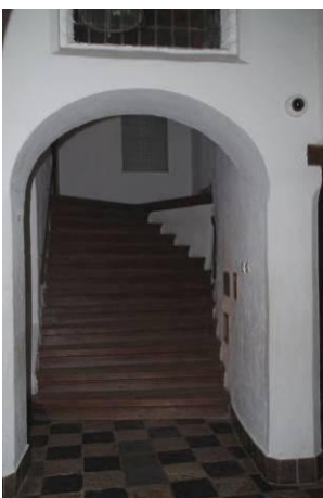
175 Ruimte 7a, de Moordhal. Eerste deel van de trap naar de verdieping met boven de boogdoorgang het venster en rechts op de muur de kogelgaten en gedenksteen.
