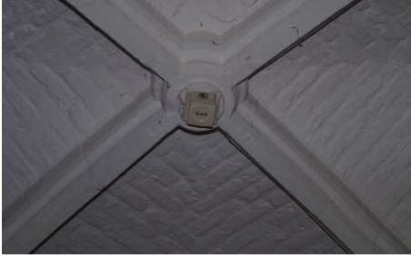
272 Bouwdeel 10. Vernieuwd kruisgewelf met ingebouwd stopcontact.
