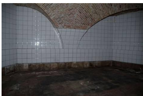
231 Bouwdeel 8, ruimte 08a, kleine kelder.
