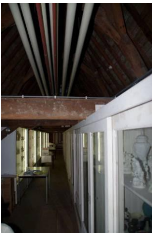
226 Bouwdeel 7, ruimte 209, zolder met porseleinkasten. Zicht op het onderste juk van de kapconstructie.
