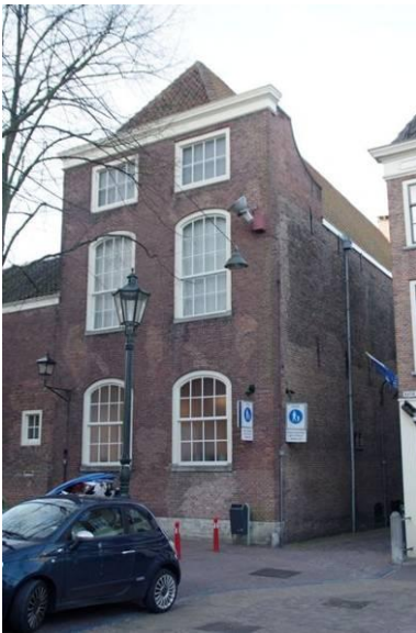
12 Bouwdeel 5 op de hoek van de Oude Delft en de Schoolstraat met zijn in 1775 aan de voorzijde vernieuwde gevel.
