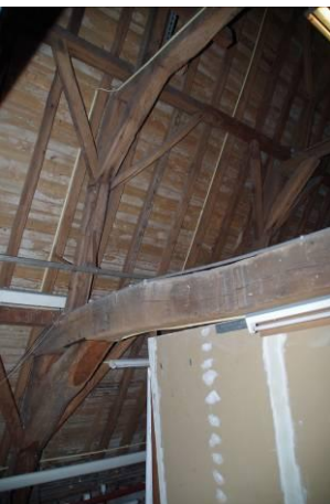
327 Kap bouwdeel 4. Overzicht stapeling middelste juk op onderste juk.
