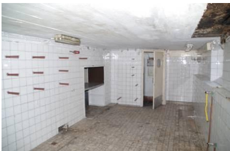
164 Kleine kelder met betonnen zoldering.
