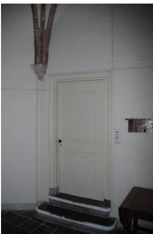
319 Consistorie, ruimte 38. Toegang vanuit het ingangsportaal tot de kerk.
