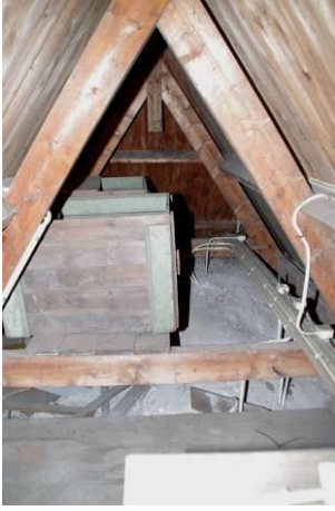
323 Interieur dwarskap boven het gewelf in het ingangsportaal van de consistorie.
