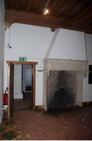
249 Bouwdeel 9, ruimte 3p, spinkamer met schouw aan de westzijde.
