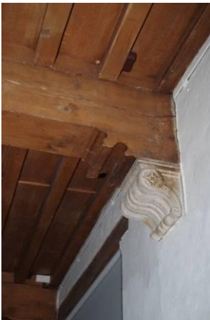
193 Ruimte 16p. Detail laatgotisch sleutelstuk met peerkraalmotief en zandstenen console in vroegrenaissance motief (sleufbandornament).
