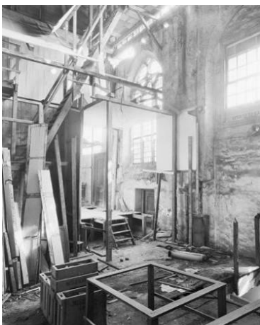
101 Interieur van de Waalse Kerk tijdens de restauratie. (Herkomst: RCE, beeldbank)
