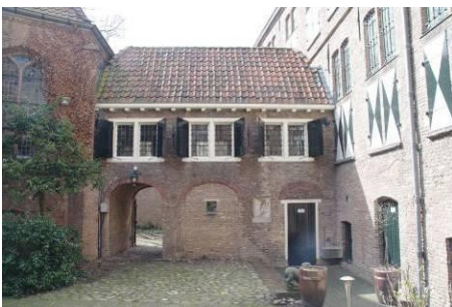
241 Oostgevel van de verbindingsgang met poort tussen de Tweede binnenplaats en de kloostertuin/Prinsentuin, met toiletten op de begane grond en erboven de feitelijke verbinding tussen de bouwdelen 8 en 4.
