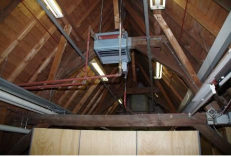
347 Kap bouwdeel 9. Overzicht kapgebint in (donker) grenen. De recente herstellingen tekenen zich af met een lichtere houtkleur.
