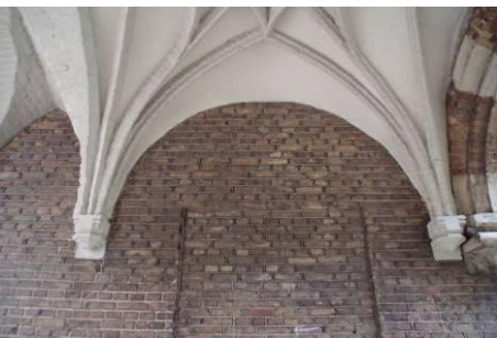
309 Aanzet gewelf in poortdoorgang.
