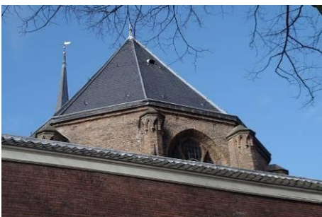
290 Zicht op de koorsluiting (het dak van de consistorie is verlaagd bij de restauratie).
