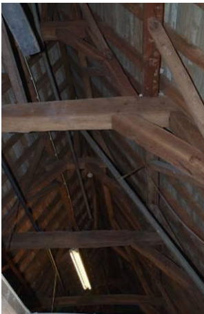
172 Ruimte 204. Zolder met kapconstructie in het zicht.
