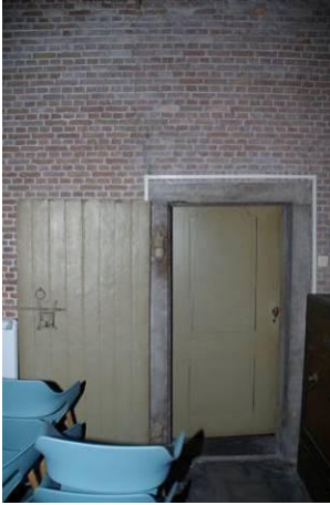
140 Hardstenen binnenkozijn met versterkte binnendeur, gezien vanuit de kluiskamer.
