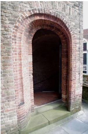
265 Bouwdeel 10, verdieping. In perspectief gemetseld zeventiende-eeuwse deuromlijsting.
