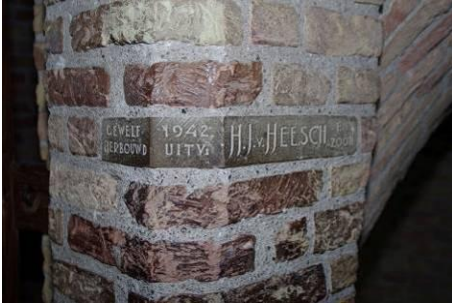
274 Bouwdeel 10. Ingemetselde steen memoreert de herbouw van het bovenste deel van de trap in 1942.
