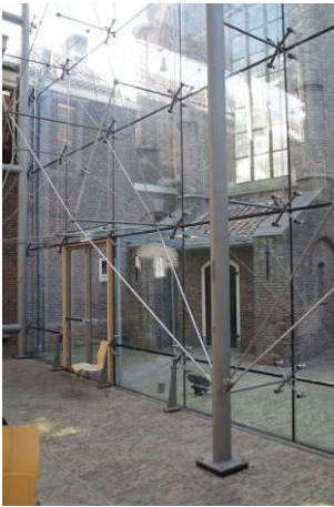
325 Detail van de zuidwand.
