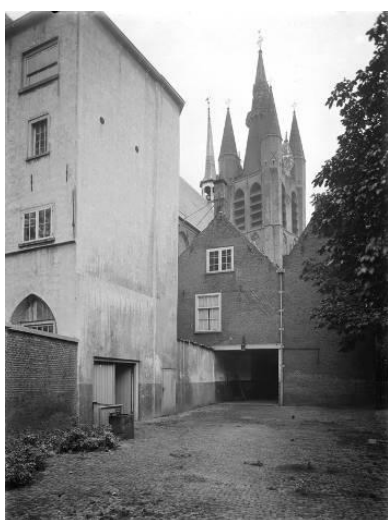
369 Zuidwestzijde van de narthex van de kloosterkerk gezien naar het oosten, op een foto uit circa 1925. Opvallend is de doorgang waarvan de gevel hier nog gelijk ligt met het naastgelegen pand aan de zuidzijde. Ook is de opgaande muur te zien waar achter zich nog de resten van de traptoren bevonden. Maar belangrijk is de eenvoudige dubbele deuringang door de militairen gemaakt aan de zuidzijde van de narthex. (Herkomst: RCE, beeldbank)
