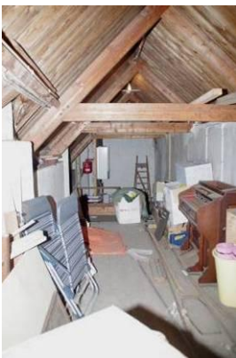
322 Interieur zolder boven de consistorie gezien richting het zuiden. Achter de muur bij de CV bevindt zicht de tussenwand met de bibliotheekkamer van ruimte boven de poort de behoort bij Oude Delft 177.
