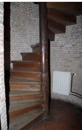
217 Bouwdeel 7. De traptoren (ongenummerd) met houten spiltrap, waarvan de spil oud is.
