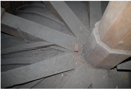
339 Kap Waalse Kerk. Voet koningstijl, waarop de dekbalken van de hoekkepergebinten van de koorsluiting aansluiten. Op de stijl staan montagemerken, waarbij de nummering voor de hoekkepergebinten doorloopt op de nummering van de gewone kapgebinten.
