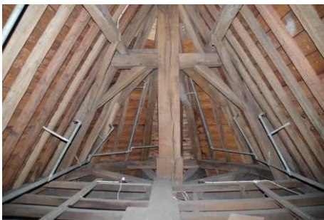
299 Kap Waalse Kerk, gezien richting de koorsluiting met koningsstijl.
