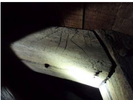
341 Kap Waalse Kerk. Montagemerk op een van de bovenste jukken. Het betreft het gebroken merk VI<II (9), waarin dus maar één van de vier strepen is gebroken.
