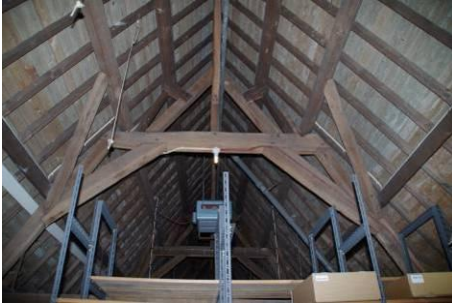
239 Bouwdeel 8. Zicht op de kapconstructie met gestapelde jukken en nokgebint.
