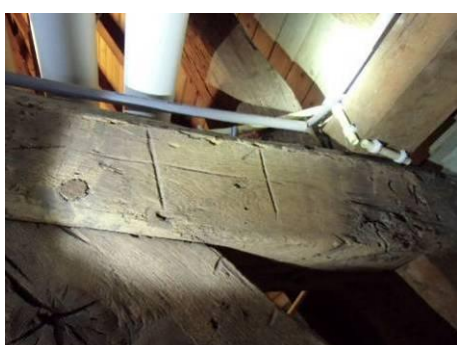
331 Kap bouwdeel 4. Transportmerk op een van de dekbalken van de onderste jukken. Geheel rechts is het montage-merk CX (11) te zien.
