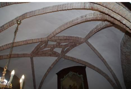
313 Consistorie, ruimte 37. Een van de stergewelven uit circa 1525.
