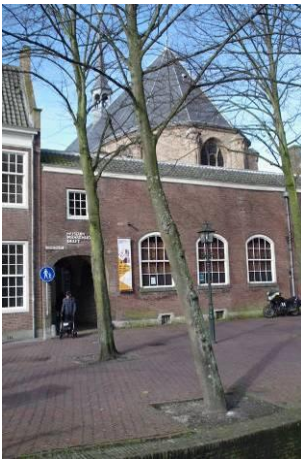
304 De consistorie gezien vanaf de Oude Delft met drie schuifvensters in de oostgevel.
