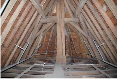
338 Kap Waalse Kerk. Overzicht bovenste juk en koningstijl met hoekkepergebinten bij de koorsluiting.
