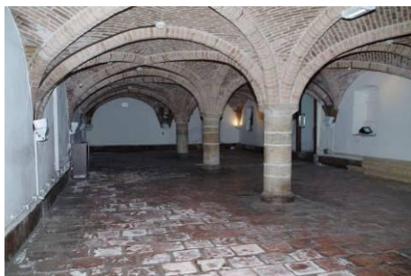
230 Bouwdeel 8, ruimte 08, grote kelder.
