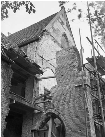
90 De noordwestzijde van de narthex tijdens de restauratie waarbij op de verdieping nieuwe gewelven zouden worden geslagen en in de hoek met de kapittelzaal (links) een travee aan de narthex zou worden toegevoegd. (Herkomst: RCE, beeldbank)
