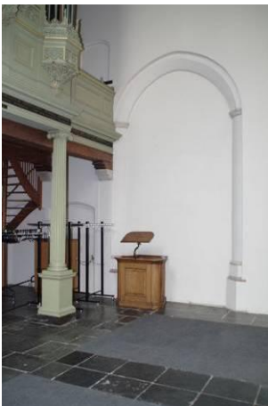
298 Waalse Kerk, ruimte 13, dichtgemetselde doorgang in de noordwand naar abdissenkapel.
