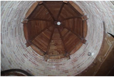
256 Bouwdeel 9. Houten gewelf in de traptoren.
