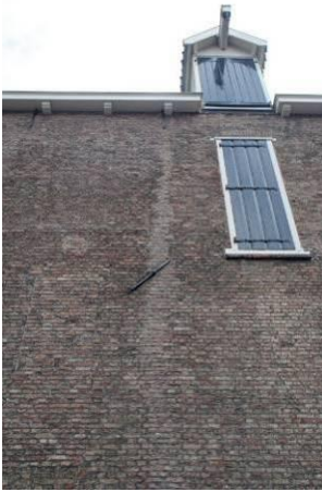
156 Kloostervenster en hijsluik (restauratiewerk) met links daarvan bouwspoor van ouder venster onder een uitgebroken segmentboog.
