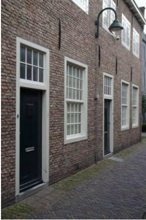
120 Bouwdeel 1. Noordgevel met gereconstrueerde deuren en vensters.
