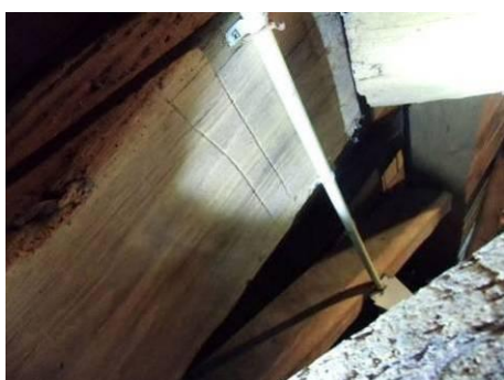
330 Kap bouwdeel 4. In de korbeldriehoeken bij drie van de onderste jukken zijn gesneden montage-merken te zien.
