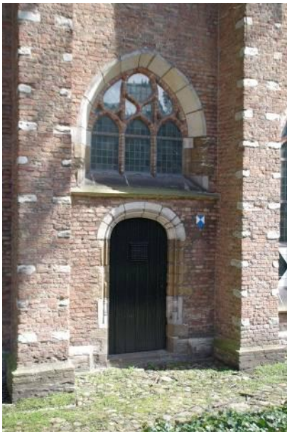
371 Huidige situatie van de ingang tot de narthex met laatgotische omlijsting en randprofilering en daarboven een kloostervenster met baksteentracering.
