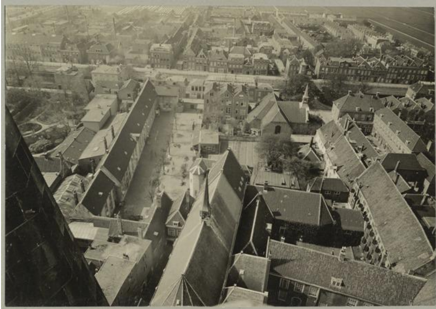
64 Overzicht van het complex vanaf de toren van de Oude Kerk, nog met de zeventiende-eeuwse aanbouw van de Waalse Kerk (midden onder) en de Armenkerk (boven). Foto ongedateerd, vóór 1918. (Herkomst: RCE, beeldbank)
