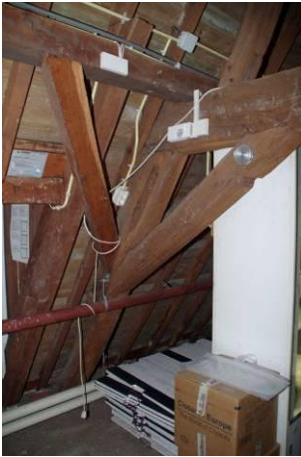
225 Bouwdeel 7, ruimte 209, detail kapconstructie.
