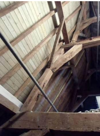
326 Kap bouwdeel 4. Stapeling bovenste en middelste juk op onderste juk (dekbalk onder in beeld). Het middelste juk heeft gehakte montagemerken.
