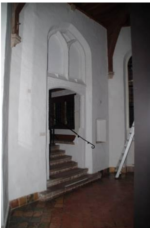
236 Bouwdeel 8, ruimte 2p, de kapittelzaal. Trapopgang in de noordgevel (koor) naar de gedachtengang; Het venster erboven was oorspronkelijk een groter spitsboogvenster.
