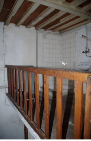
165 Bij restauratie ingebouwd trapportaal aan de westzijde van de keuken, gelegen binnen bouwdeel 2.
