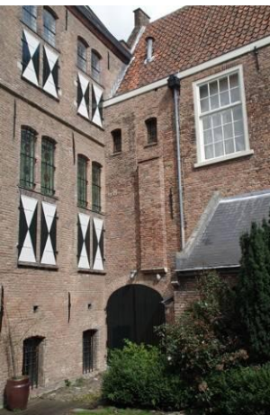
61 De noordoosthoek van de Tweede binnenplaats nu (vergelijk afb. 60). Een deel van de uitgebouwde schoorsteen is zichtbaar, met daarboven twee nieuwe kleine (wc-) vensters. De toegang tot de kelder en het gerestaureerde venster daarboven zijn vervangen door een op de traptoren aansluitende wc-aanbouw. Ook is de poort met wagendeur toegevoegd.
