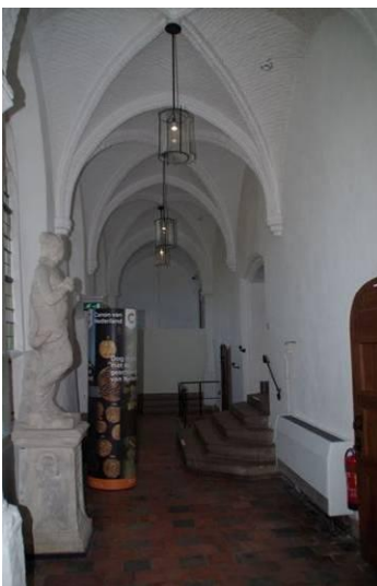
4 De kruisgang op de begane grond van de narthex (bouwdeel 10) met rechts de toegang tot de lakenhal (bouwdeel 11).
