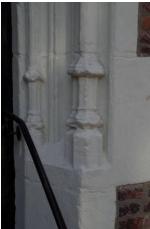
184 Bouwdeel 5, zuidgevel. Detail (wit gesausd) van het basement van de natuurstenen omlijsting.
