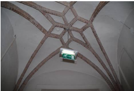
318 Consistorie, ruimte 38. Deel stergewelf in het ingangsportaal.
