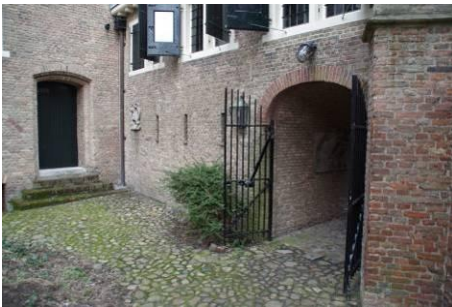
240 Begane grond van de westgevel van de verbindingsgang ('gedachtengang'), in de huidige vorm ontstaan bij de restauratie door Lansdorp.
