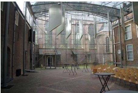
288 Zicht op de noordgevel van de kerk vanuit de Van der Mandelezaal. De huidige gevel is ontstaan nadat de zijbeuk was weggebroken en restauratie van de gevel door Lansdorp.
