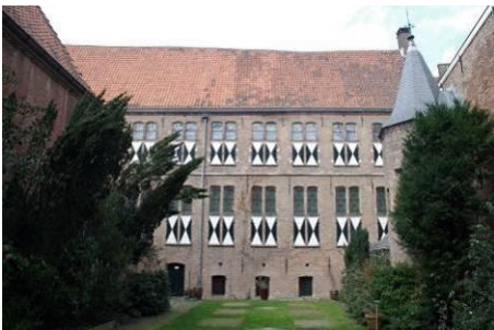
158 Oostelijk deel van de zuidgevel van bouwdeel 4.
