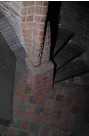
254 Bouwdeel 9, ongenummerde ruimte. De vet van de gemetselde spiltrap.
