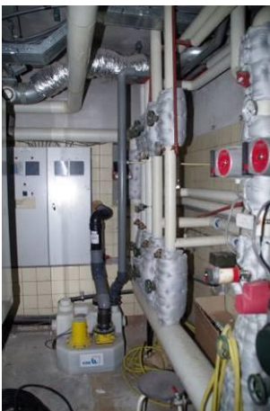
187 Installatieruimte; vloer- en wandtegels uit jaren veertig.
