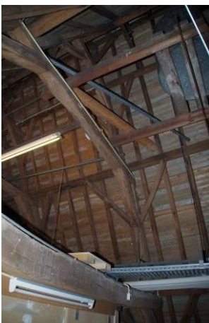
173 Ruimte 204. Deel kapconstructie met korbeelstellen van de drie gestapelde jukken.
