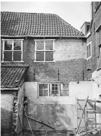
86 Een deel van de oostgevel van bouwdeel 3. (Herkomst: RCE, beeldbank)
