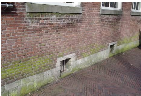
305 Consistorie. Kelderlichten in de plint van de oostgevel.
