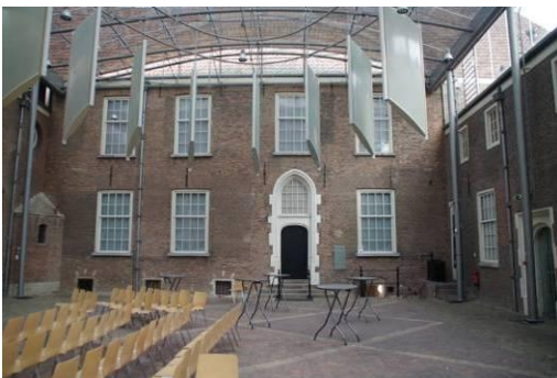
182 Bouwdeel 5. Zuidgevel aan de overkapte binnenplaats.
