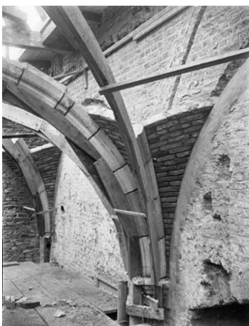
91 De nieuw gestelde ribben van de overwelfing op de verdieping van de narthex. (Herkomst: RCE, beeldbank)
