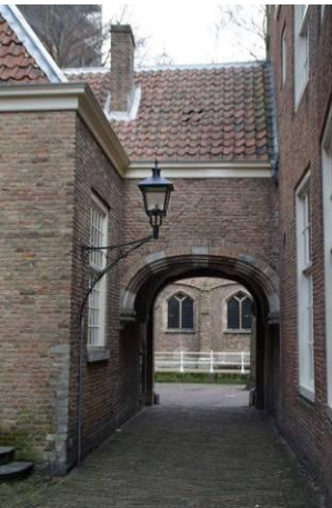
308 Poort, gezien vanuit het westen.
