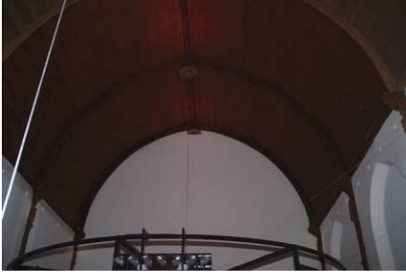
286 Bouwdeel 11, ruimte 22p, het houten tongewelf.
