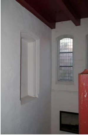
160 Oostgevel van bouwdeel 4 met blinde vensternis; thans binnenmuur in het tussenlid met hooftrappenhuis.
