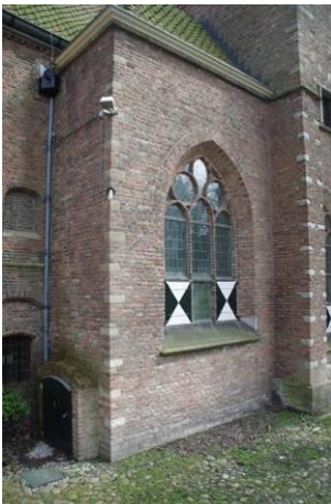
264 Bouwdeel 10. Gereconstrueerde zijtravee van de voorhal.
