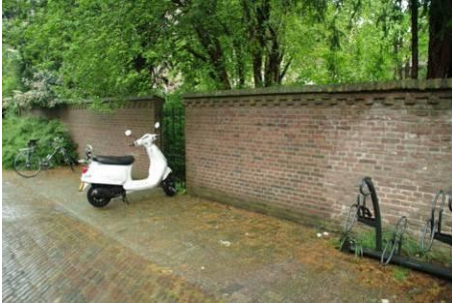
113 Deel van de tuinmuur aan de westzijde met bij het fietsenrek het bouwspoor van de - na de sloop van de Armenkerk in 1966 - herstelde muur (links) en de oude muur (rechts).
