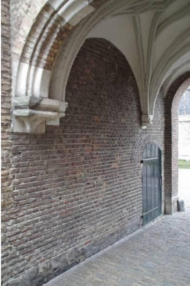
8 Detail doorgang naar de Oude Delft naast de sacristie met laatgotische console en kruisribgewelf.
