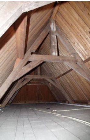
153 Kapconstructie met uitsparing aan de binnenzijde van de spantbenen.
