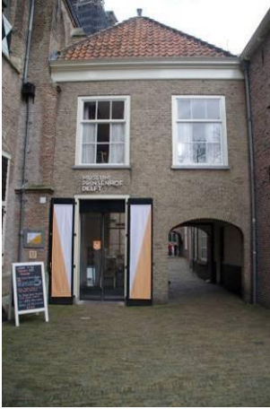
278 De poortwoning ten zuiden van bouwdeel 11, gezien vanuit het westen.
