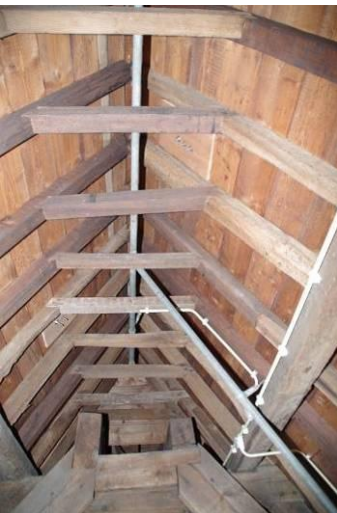
344 Kap Waalse Kerk. Daksporen in de nok. De sporenparen zijn verbonden met haanhouten.
