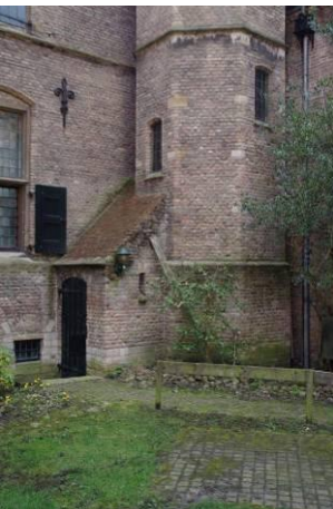
245 Bouwdeel 9. Gereconstrueerde traptoren met aangebouwd portaal met trap naar de kelder.
