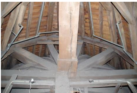
300 Kap Waalse Kerk, de constructie boven het koor.
