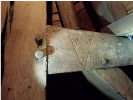
340 Kap Waalse Kerk. Transportmerk op dekbalk nabij de koningstijl.
