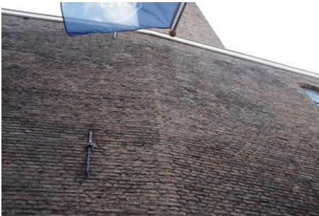
181 Bouwdeel 5, noordgevel. Op de overgang van bouwdeel 5 naar het tussenlid is een lichte knik zichtbaar; erachter bevinden rookkanalen waarvan de schoorsteen boven het dak uitsteekt.
