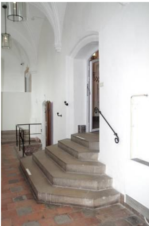
269 Bouwdeel 10, ruimte 12. Trap naar de lakenhal in bouwdeel 11.
