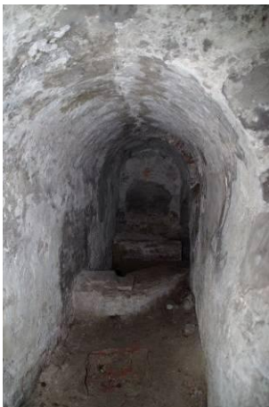
310 Ruimte 012. Keldergang met afgesloten uiteinde aan de noordzijde.
