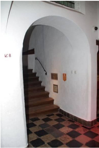
11 Het trappenhuis naast de Historische Zaal met in de muur de kogelgaten van de aanslag.
