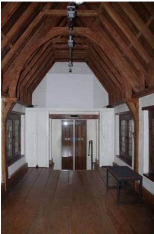
242 Ruimte 9p, de verbindingsgang, gezien in noordelijke richting.
