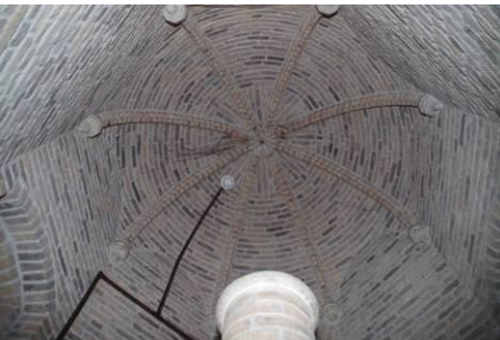
251 Bakstenen gewelf van de gereconstrueerde traptoren.
