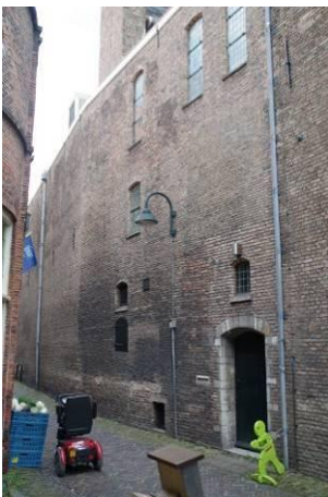
174 Noordgevel van het tussenlid aan de Schoolstraat.
