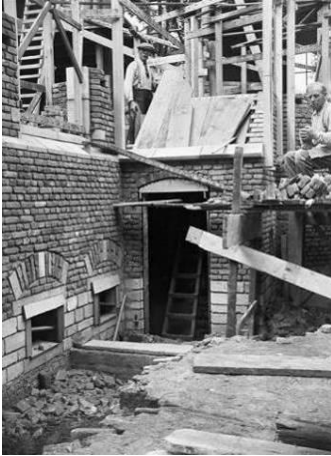
93 Metselwerk aan de nieuwe gevel en traptoren ter plaatse van de gereconstrueerde spinkamers. (Herkomst: RCE, beeldbank)
