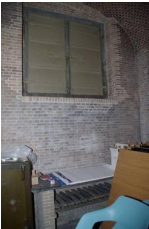
141 De zuidmuur van ruimte 13 met in 1761 ingebroken venster met rondom hersteld metselwerk en voorzien van ijzeren binnenluiken en diefijzers aan de buitenzijde. Bovenaan rechts is aanzet van gemetseld gewelf zichtbaar.
