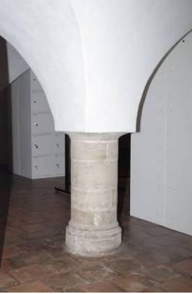
280 Bouwdeel 11, ruimte 011, kelder.
