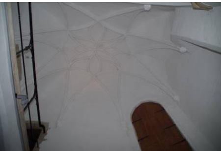
253 Bouwdeel 9, ruimte 4, met wit gesausd stergewelf en links de galerij.
