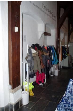
284 Bouwdeel 11, ruimte 14, noordwand met blinde nissen.
