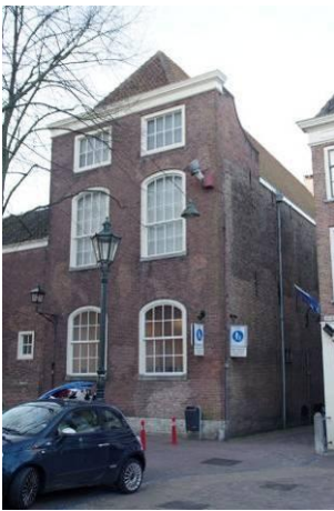
180 Bouwdeel 5. Noordgevel met aansluiting op de oostgevel aan de Schoolstraat.
