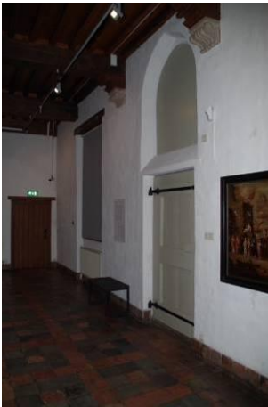
191 Ruimte 11p, gastenkwartier, met in de zuidwand een houten deur, voorzien van zware gehengen en spitsboogvormig bovenlicht, als uitgang naar de binnenplaats.
