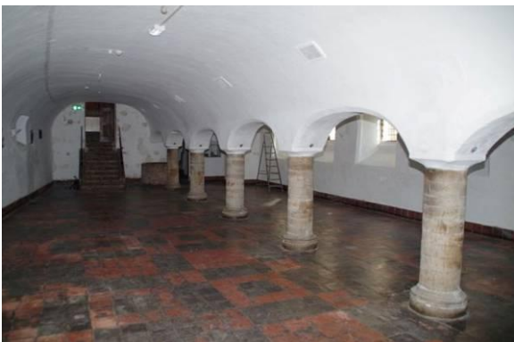
16 De kelder in bouwdeel 4 onder de Historische Zaal met rij zuilen waarop gordelbogen.
