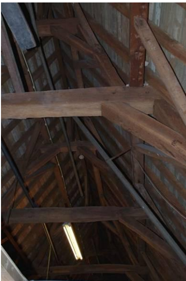
19 Deel van de imposante kap met drie gestapelde jukken en een nokgebint in bouwdeel 4 boven de Historische Zaal.
