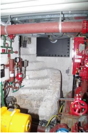
188 Ruimte 05d met aanzet van een gemetselde spiltrap naar de begane grond.
