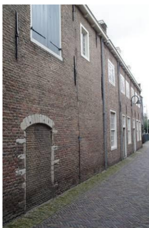
129 Bouwdeel 2. Het meest westelijke deel van de gevel met dichtgezet poortje met omlijsting in Gobertanger steen en ontlastingsboog van een verdwenen vensteropening. Rechts de gevel van bouwdeel 1.
