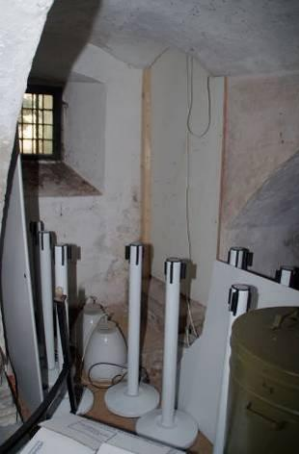
213 Bouwdeel 7, ruimte 07. Vensternis met kelderlicht aan de westzijde van de kelder; achter het houten schot in de nis bevindt zich de vijftiende-eeuwse spiltrap vanuit de Moordhal naar de kelder onder de bij de restauratie door Lansdorp teruggevonden trap naar westelijke binnenplaats.
