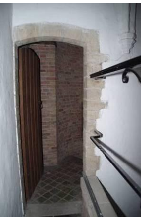
255 Bouwdeel 9. Toegang tot de traptoren ter hoogte van de galerij.
