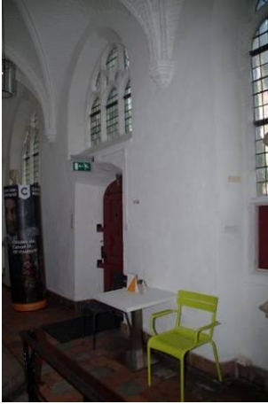
267 Bouwdeel 10, ruimte 12. Westmuur met oorspronkelijke ingangspartij.
