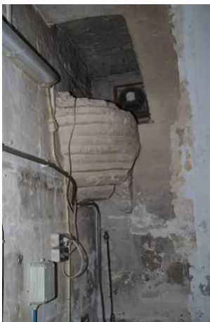
163 Opmerkelijk korfvormig element in de noordwesthoek, mogelijk de onderzijde van een spiltrap.
