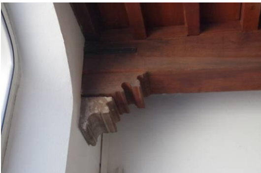
203 Laatgotisch sleutelstuk en console (vermoedelijk restauratiewerk).
