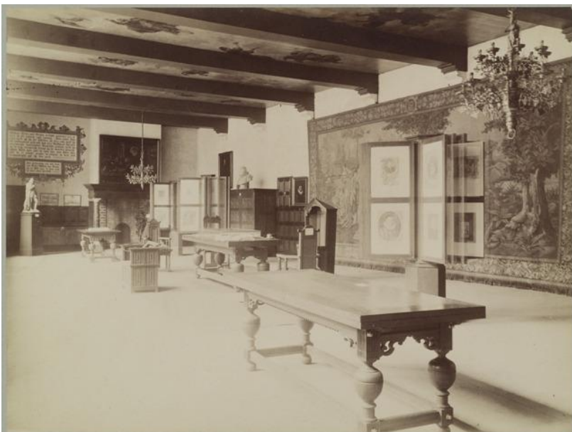
58 De Historische Zaal, foto 1897. (Herkomst: RCE, beeldbank)
