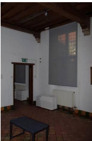
257 Bouwdeel 9, ruimte 20p, gezien naar het westen met doorgang naar ruimte 21p.
