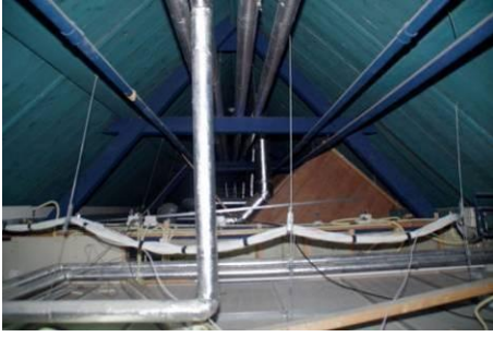
207 Bouwdeel 6, kapconstructie boven het systeemplafond.
