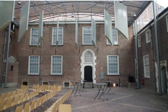
21 De overkapping van de voorplaats (of kruidentuin) uit 1996, gezien naar bouwdeel 5.
