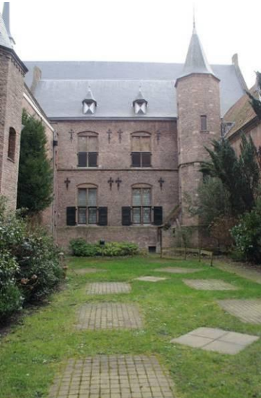
20 De gereconstrueerde gevel (bouwdeel 9) met traptoren, gezien vanuit de Tweede (westelijke) binnenplaats.
