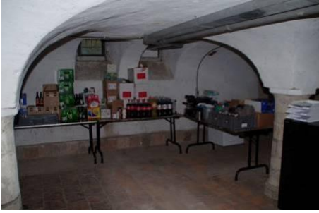
248 Bouwdeel 9, ruimte 09, gezien in noordelijke richting.
