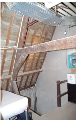
179 Zolder van het tussenlid (ruimte 205) met in de hoek de trapopgang. Het spant is uit dezelfde tijd als de spanten boven bouwdeel 5.
