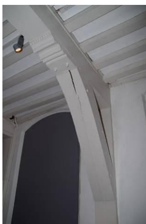
171 Ruimte 15p. Sleutelstuk met laatgotisch peerkraalmotief en vierkante bouten.
