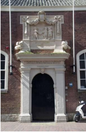
200 Bouwdeel 6, oostgevel met toegangspoort saaihal (1658) en Latijnse school (1775).
