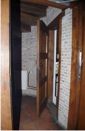
218 Bouwdeel 7. Toegang tot een van de nieuw aangebouwde toiletten vanuit de traptoren.
