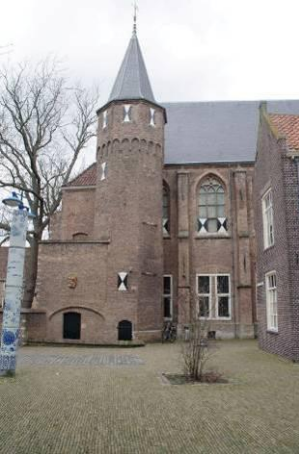
260 Bouwdeel 10. Voorhal of narthex met traptoren, gezien vanuit het zuiden met gereconstrueerde ingang tot de narthex.
