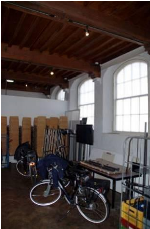
202 Bouwdeel 6, ruimte 26, gezien in noordelijke richting
