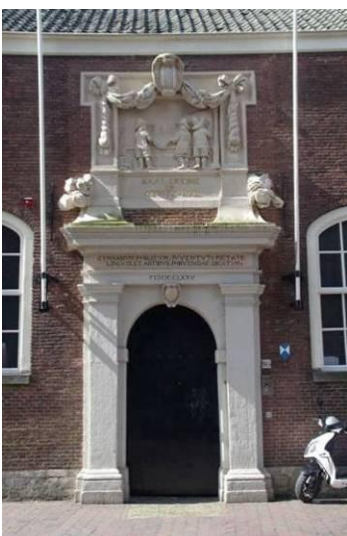
13 Het zandstenen poortje van de saaihal uit 1658 aan de Oude Delft, in 1775 aangepast en herplaatst.
