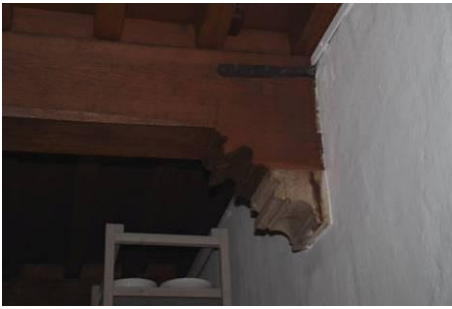
223 Bouwdeel 7, ruimte 18p, detail sleutelstuk en console.
