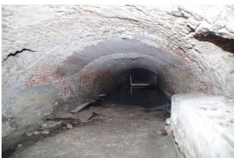
311 Ruimte 012. Keldergang onder de weg naar het water van de Oude Delft.
