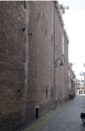
154 De nagenoeg blinde noordgevel aan de Schoolstraat.
