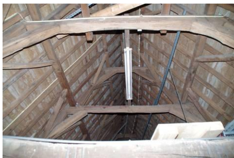
328 Kap bouwdeel 4. Overzicht bovenste jukken.
