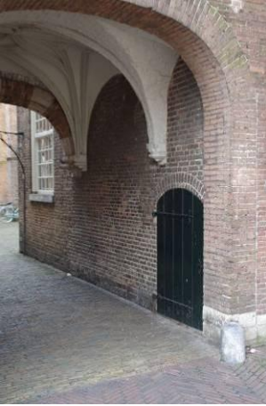
306 Consistorie. Zuidgevel in de poort met toegang tot de keldergang.
