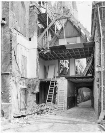
103 Vernieuwing van het tussenlid bij de huidige toegang tot het museum in het kader van de restauratie van de Waalse Kerk in 1961. (Herkomst: RCE, beeldbank)
