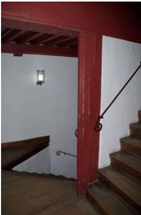
177 Kozijnpost met sponning halverwege de trap.
