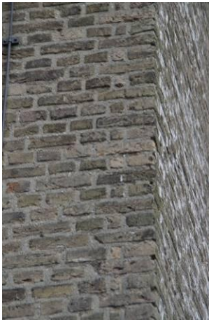
148 Hoekklezoren in het metselwerk op de verdieping aan de zuidzijde.
