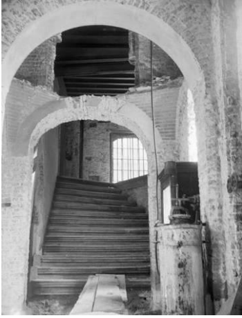
87 De onttakelde Moordhal in 1940. (Herkomst: RCE, beeldbank)
