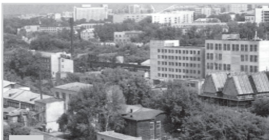
Производственные корпуса «Химпласта»
