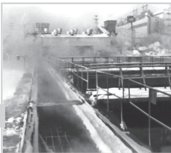
Очистные сооружения завода
