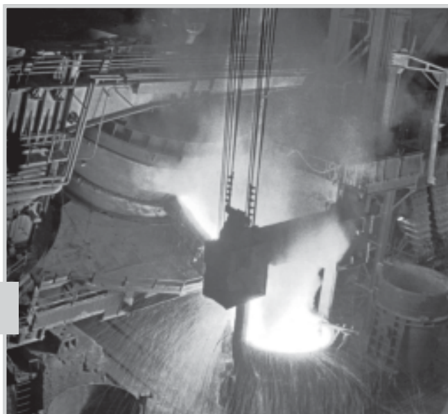
Дуговая сталеплавильная печь ДСП-200
