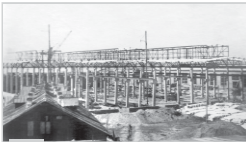
Строительство кузнечного цеха. 1962 г.
