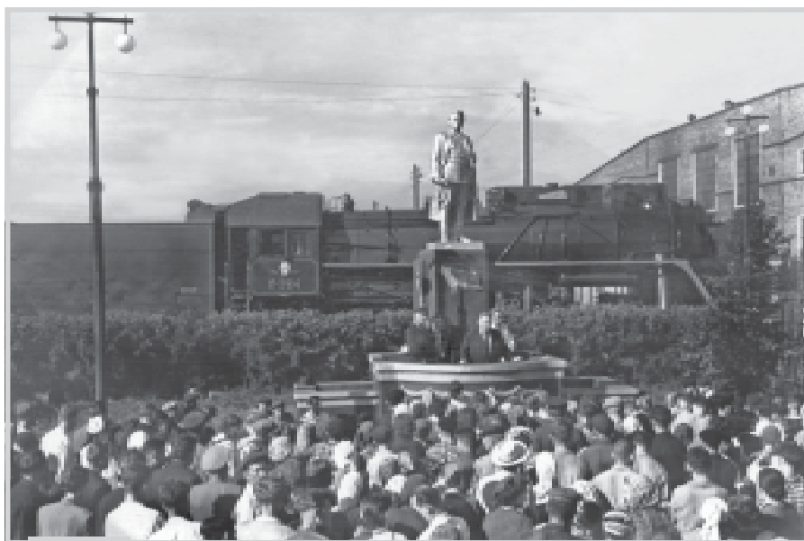
1000-й паровоз, отремонтированный на заводе. 1959 г.
