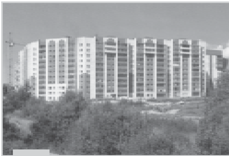
Строительство жилого дома
