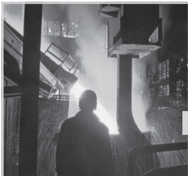
Дуговая сталеплавильная печь ДСП-100
