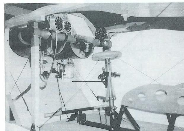
Gesamtübersicht Pilotenraum mit Steuer- und Motorbedienung; oben der Öl- und der Fallbenzintank
