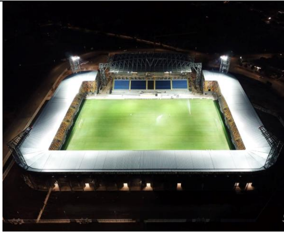
Figura 3 Vista dell'impianto durante le fasi di collaudo illuminazione
