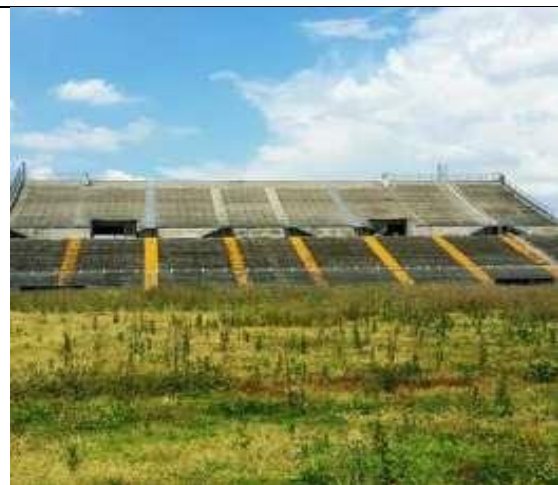
Figura 2 tribuna principale edificata inizi anni '80
