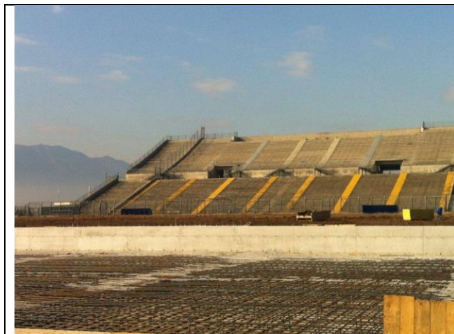
Figura 1 tribuna principale edificata inizi anni '80
