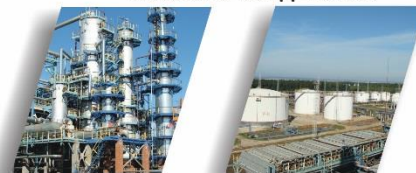
УСТАНОВКА ПЕРЕРАБОТКИ ГАЗОВОГО КОНДЕНСАТА
