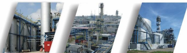
УСТАНОВКА ПО ПРОИЗВОДСТВУ ВОДОРОДА
