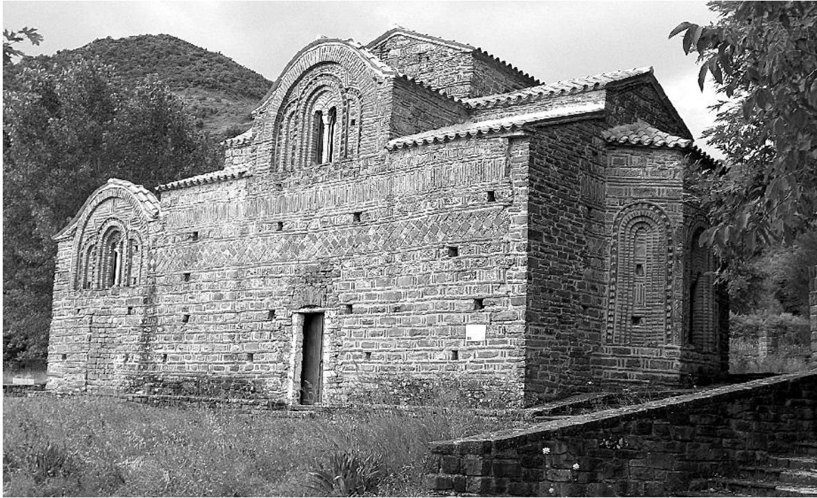
Εικ. 7. Κόκκινη Εκκλησιά. Νοτιοανατολική άποψη.
