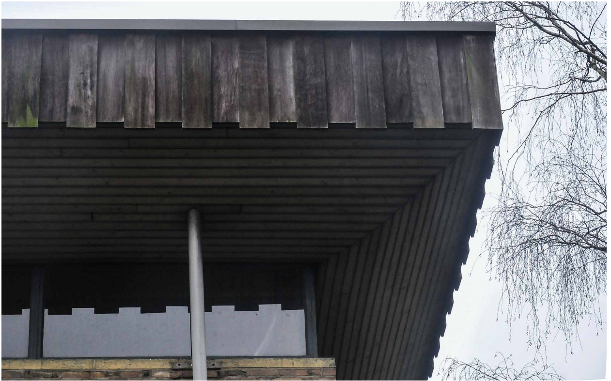
Afb. 4. het overstekende dak boven de horizontale vensterstrook. Foto auteurs.
