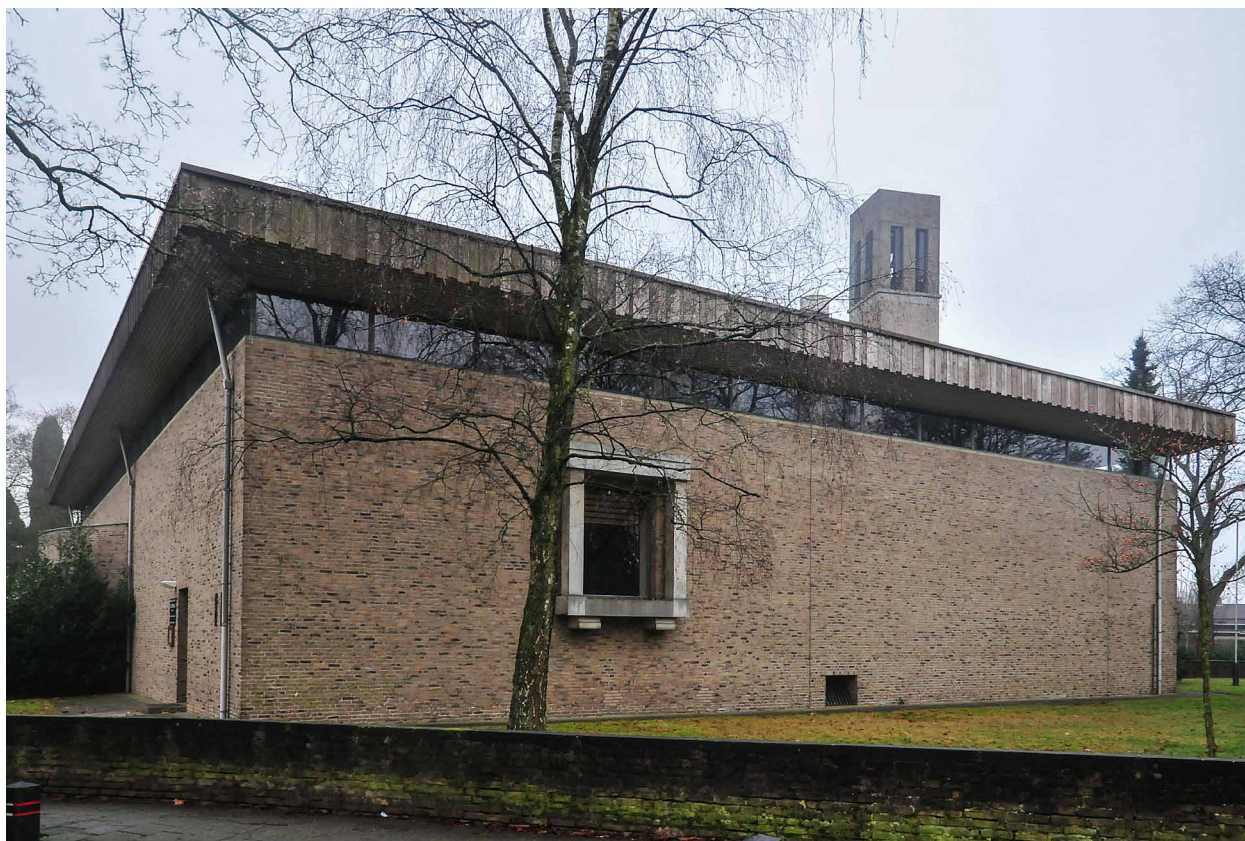
Afb. 9. De kerkzaal gezien vanuit het noorden met links het venster van de gemeenschapsruimte. Foto auteurs.
