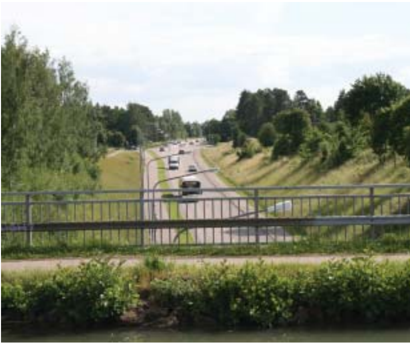
En av kanalens två akvedukter, den i Ljungsbrosjö
