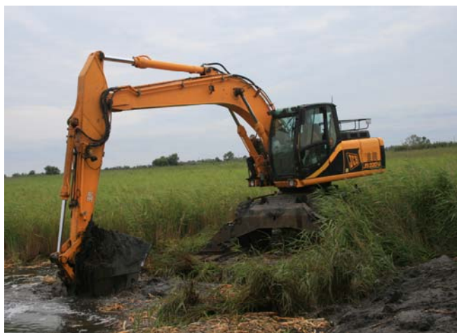
Рис.2. Начало строительства “Water city”
