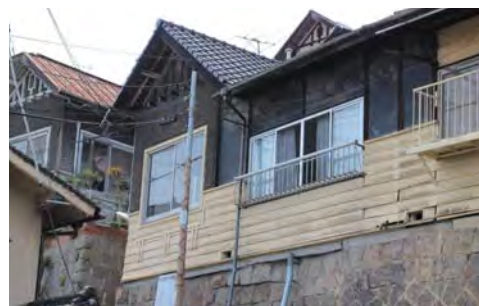
尾道市：官民連携による空き家再生事業(再生物件「坂の家」)
