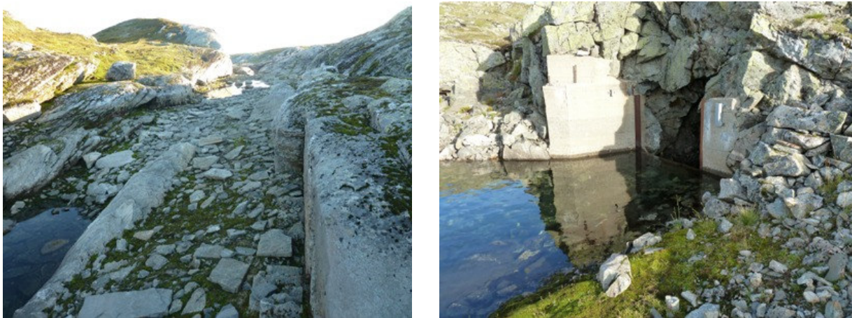
Figur 11.8. Venstre: Dagens utløp av Harkavatnet mot nord ligger omtrent en meter under naturlig vannstand. Høyre: Det naturlige utløpet av Harkavatnet mot Tverrelva er tørrlagt og har grovt substrat, men kan ha hatt små områder egnet for gyting.
