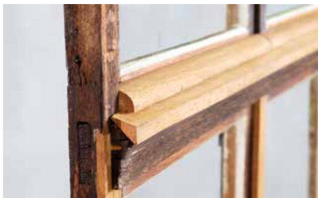
8. Materialgerechte Holzergänzung, bauzeitliches Fenster „Brentanohaus“, Winkel. Foto: Johannes Mosler.
