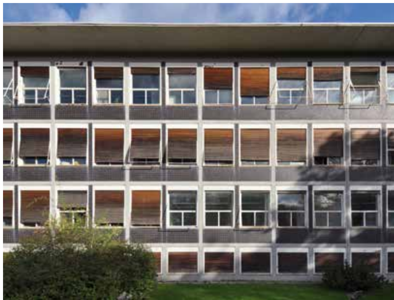
12. Frontfassade des Gebäudes im Zustand 2017. Foto: Daniel Lohmann.
