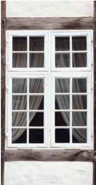
6–8. Kreuzstockfenster des 18. Jahrhunderts (links) und Stulpenfenster mit feststehenden Kämpfer. Fotos: Dorothee Heinzelmann, LVR-ADR.
