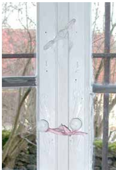
2. Anziehungknöpfe und Vorreiber eines einfachen Fensters des 18. Jahrhunderts mit Bleisprossen. Foto: Dorothee Heinzelmann, LVR-ADR.
