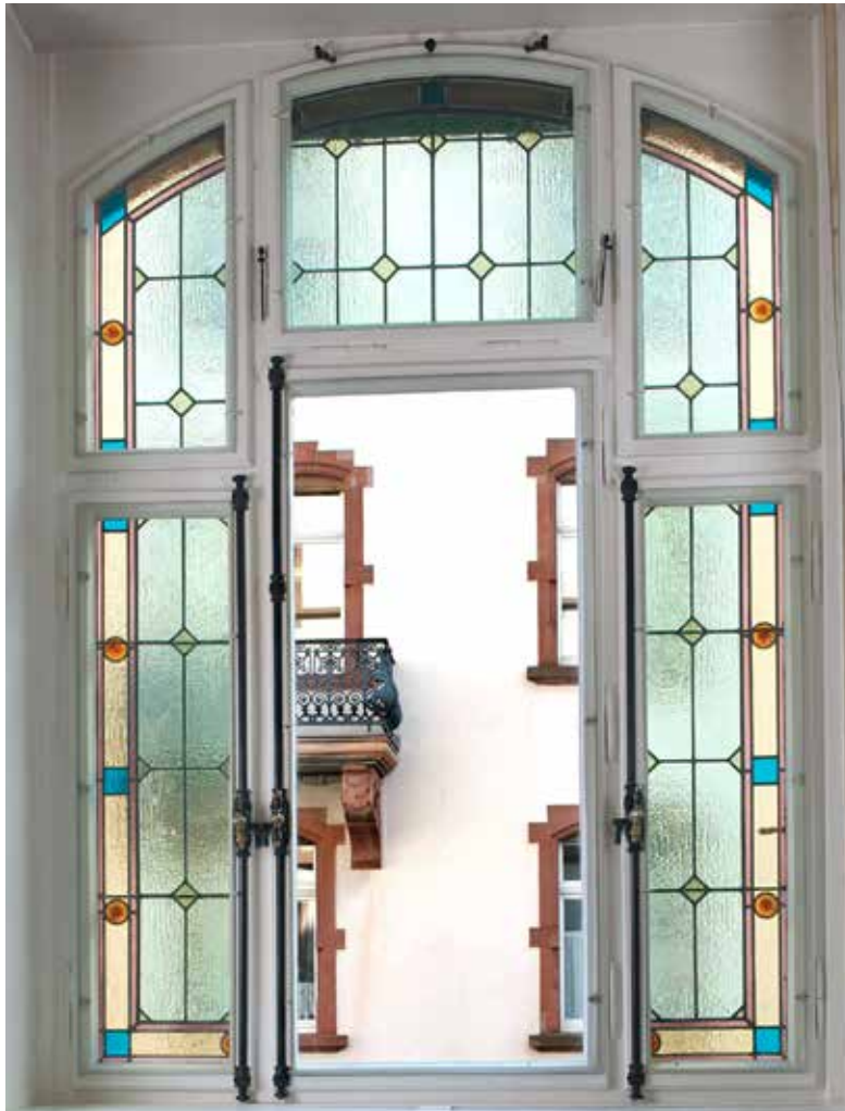
2. Ansicht von montierten Energiespar-Vorsatzscheiben. Foto: Guido Kramp.
