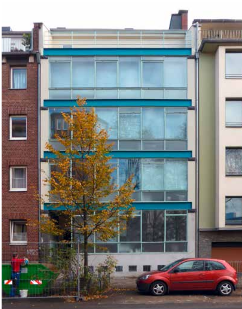
12. Metallfensteranlagen. Foto: Matthias Berg, Stadt Düsseldorf.
