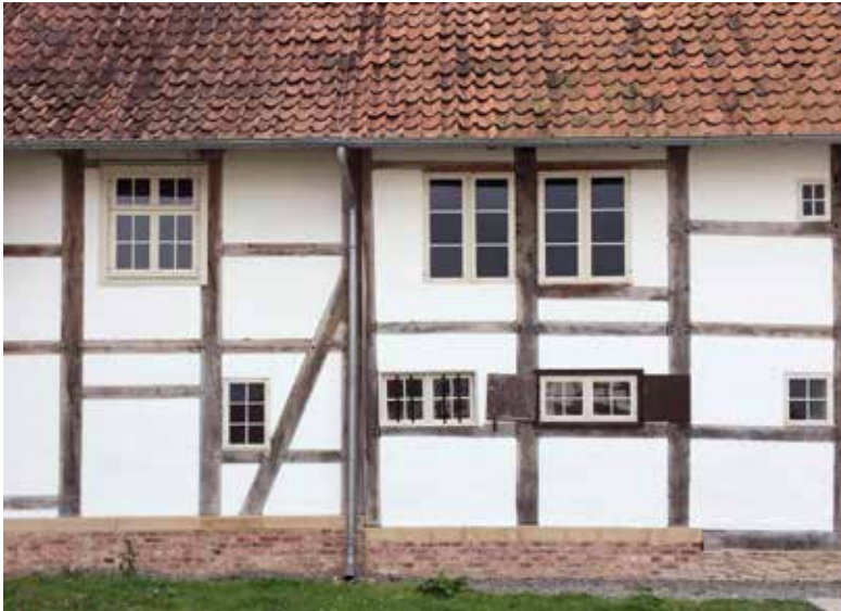
3. Unterschiedliche Anordnung und Größe der Fenster als Spiegel der Baugeschichte. Foto: Dorothee Heinzlmann, LVR-ADR.
