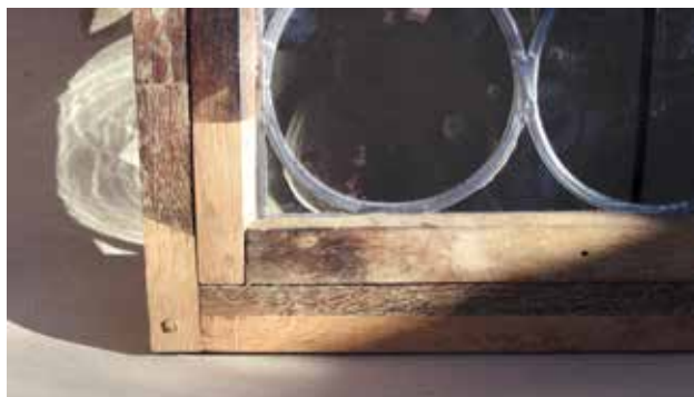
7. Materialgerechte Holzergänzung bei einem Renaissance-Fenster des Hilchenhauses, Lorch, Weltkulturerbe Oberes Mittelrheintal. Foto: Johannes Mosler.
