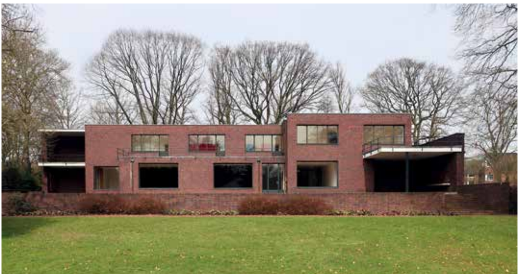
23. Krefeld, Haus Lange, großformatige versenkbare Fenster im Erdgeschoss, Ludwig Mies van der Rohe, 1927–30. Foto: Dorothee Heinzelmann, LVR-ADR.
