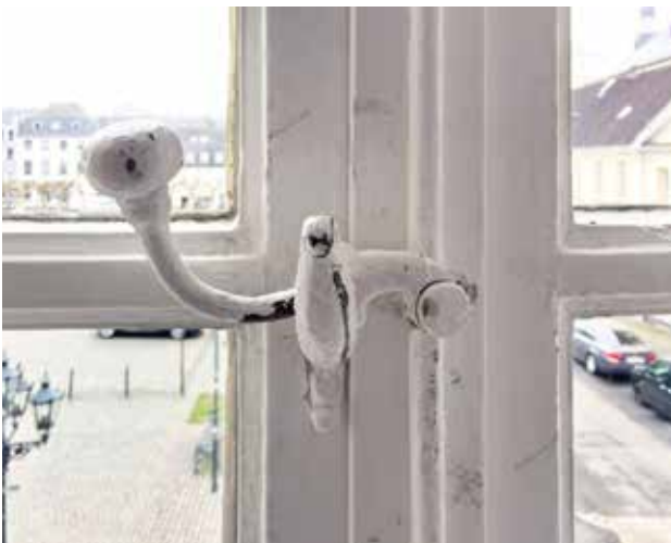
10–11. Espagnoletteverschluss, Ruder (links) und Drehriegelverschluss am unteren Ende (rechts). Fotos: Dorothee Heinzmann, LVR-ADR.
