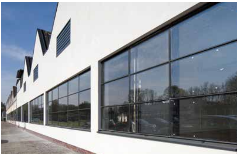
1. Krefeld, Fensteranlagen der ehem. Färberei der Vereinigten Seidenwebereien AG, nach Entwurf von Ludwig Mies van der Rohe, 1931–35. Foto: Silvia Margrit Wolf, LVR-Amt für Denkmalpflege im Rheinland (LVR-ADR), 2016.
