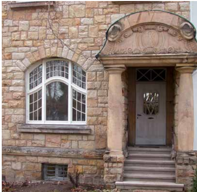
8. Rekonstruiertes Fenster + Restaurierung Hauseingangstür. Foto: Guido Kramp.
