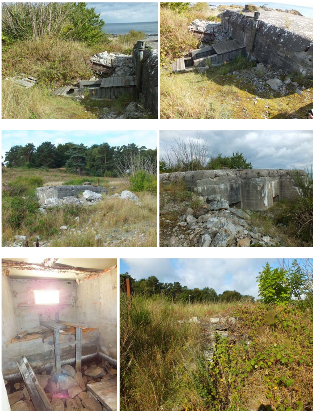
Fotografierna visar värn 49 a ksp II vid Baskemölla samt det norr om liggande skyddsrummet. Överst ses själva ingången till värnet, en träkonstruktion som har varit försedd med en låsbar lucka. De mellersta bilderna visar värnet som idag ligger väl dolt i vegetationen. Nedan till vänster ses delar av interiören, på golvet ligger en ansenlig mängd sten och i utrymmet står också en trasig kamin (syns ej på bild). Bakom vegetationen på bilden nedan till höger döljer sig ingången till skyddsrummet. Platsen var helt övervuxen med taggiga björnbärssnår och det var inte möjligt att ta sig in i skyddsrummet.
