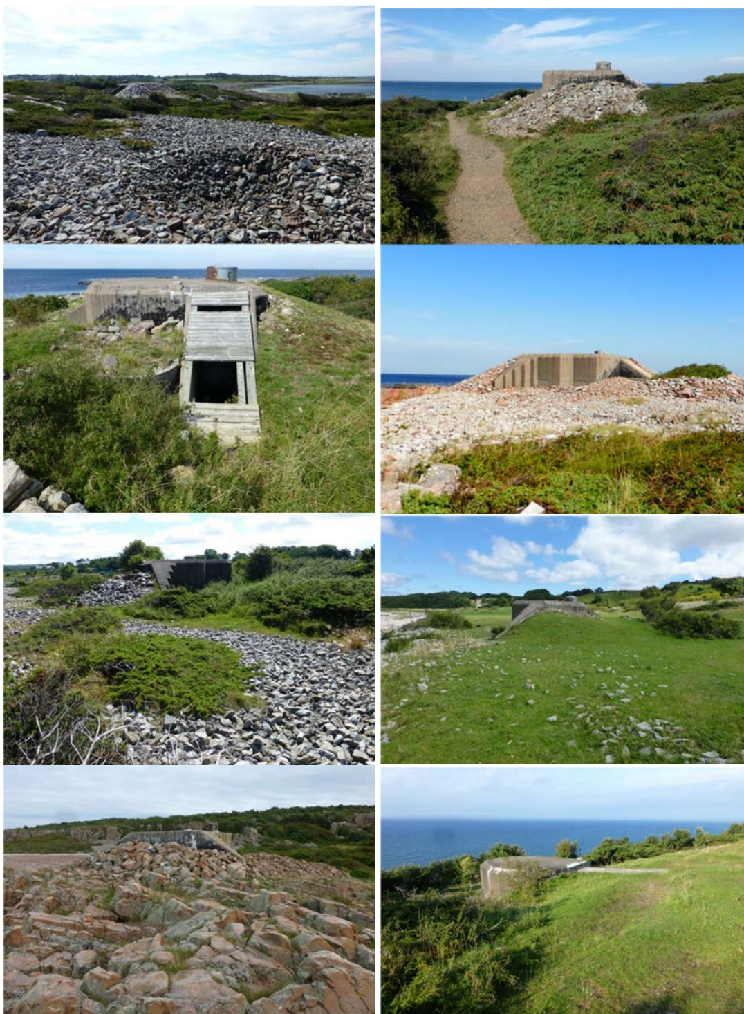
1 & 2 Bjärebalvön. Ovan från vänster visar fotografierna följande värn; 1557 pv sett på håll från norr följt av samma värn med vy från öster, enligt Leif Högberg ett representativt exempel på värn med ett för platsen typiskt sätt att kamouflera med hjälp av sten. 1556 ksp IV, 1558 ksp IV, 1561 ksp IV, 1562 ksp V, 1567 ksp IV, 1568 obs. På bilderna finns samtliga värntyper på sträckan representerade, nere längs strandlinjen ligger kulsprutevärn och pansarvärnskanonvärn och på en höjd – med god utblick över vattnet utanför ligger observationsvärnet. Ksp IV var ett vanligt förekommande värn i Skånelinjen och finns i ett stort antal på Öresundskusten. 1
