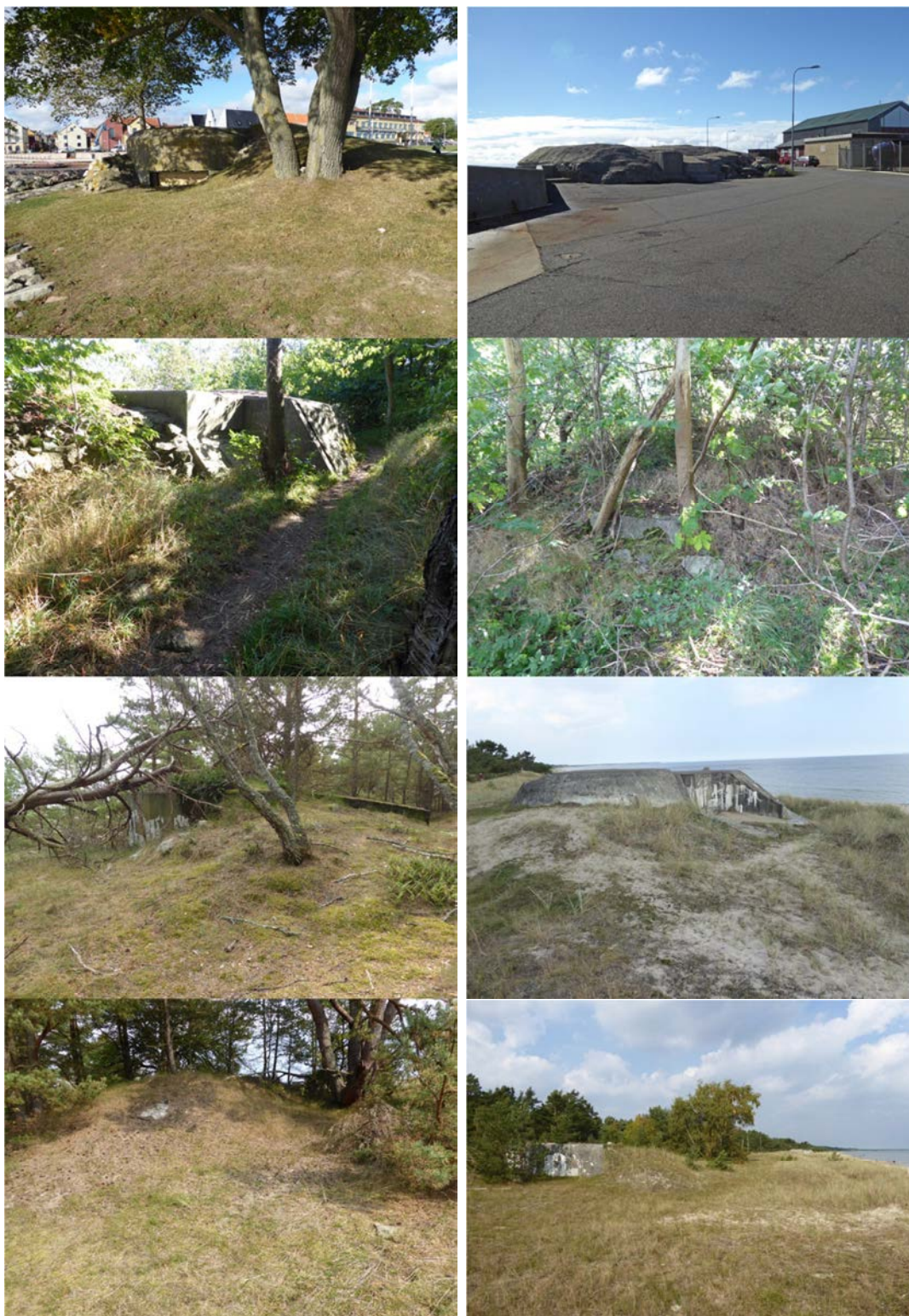
16 Simrishamn, 17 Baskemölla & 18 Gropabålet. De översta bilderna visar två exempel från Simrishamn: 38 kanonvärn, 530 kustkanonvärn, båda väl synliga och tillgängligt placerade. Därunder ses 48 ksp II och skyddsrum i anslutning till detsamma i Baskemölla. Anläggningarna döljs till största delen av grönska och framkomligheten är något begränsad. De fyra sista bilderna visar utseendet i Gropabålet. Med början från vänster ses: 870 obs, 869 ksp IV följt av ett tillhörande skyddsrum placerat väster därom och sist 868 pv. Både synlighet och framkomlighet är varierande vilket framgår av bilderna.
