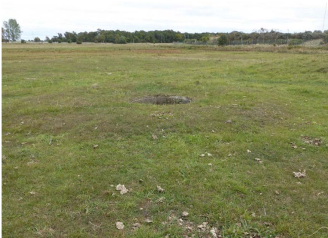
Exempel på ett mindre iögonfallande värn som är lätt att missa för ett otränat öga. Ett så kallat öppet värn som enbart består av ett nedgrävt cementrör. Dessa värn finns utspridda längs med linjen och just detta värn finns i Barsebäck.
