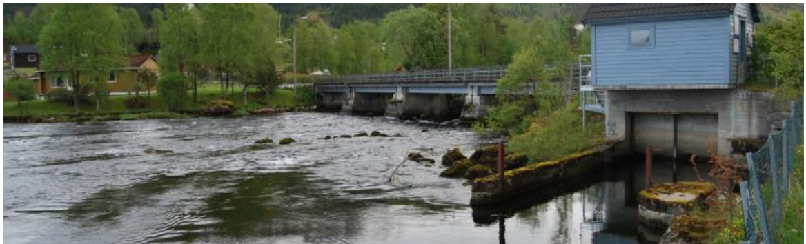
Figur 3. Damanlegg ved Jølstravatnet.
