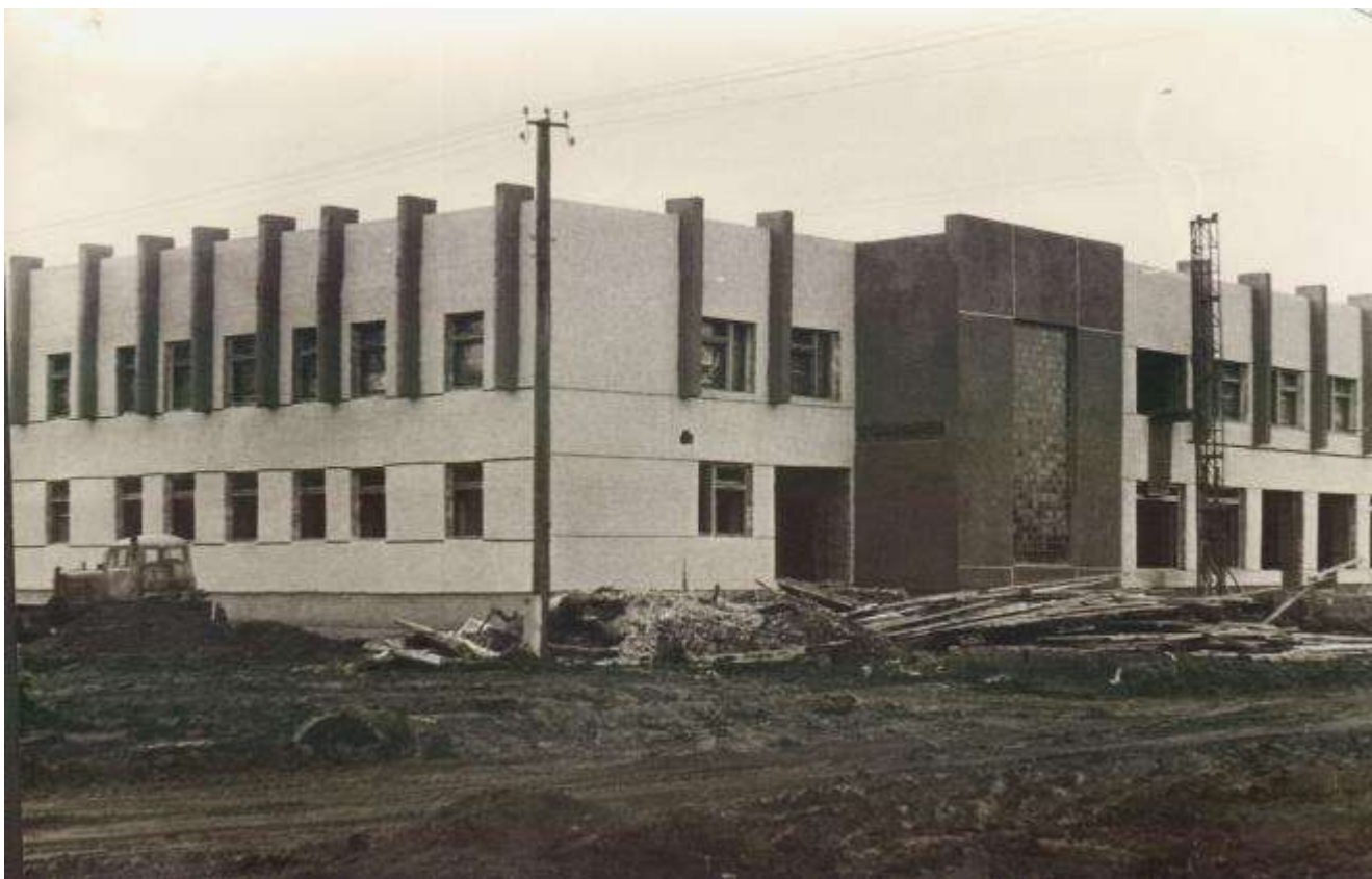
Строительство торгового центра в с. Маргенау. 1989 год
