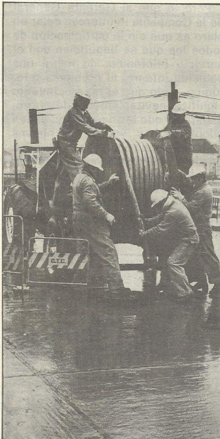
Se trabaja a toda máquina en la ampliación de la Planta Apoquindo, para entregar 8.000 líneas al sector oriente antes de fin de año.
