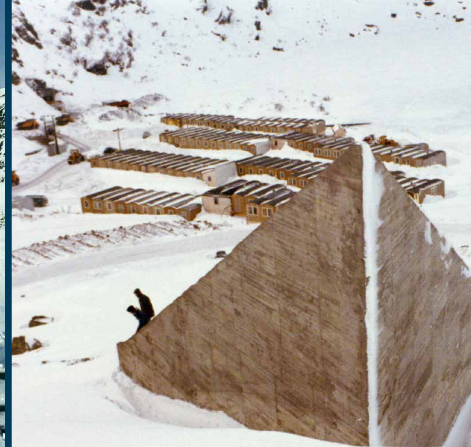
Snøploger ble enkelte steder etablert for å lede skred bort fra brakkeområdene. Her ved Øyestølen.
