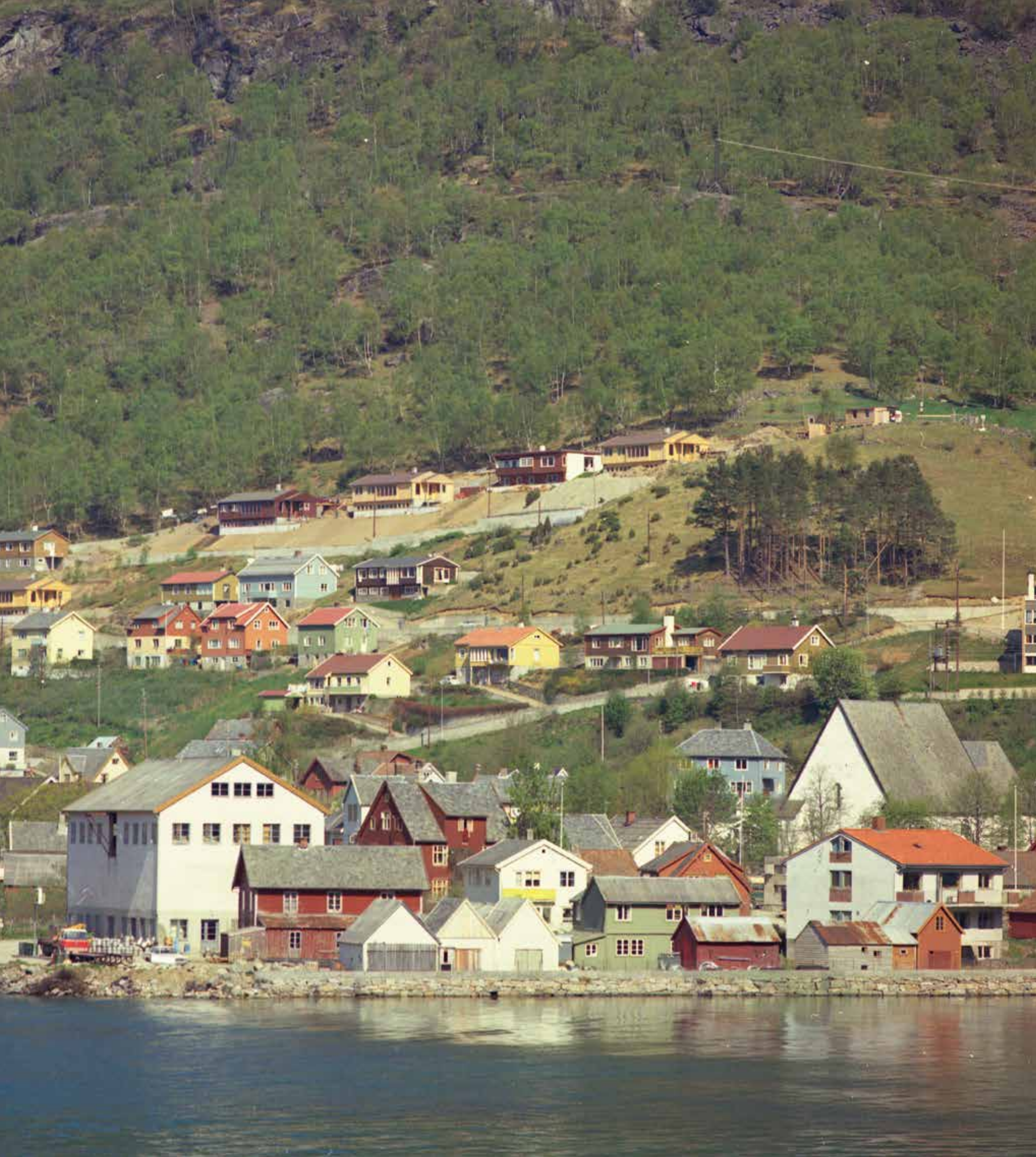
Administrasjonssenteret til Oslo Lysverker legges til Vassbygdi. Bildet er fra byggingen 1974.
