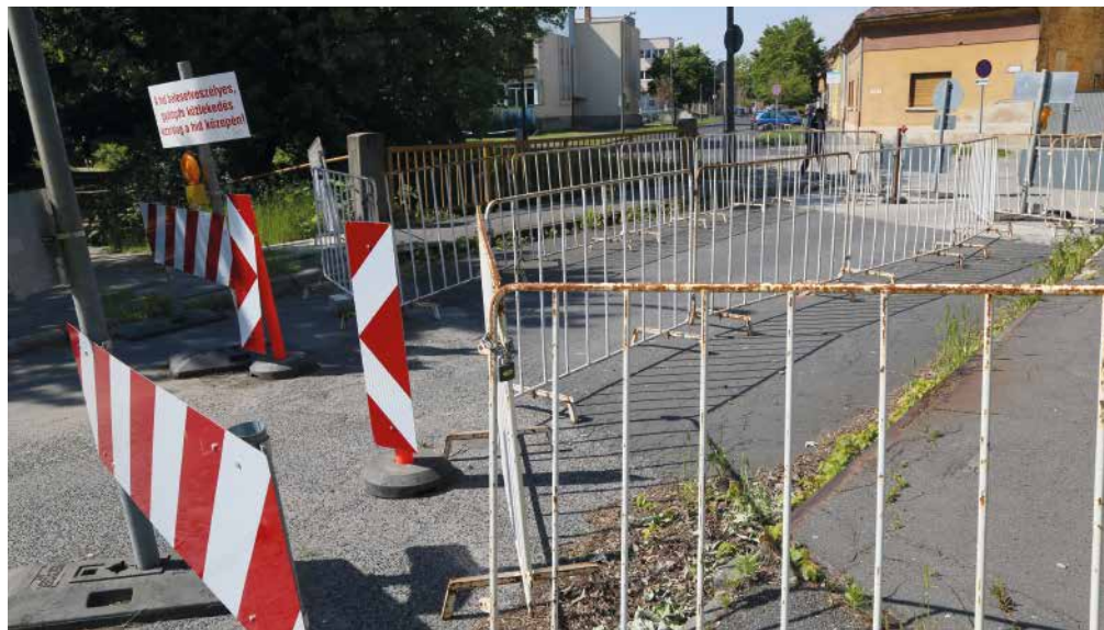
A FELÚJÍTÁS UTÁN KORSZERŰBB ÉS SZEBB LESZ AZ ÁTKELŐ
